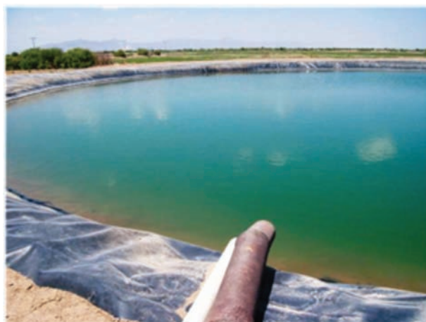
Figura 5.15. Tanque de almacenamiento de la descarga de un equipo de bombeo de pozo profundo, para el riego de una tubería regante de avance frontal.
