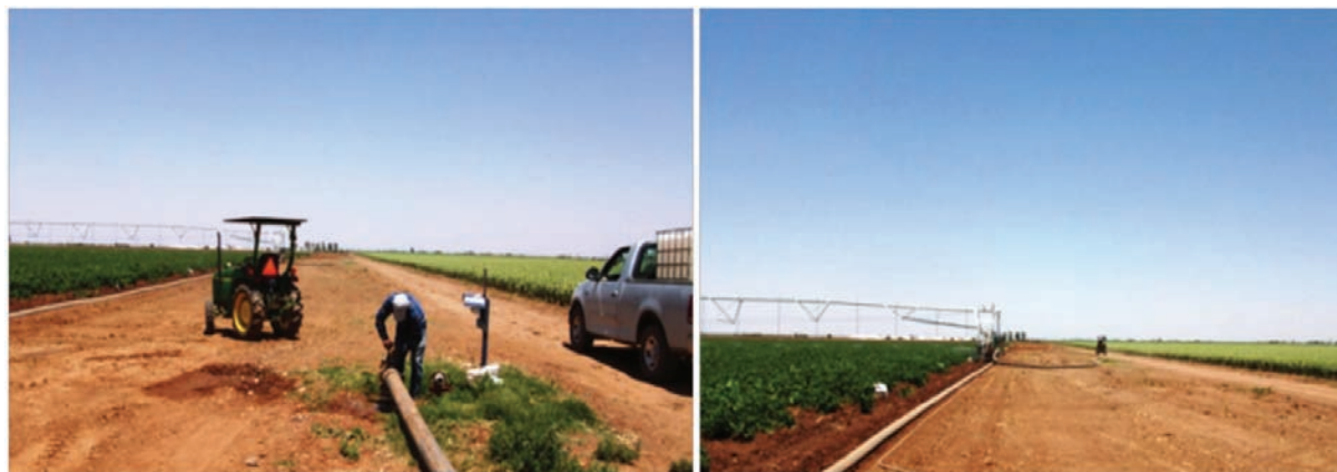
Figura 5.16. Hidrante para el riego de una tubería regante de avance frontal.
