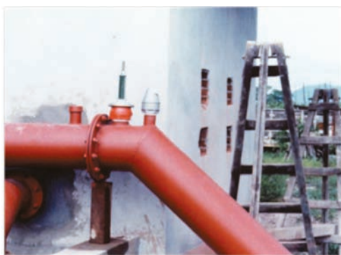
Figura 4.9. Integración de válvula de alivio de presión, con válvula de admisión y expulsión de aire, en las funciones de seguridad.
