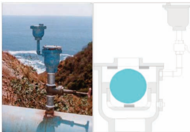
Figura 4.10. Válvula de admisión y expulsión de aire en conducciones presurizadas.
