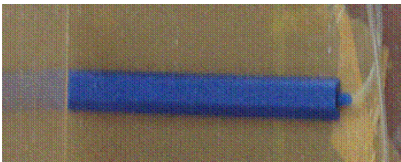
Fotografía 3.2 Difusores de cerámica de burbuja fina instalados en el reactor aerobio
