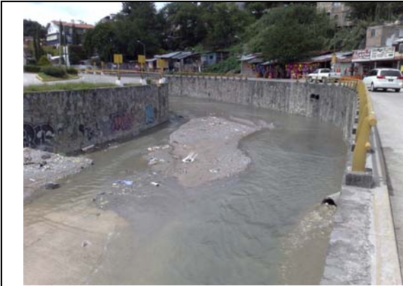
Figura 2.1.16.g.- Aspecto de las descargas de colectores de aguas residuales al río Huacapa.
