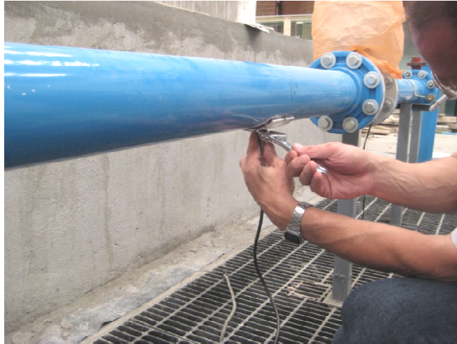
Figura C- 7. Instalación del transductor No. 2
