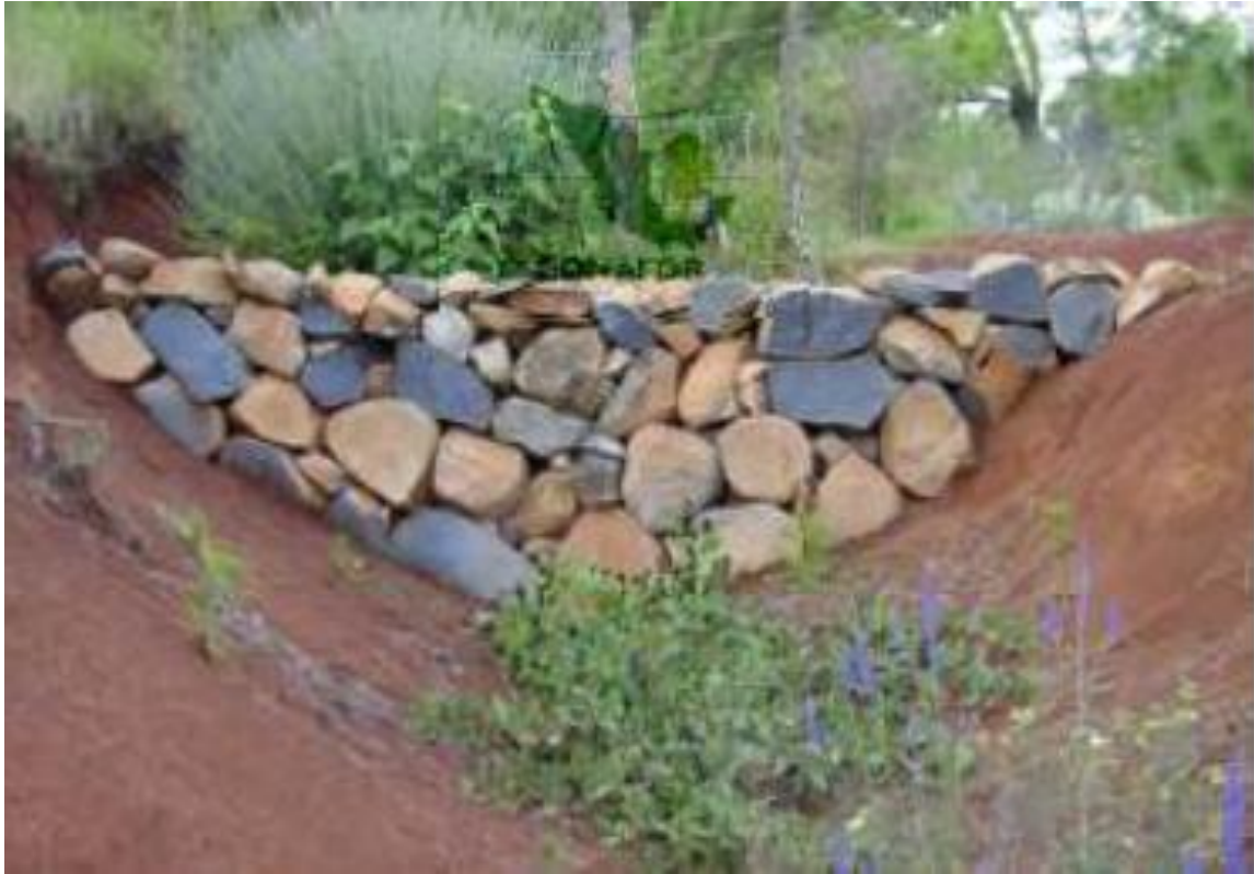
Figura 7.48. Presas de piedra acomodada. (CONAFOR, 2004)
