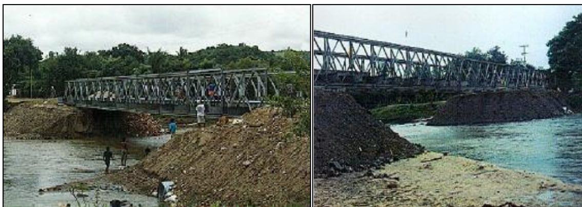
Figura 7.68. Puentes tipo Mabey. (SCT,2011)
