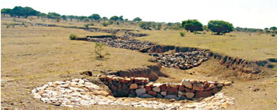
Figura 7.51. Recubrimiento de una cárcava. (CONAFOR, 2007)
