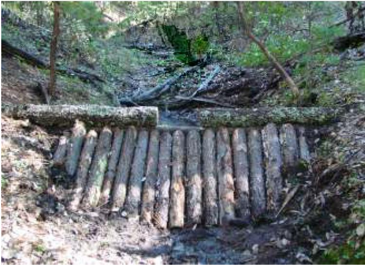
Figura 7.46 Presa de morillo. (CONAFOR, 2004)
