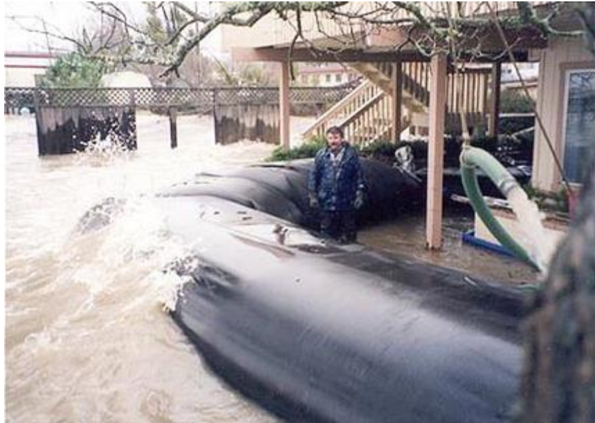
Figura 8.18 Geotubos para el control de inundaciones.
