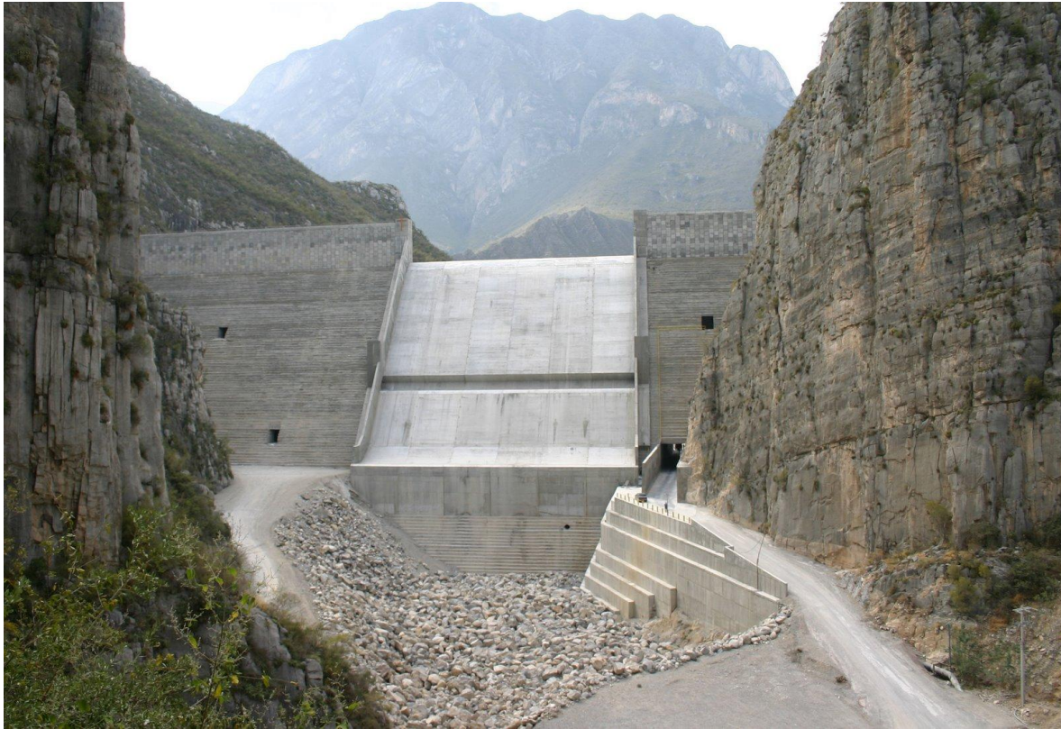
Figura 7.38. Presa rompe-picos del río Santa Catarina, Monterrey
