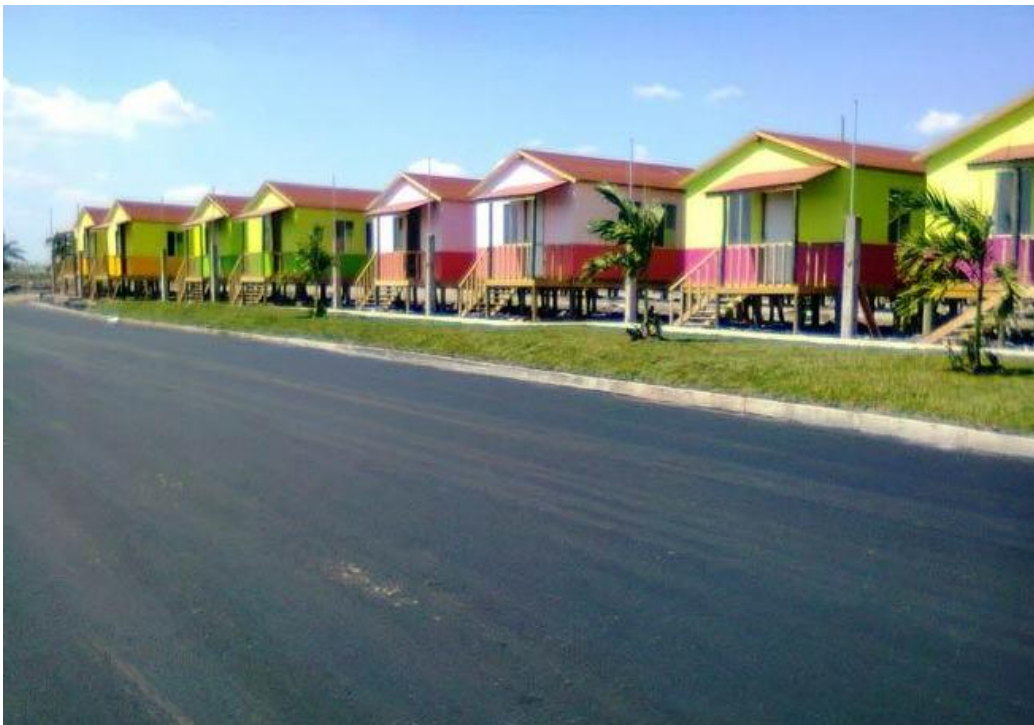
Figura 7.58. Viviendas a prueba de inundaciones en Veracruz. (Valdés, 2011)
