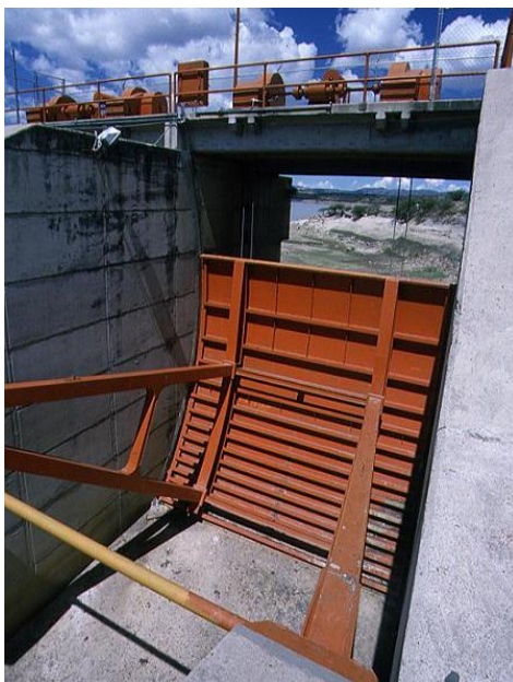
Ilustración 5.8. Compuerta radial de la Presa "Temascal"
