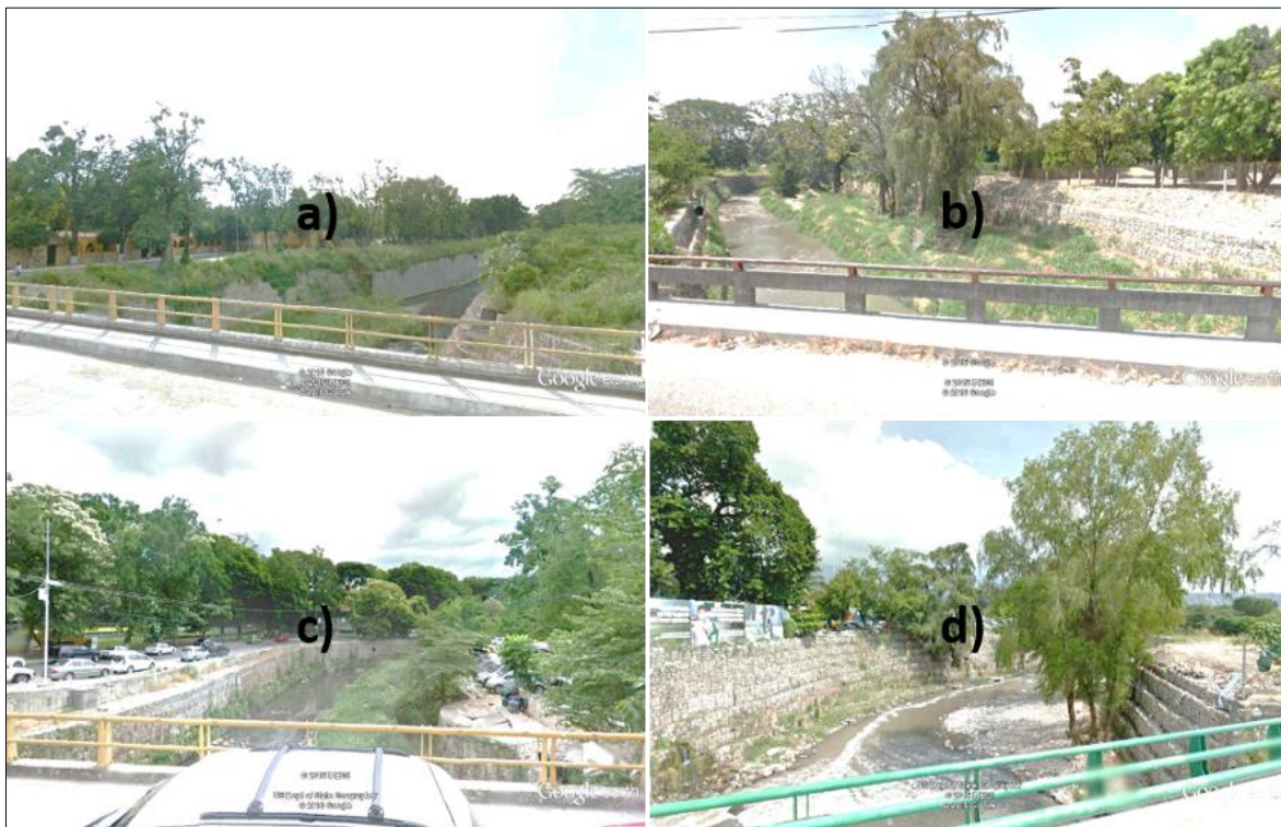
Figura 6.5. Revestimiento de los márgenes con muro gavión: a) puente casa Kolping, b) 20 ote. Norte, c) 11ª calle norte y d) libramiento norte a un costado de procuraduría.
