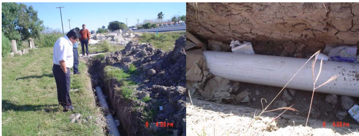
Ilustración 4.7. Tubería de 10 pulgadas, clase 10, ubicación Carretera Ciudad Victoria – Matamoros (enfrente de la Naval).
