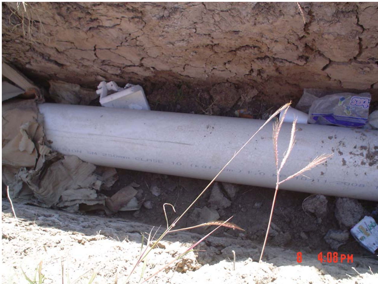
Ilustración 4.11. Tramo Naval – San Lorenzo, se observó tubería de PVC de diez pulgadas, clase 10 – km cadenamiento 0+000
