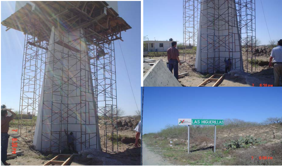
Ilustración 4.5. Tanque Las Higuerrillas, ubicación a partir del sector Naval, cadenamiento 63+581
