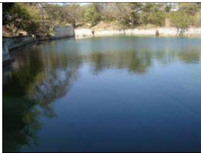
Figura 4. Captación de agua cruda en Berriozabal.
