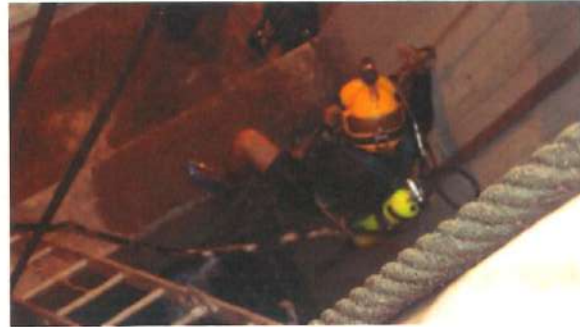
Fotos 1 y 2. Buzos saliendo de la verificación del calafateo de las compuertas
