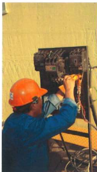
Fotos 1 y 2. Alimentación eléctrica al malacate y descenso de la canastilla
