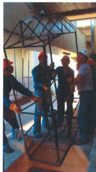
Fotos 1 y 2. Alimentación eléctrica al malacate y descenso de la canastilla
