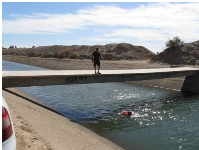
Aforo en el Canal Independencia
