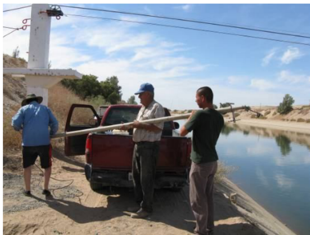
Colocación de escala de nivel
