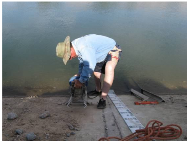
Instalación de equipo en talud
