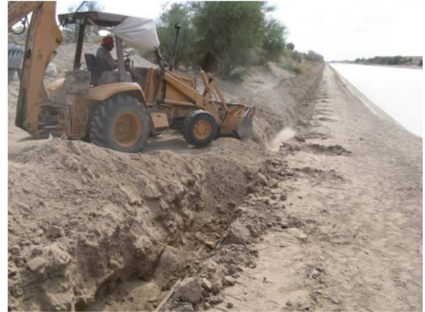
Tapado de Zanja
