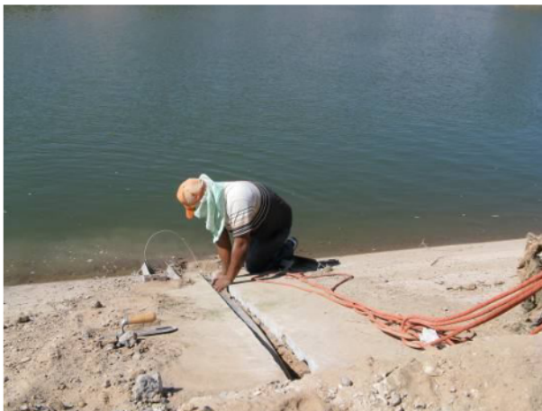
Instalación tubería cableado
