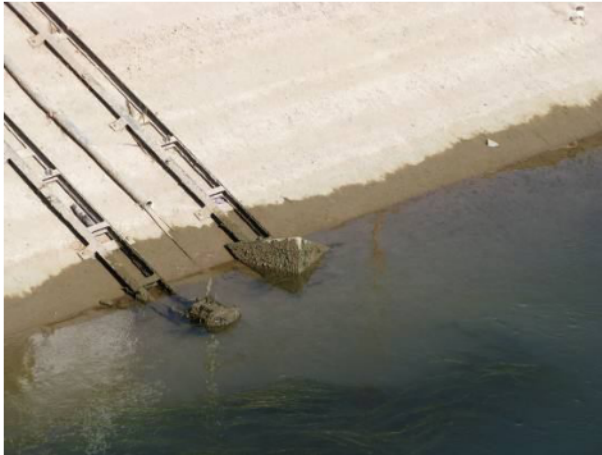
Rieles y equipos instalado
