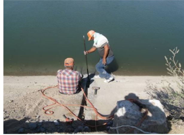
Zanja en concreto para cable sensor
