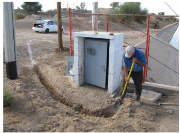
Zanja de conexión
