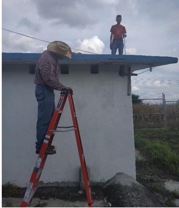
Figura 3.58 Colocación de antena
