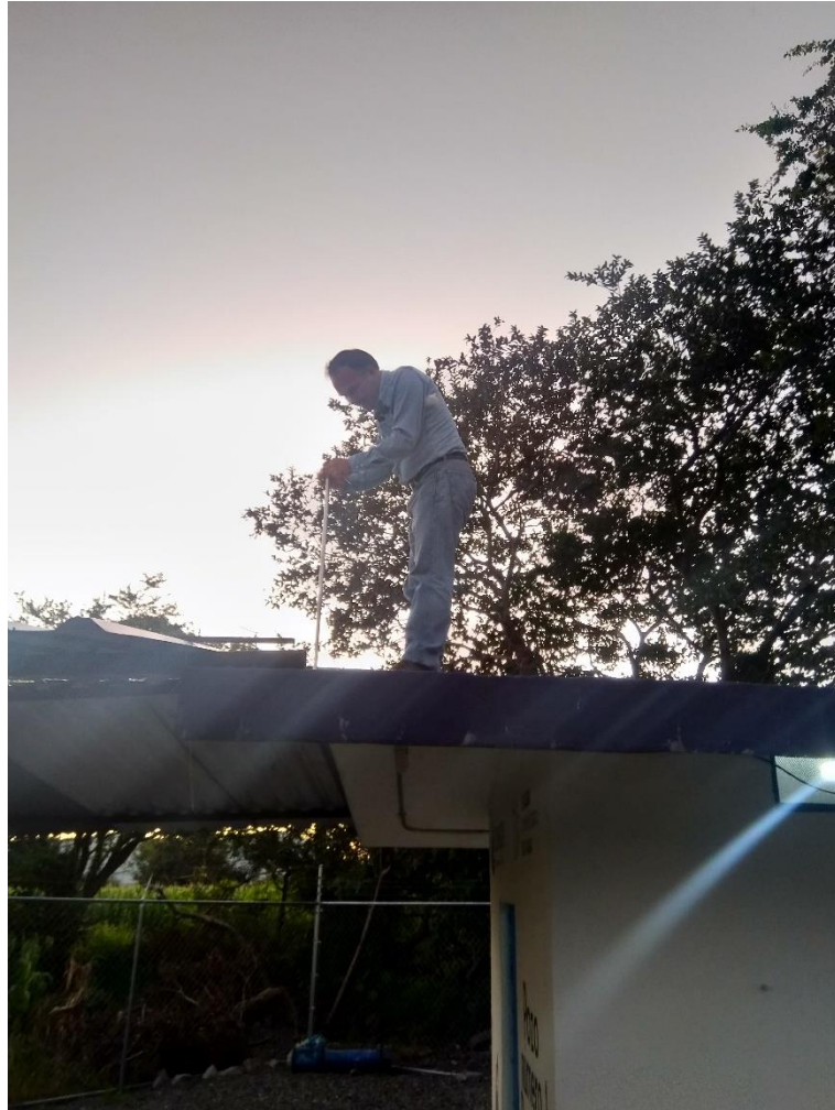
Figura 3.77. Colocación de antena
