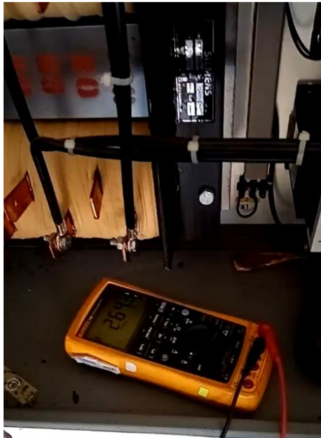
Figura 3.53 Inspección de fases
