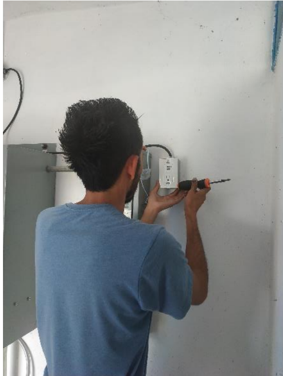
Figura 3.71. Colocación de centro alimentador USB
