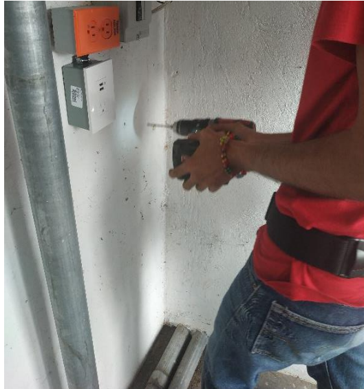
Figura 3.54 Colocación gabinete
