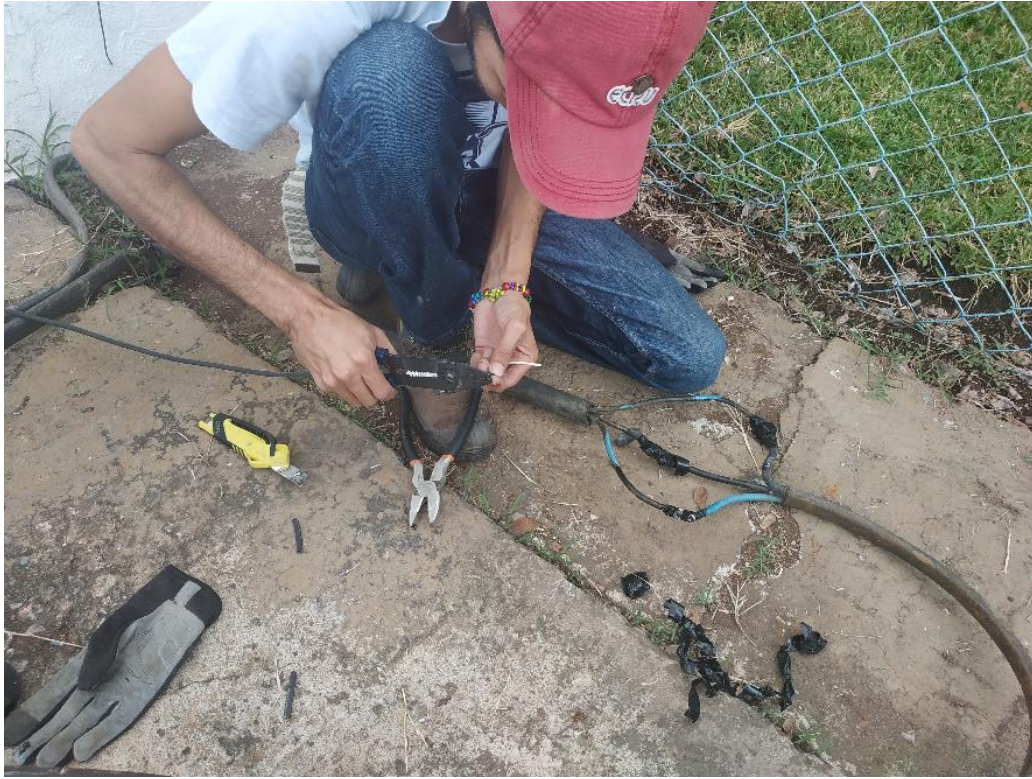
Figura 3.41 Conexión arrancador-LoRa
