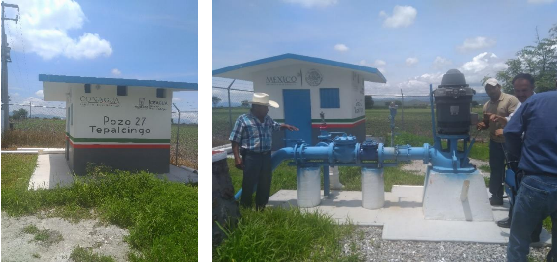
Figura 3.29 Caseta del Pozo #27 (izquierda). Medición del nivel estático (derecha)
