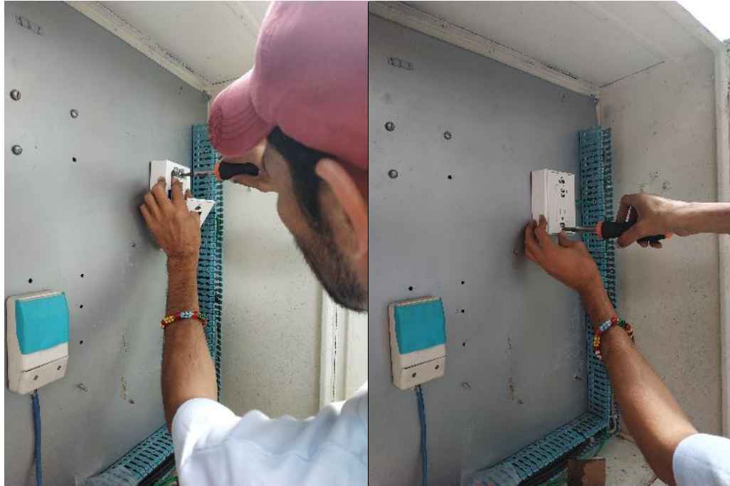
Figura 3.39 Colocación de centro alimentador USB
