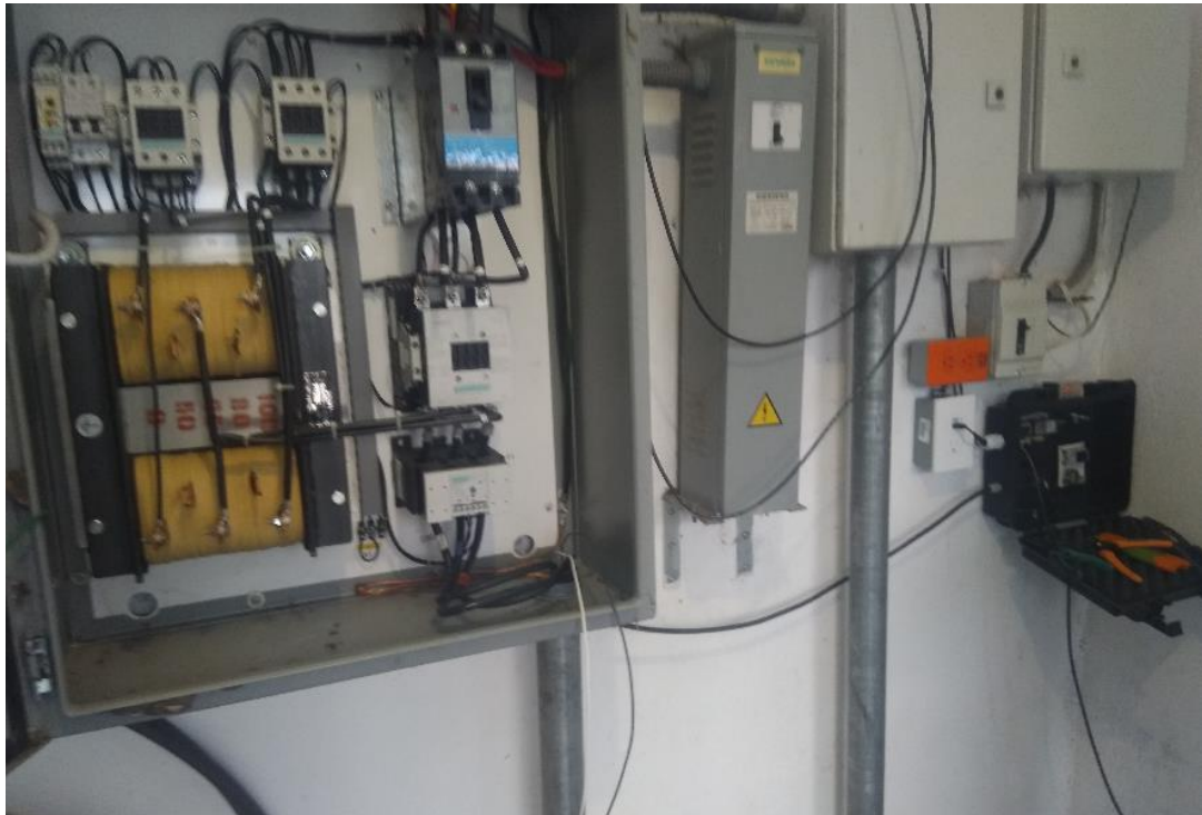
Figura 3.57 Conexión arrancador-LoRa
