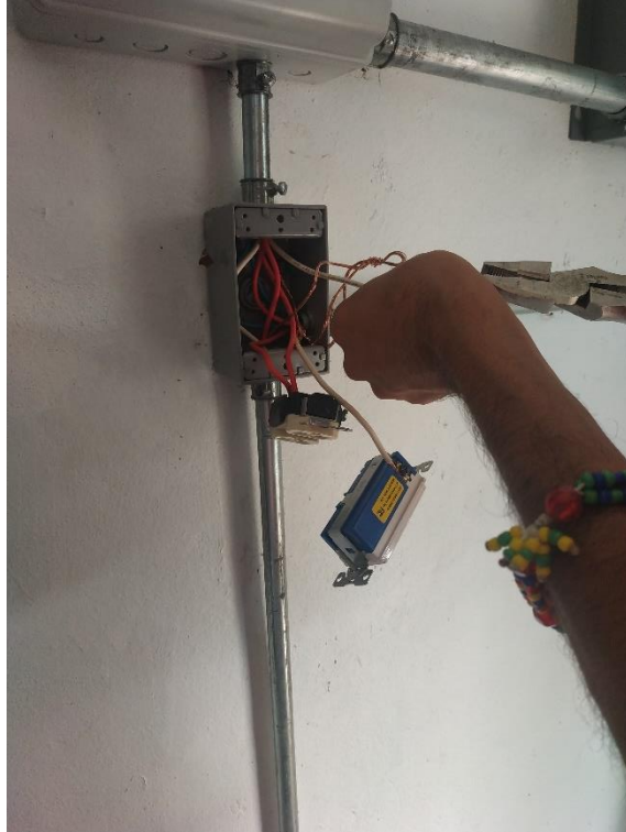
Figura 3.75. Colocación de centro alimentador USB
