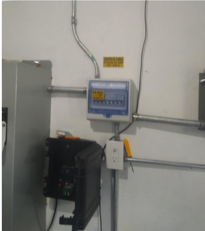
Figura 3.48 Colocación gabinete
