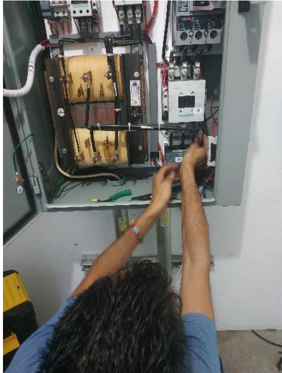
Figura 3.73. Conexión arrancador-LoRa
