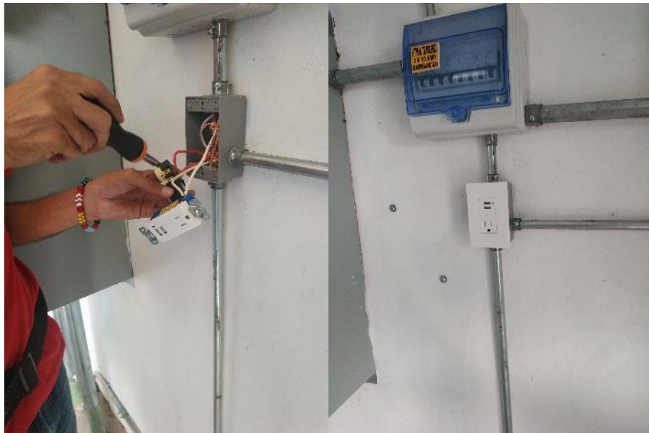
Figura 3.49 Colocación de centro alimentador USB
