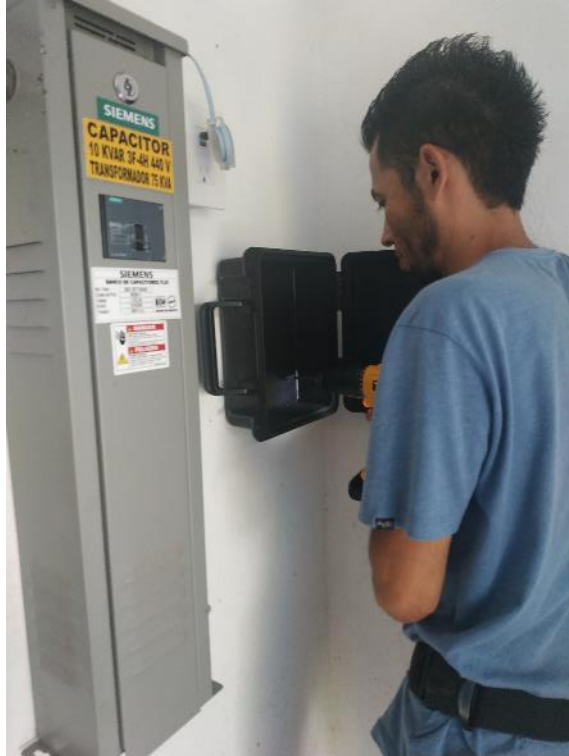
Figura 3.70. Colocación gabinete
