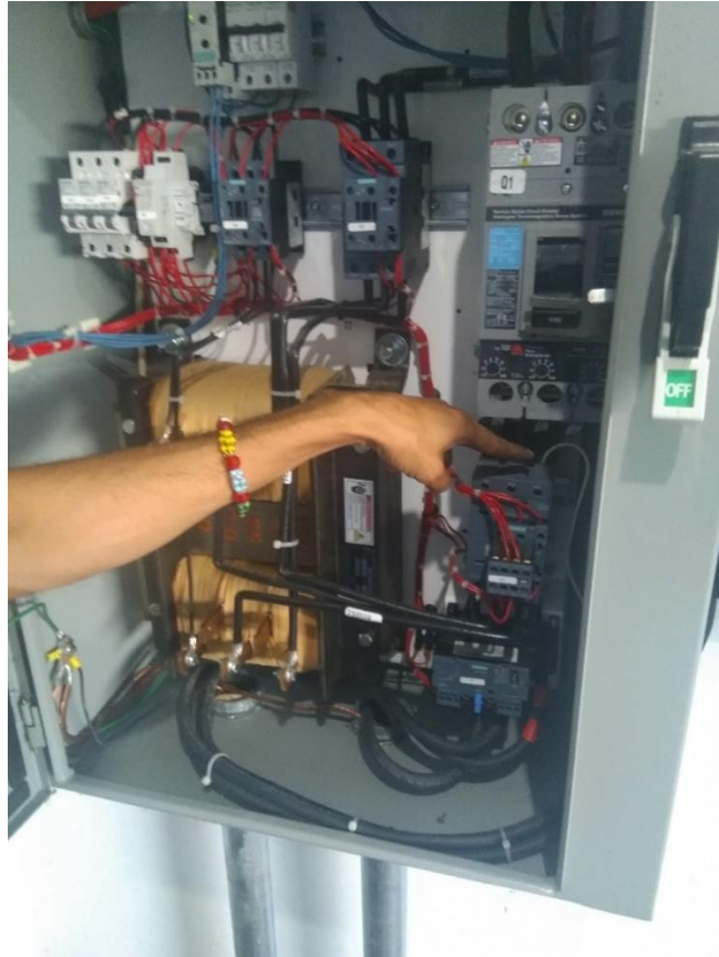
Figura 3.51 Conexión arrancador-LoRa
