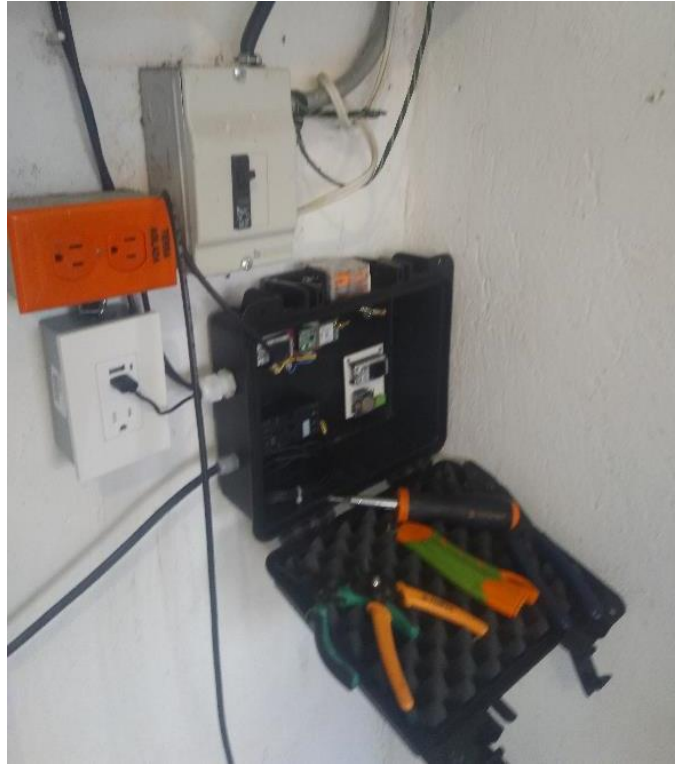
Figura 3.56 Colocación LoRa
