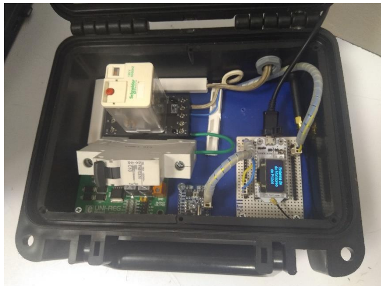
Figura 3.52 Equipo en funcionamiento
