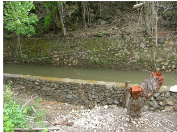
"Tamácuaro" Visita de obra
