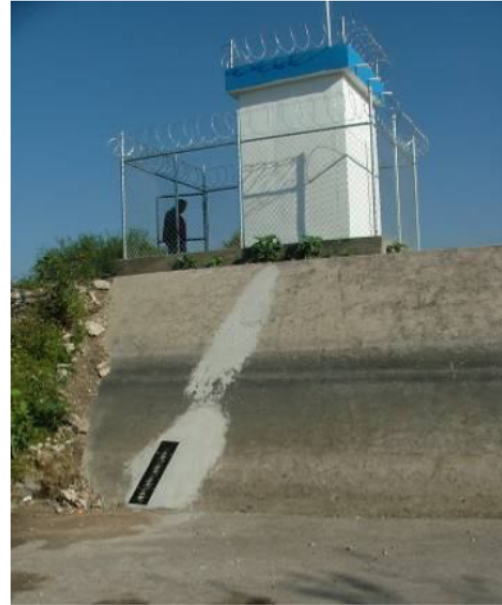
"CP km 95+330" (Tepanco de López) Instalación terminada
