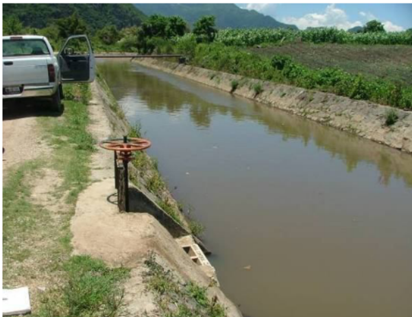
Toma con módulo "Aqua Control" ("La Corrucha")
