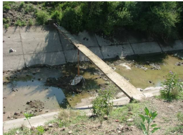
"Canal lateral km 66+860" Puente de aforo
