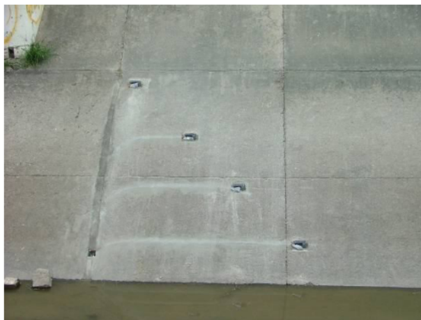
"CP km 53+100" (Tecamachalco) Instalación de sensores de velocidad
