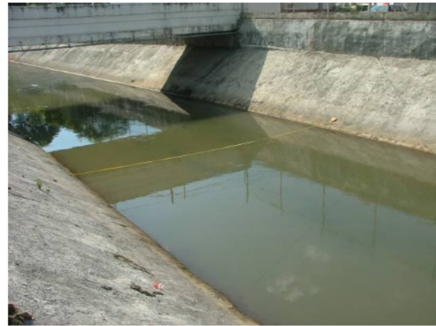
(b) Cinta métrica tendida en el canal para marcar las dovelas
