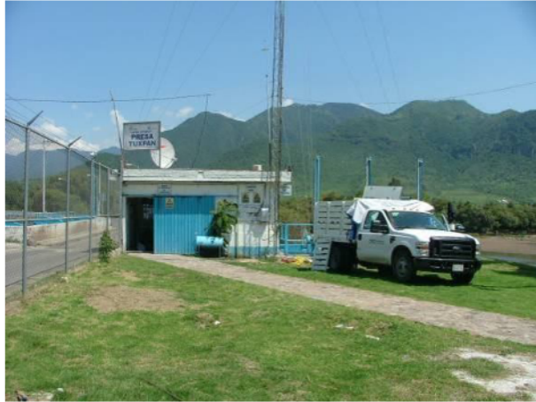
Caseta de operación
