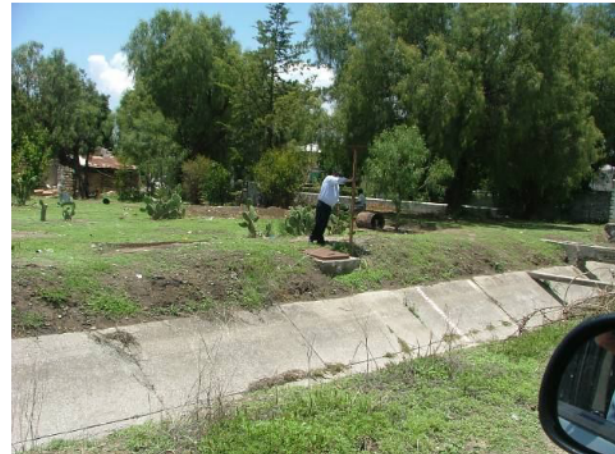
"Canal lateral km 38+780" Caseta de un antiguo AGL
