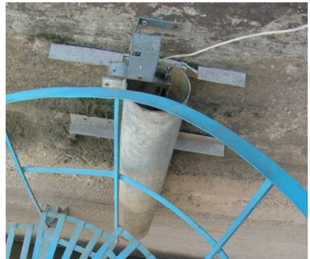
Alarma (cuando el tirante en el embalse alcanza un máximo) (11)
