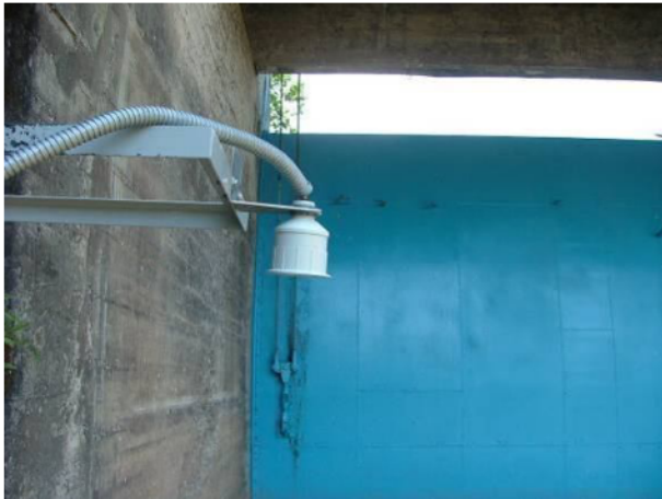
Sensor ultrasónico de nivel
