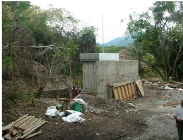
"Tamácuaro" Visita de obra
