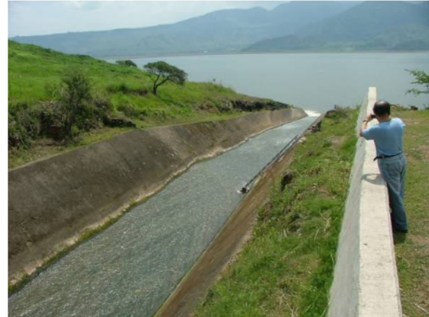
Sección de control, aguas abajo del sitio de monitoreo
