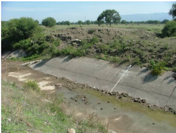
"Canal lateral km 66+860" Vista del sitio
