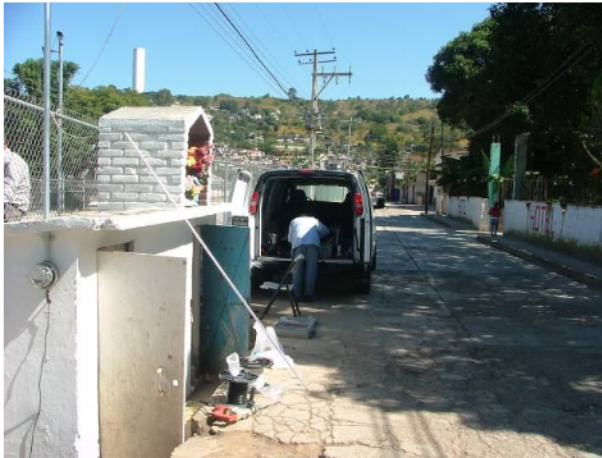
(a) Instalación del medidor
