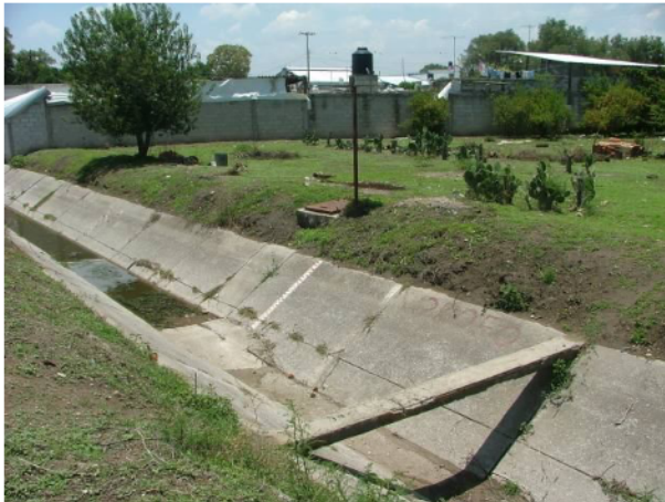
"Canal lateral km 38+780" Vista del sitio
