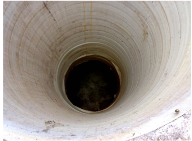
64+292 Canal Conchos, vista interior del pozo de visita
