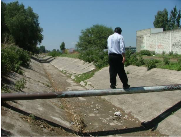
"Canal lateral km 51+180" Vista del sitio
