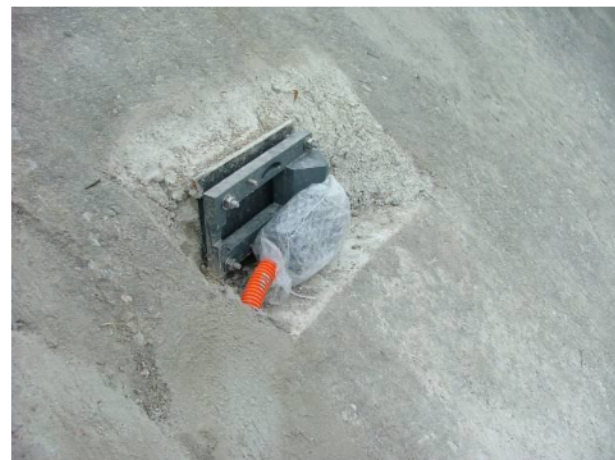
"CP km 53+100" (Tecamachalco) Instalación de sensores de velocidad
