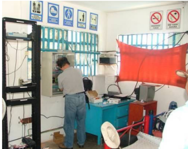
Vista de la caseta de operación
