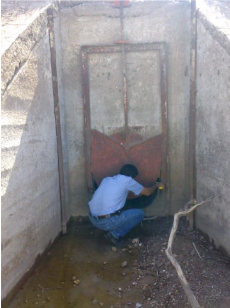
64+292 Canal Conchos, medición del diámetro del tubo
