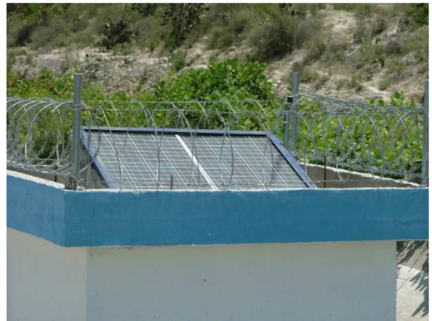
"Valsequillo" km 24+769 Verificación de los paneles solares
