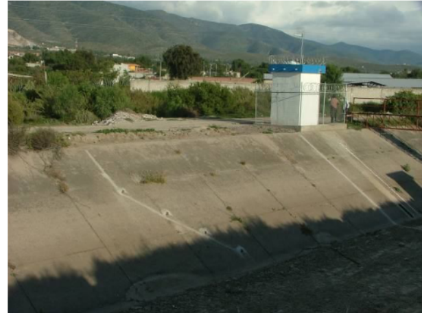
"CP km 53+100" (Tecamachalco) Instalación terminada
