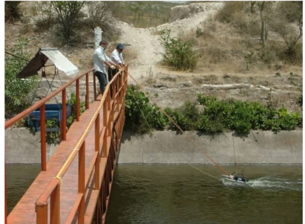
"Valsequillo" km 24+769 Aforo de verificación
