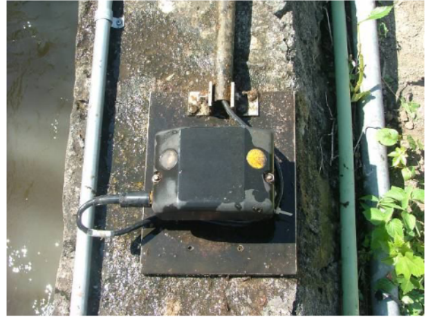
Segundo aforador tipo ADL limpio
