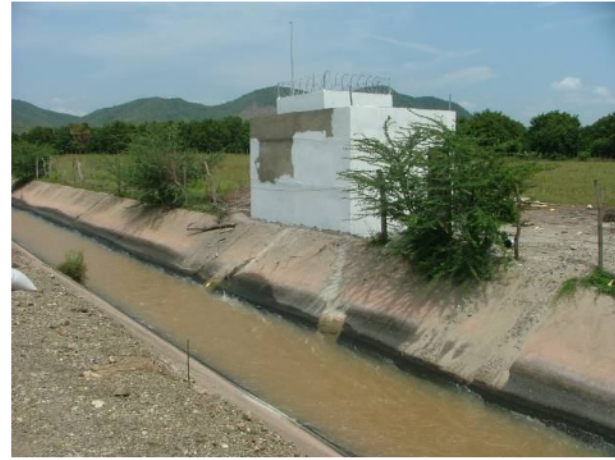
"Canal Lateral" Visita de obra
