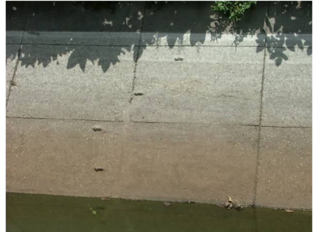
"Valsequillo" km 24+769 Limpieza de los sensores de velocidad
