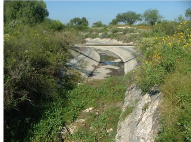
"CP km 95+330" (Tepanco de López) Instalación terminada
