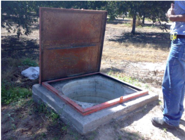
64+292 Canal Conchos, vista exterior del pozo de visita
