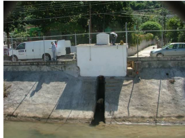
(b) Instalación de la antena para la telemetría
