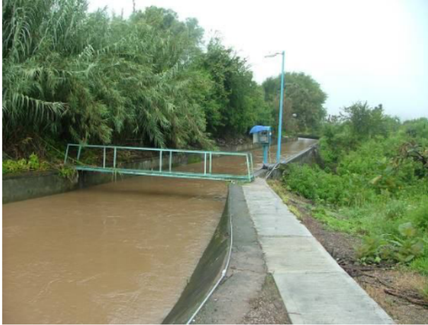
Vista del canal en la salida de la derivadora "Tuxpan"
