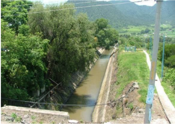
Vista del canal en la salida de la derivadora "Tuxpan"
