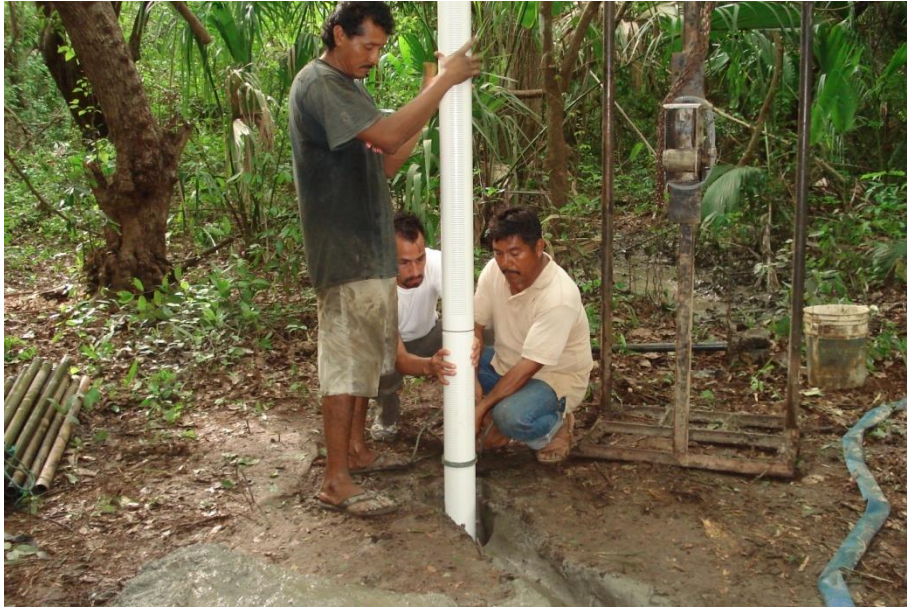
Figura 130 Colocación del ademe
