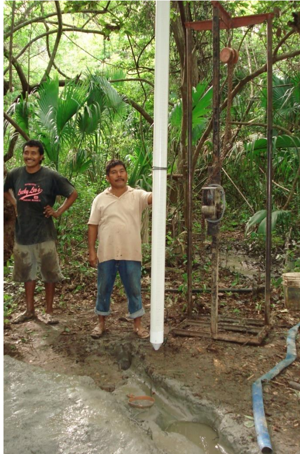
Figura 129 Ademe acoplado y listo para su instalación
