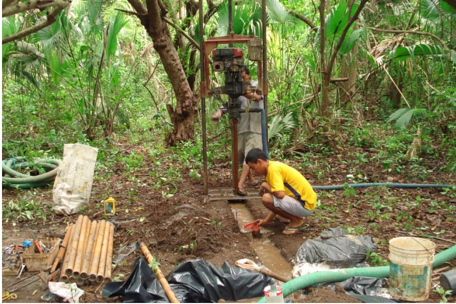
Figura 126 Circulación y remoción del material perforado
