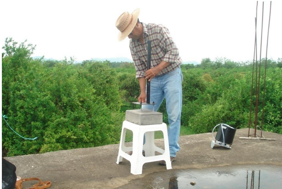
Figura 97 Instalación de la base del pluviómetro
