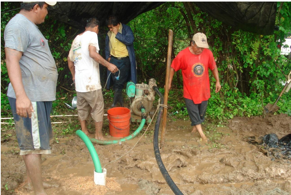
Figura 134 Desarrollo del piezómetro mediante bombeo
