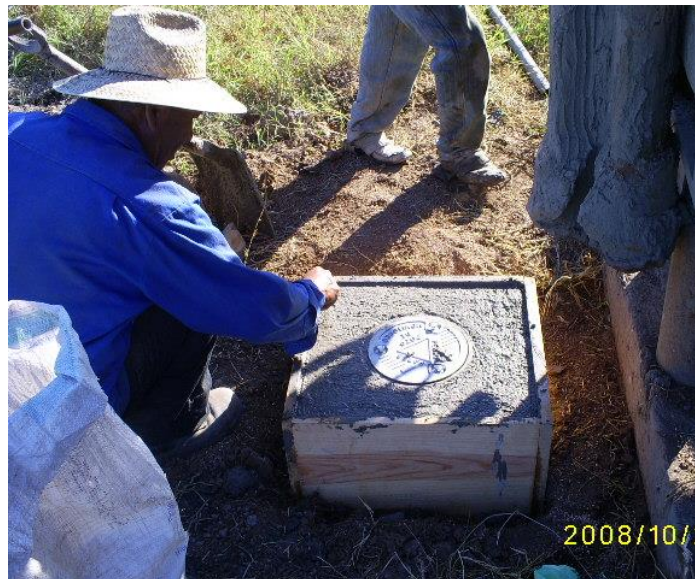
Figura 118 Tapa superior de acero ahogada en el brocal de concreto
