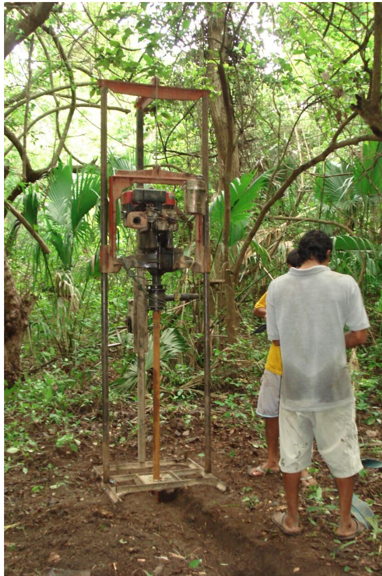
Figura 120 Equipo de perforación
