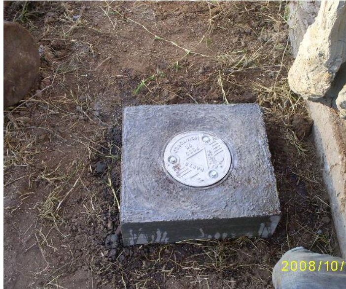
Figura 119 Brocal de concreto
