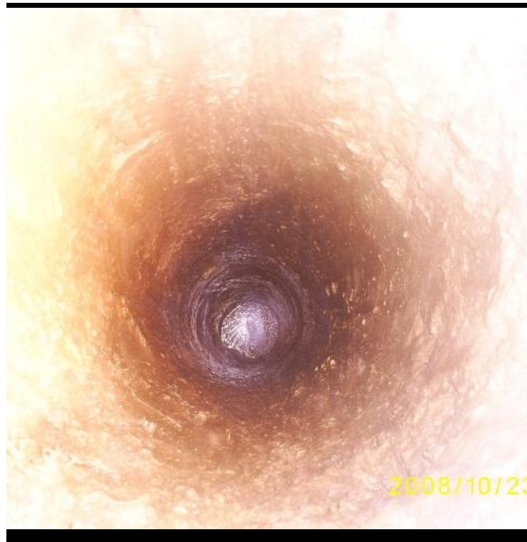
Figura 112 Perforación de 8" de diámetro
