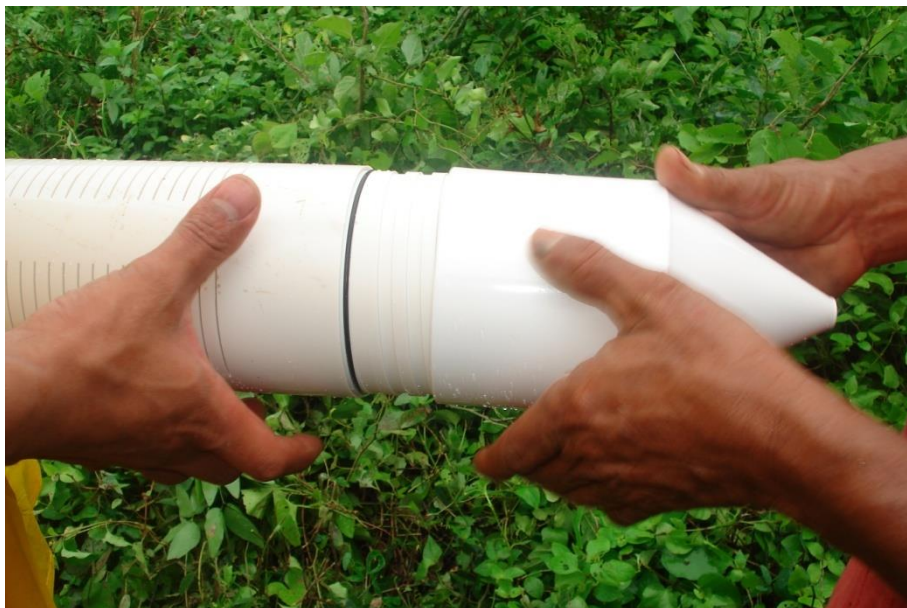
Figura 128 Acople del tapón de punta de lápiz con la tubería ranurada
