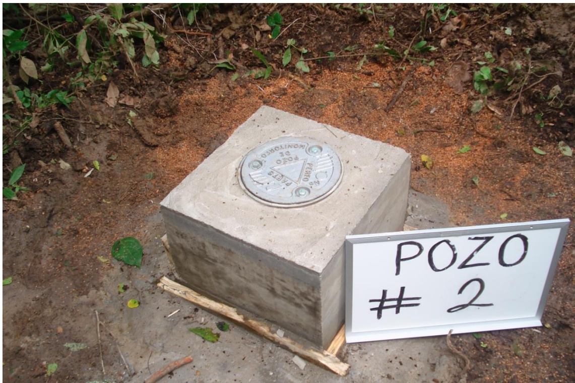
Figura 133 Tapa superior de acero ahogada en el brocal de concreto
