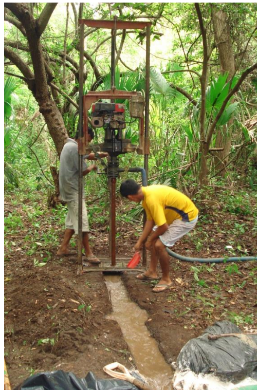
Figura 123 Perforación mecánica de los piezómetros profundos
