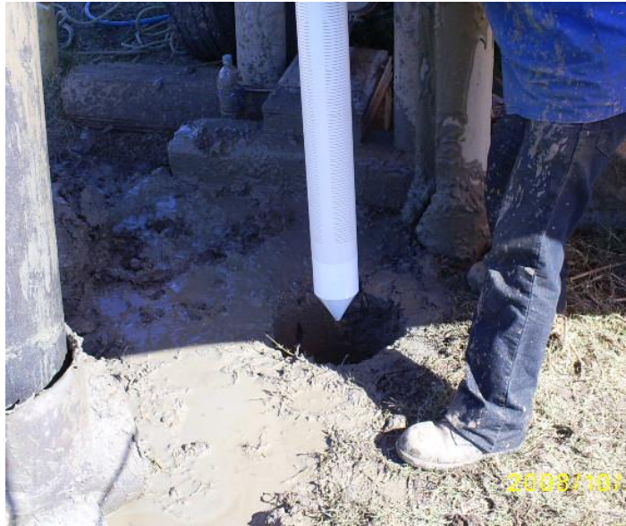
Figura 115 Colocación del ademe
