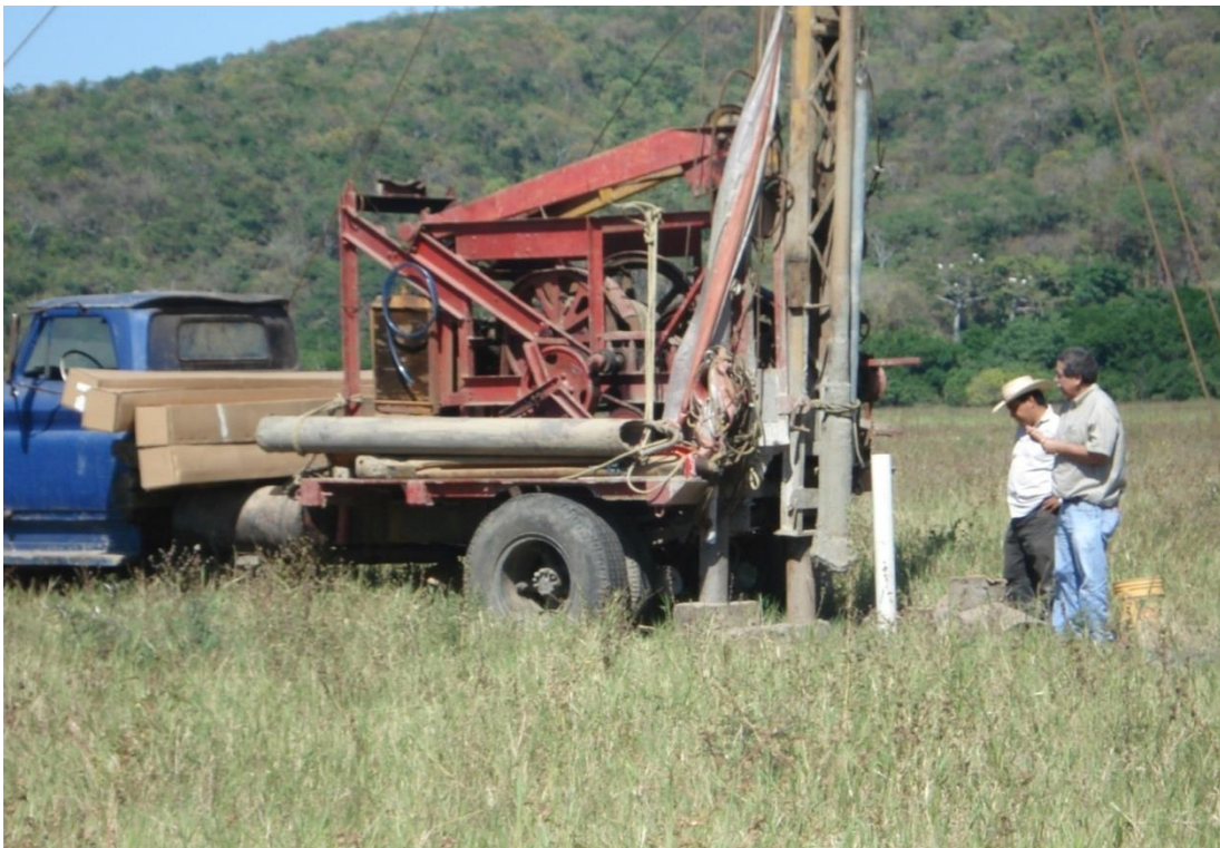
Figura 108 Equipo de perforación
