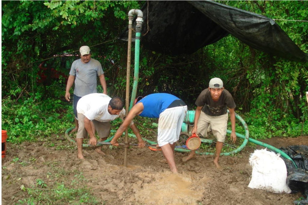
Figura 122 Perforación a mano de los piezómetros someros
