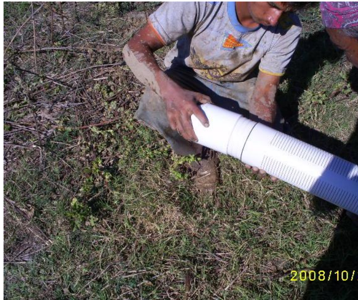
Figura 113 Acople del tapón de punta de lápiz con la tubería ranurada
