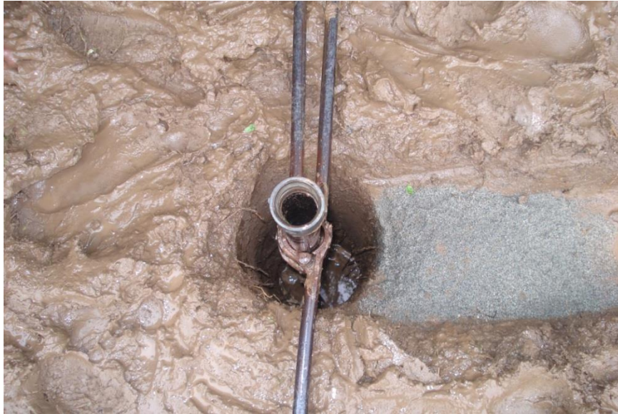
Figura 127 Perforación de 8" de diámetro
