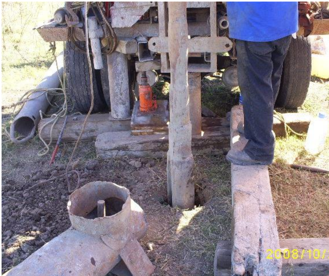
Figura 109 Perforación de los piezómetros
