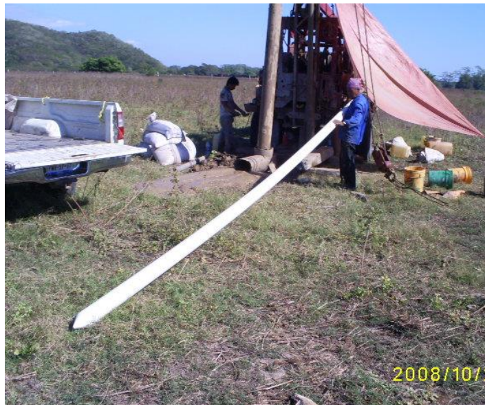
Figura 114 Ademe acoplado y listo para su instalación
