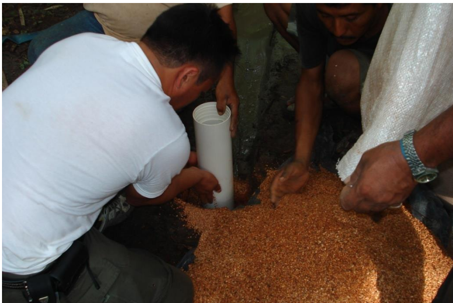
Figura 131 Colocación del filtro
