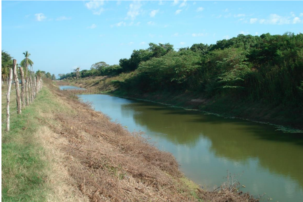
Figura 161 Dren del distrito de riego que descarga en las lagunas
