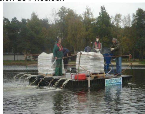
Aplicación por aspersión o inyección
