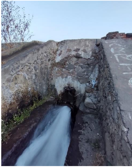
Figura 2 y 3.- Estructura de salida de agua del jagüey La Sabana.
