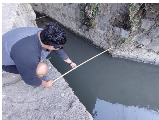
Figura 17. Canal bajo el puente del libramiento
