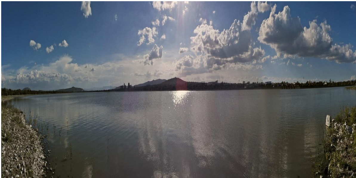
Foto 216. Vista panorámica de la Presa El Centenario
