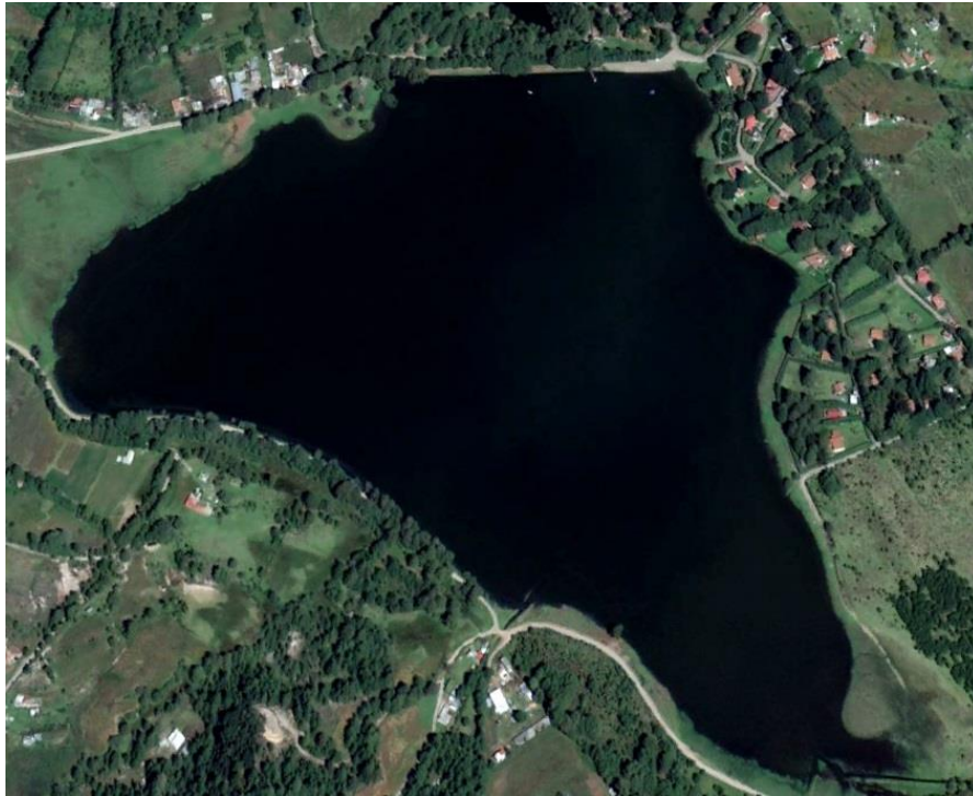
Imagen 14. Google 24/10/2015 Presa Brockman 19°45'59.74''N 100°08'36.27''O
