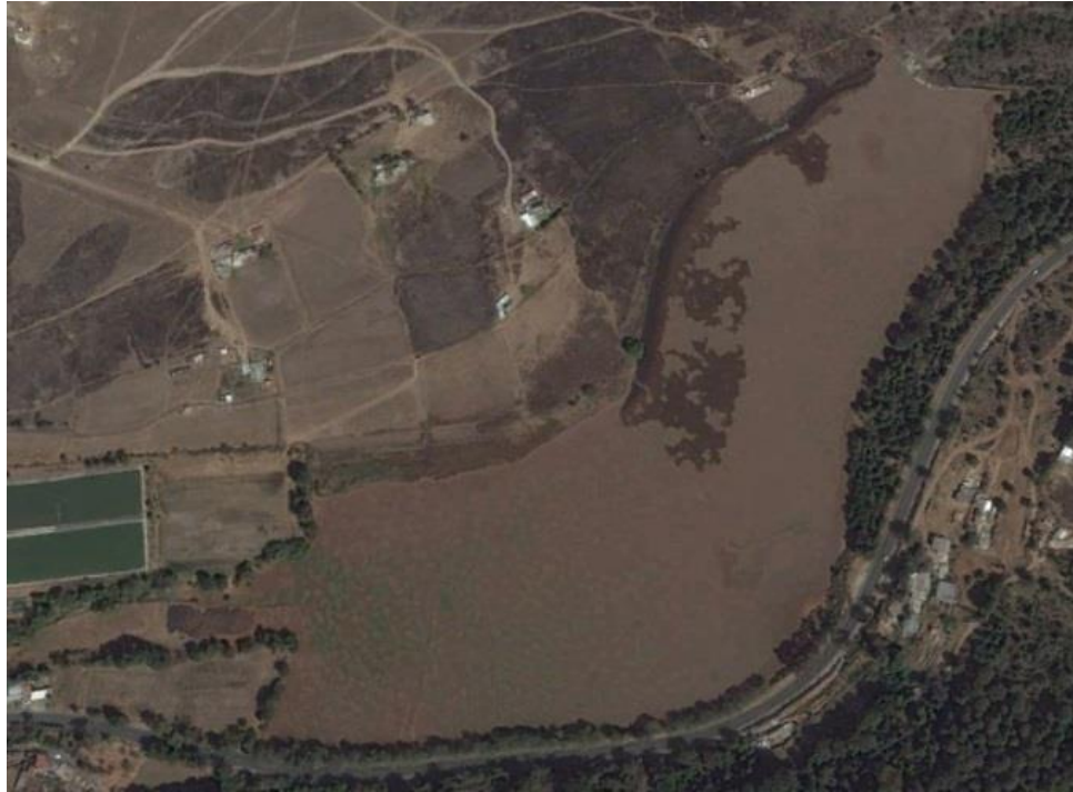
Imagen 16. Google 05/03/2016 Presa El Mortero 19°48'31.20"N 100°07'07.35"O
