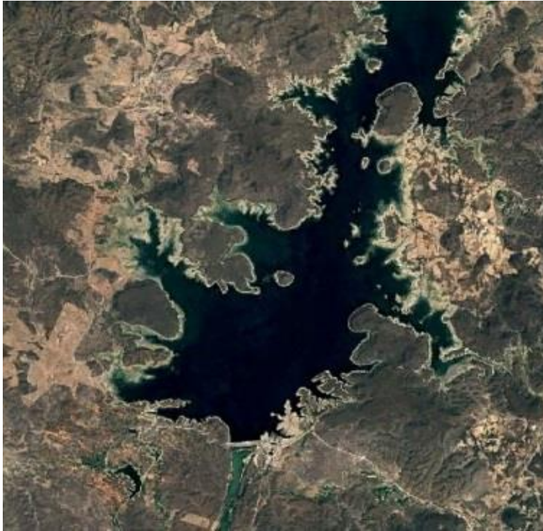
Imagen 60. Google 30/12/2016. Presa Miguel Hidalgo y Costilla 26°32'58.42" N 108°34'14.37" O
