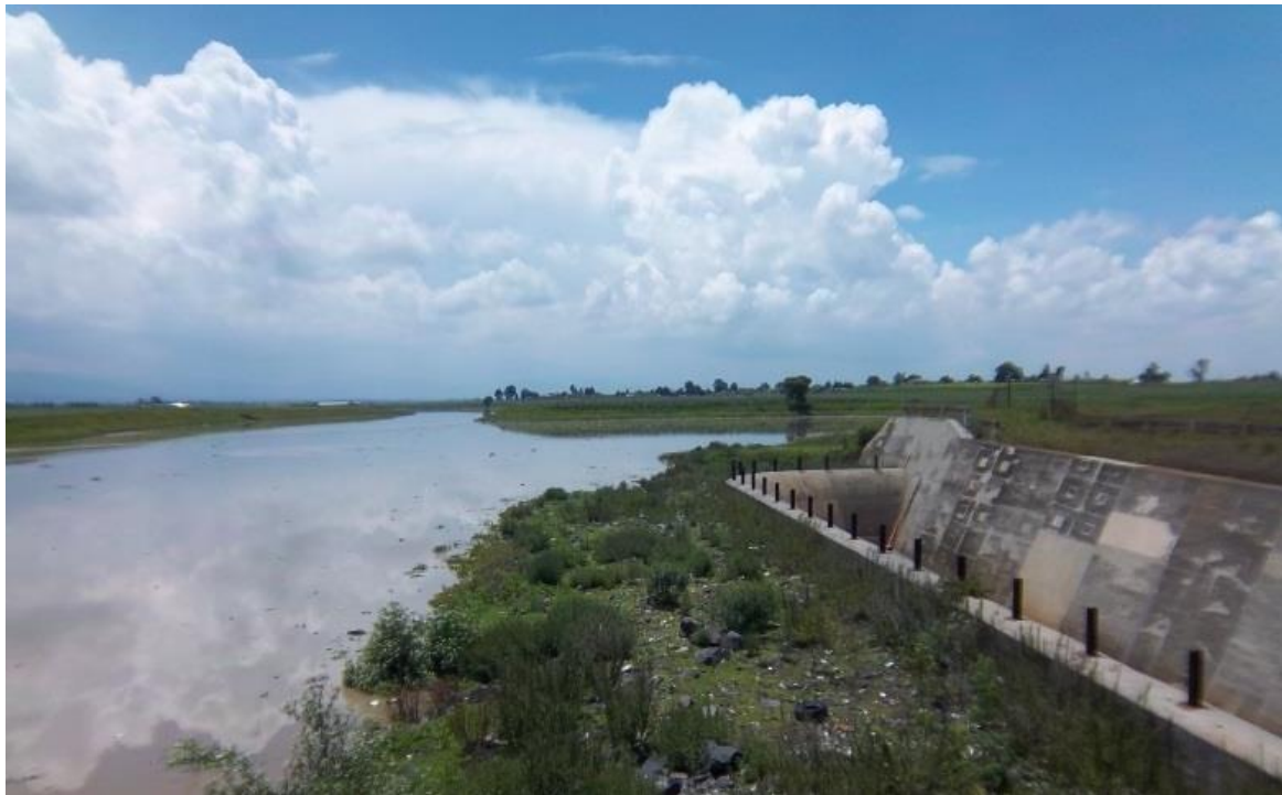
Foto 74. Vista General de la Presa José Antonio Álzate
