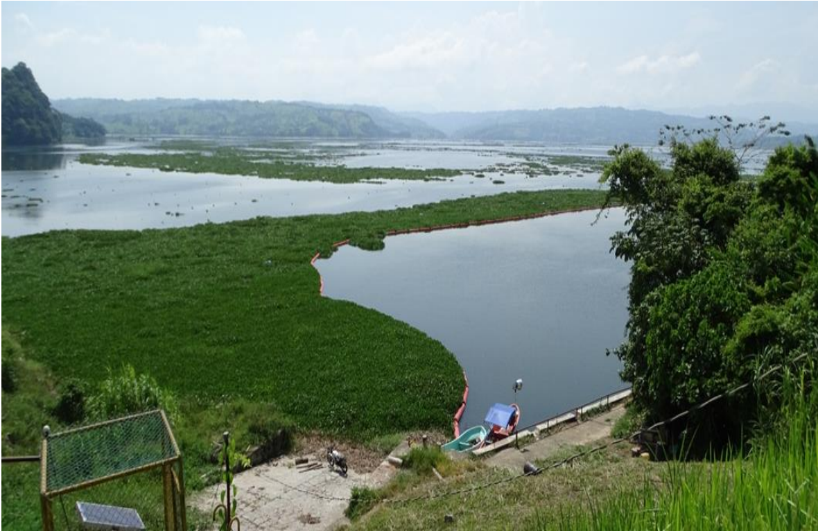
Foto 10. Barreras de contención de Eichhornia crassipes en compuerta de la Presa Peñitas
