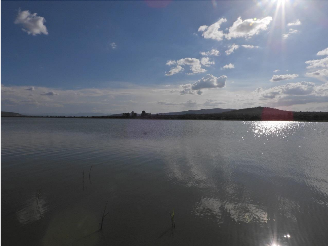
Foto 217. Acercamiento a la Presa El Centenario
