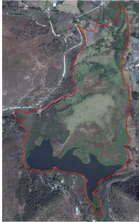
Imagen 22. Google 27/01/2017 Presa Santo Tomas 19°10'16.64"N 100°18'18.81"O
