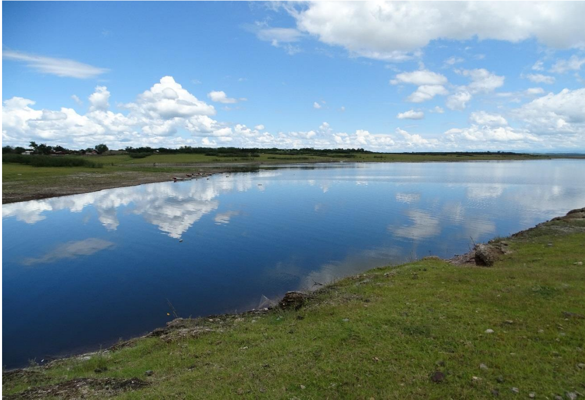
Foto 249. Vista panorámica de la Presa Josefa Ortiz de Domínguez
