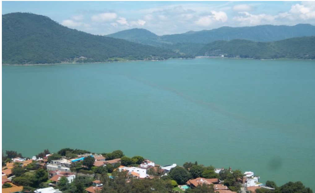
Foto 97. Vista General de la Presa Valle de Bravo
