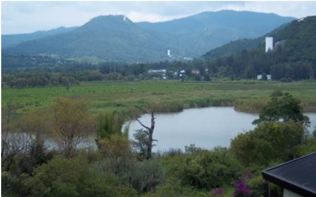
Foto 87. Vista General de la Presa Santo Tomas
