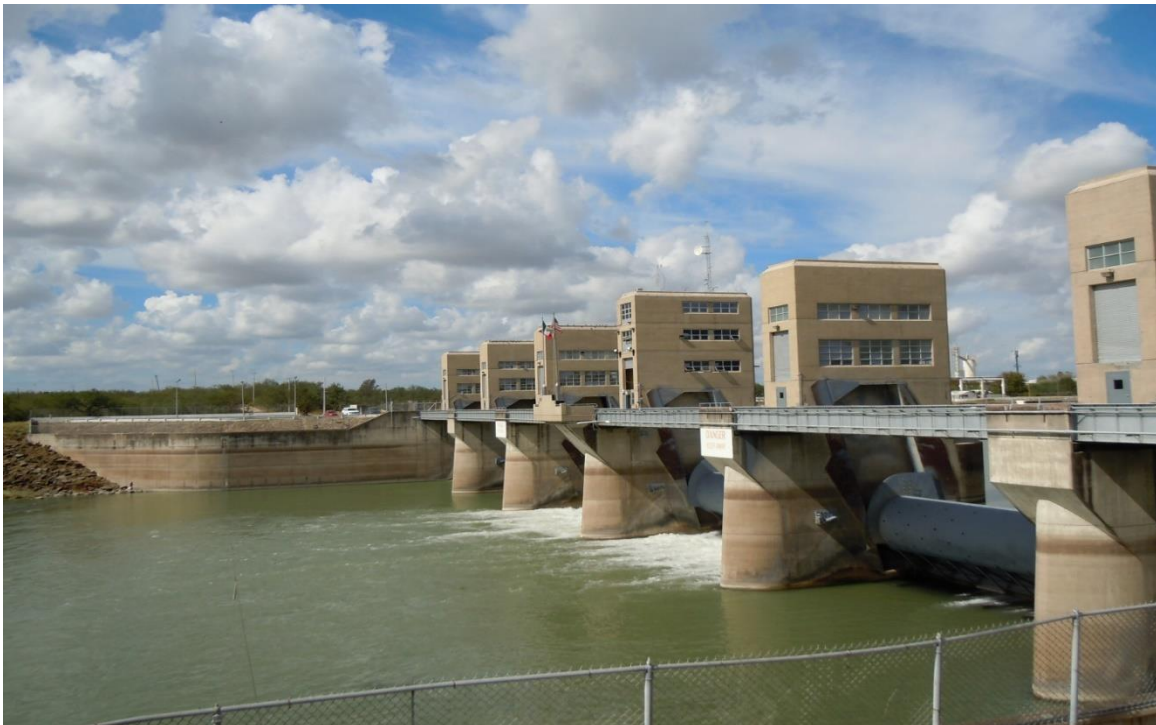
Foto 273. Cortina de la Presa Anzaldúas
