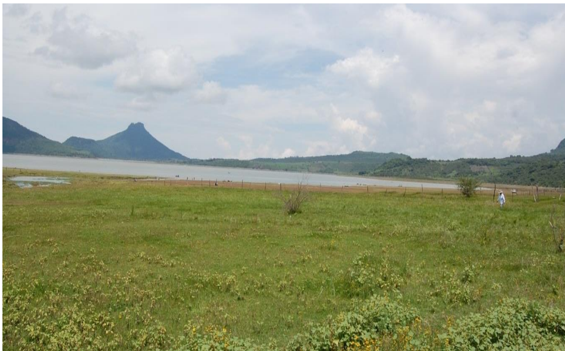
Foto 159. Vista General de la Presa El Bosque
