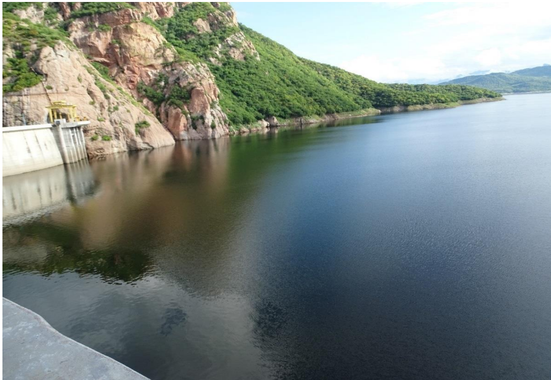
Foto 251. Vista Panorámica de la Presa Luis Donaldo Colosio
