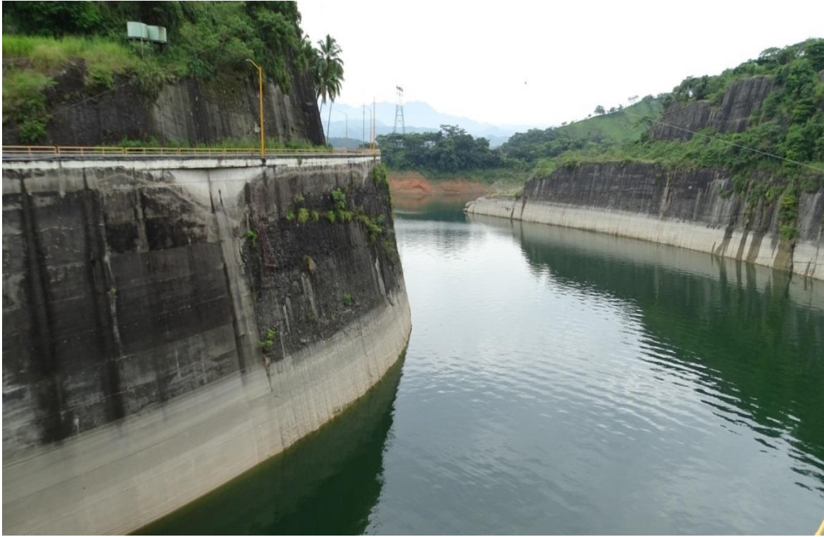
Foto 29. Canal de la Presa Malpaso
