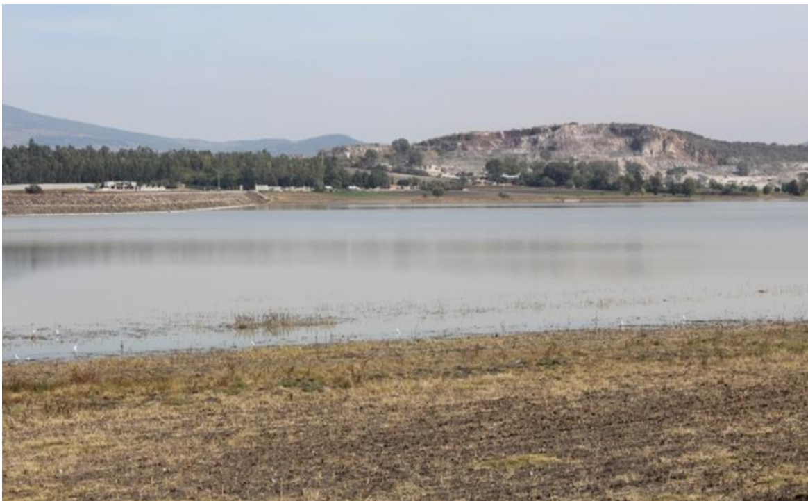
Foto 107. Vista General de la Presa Solís
