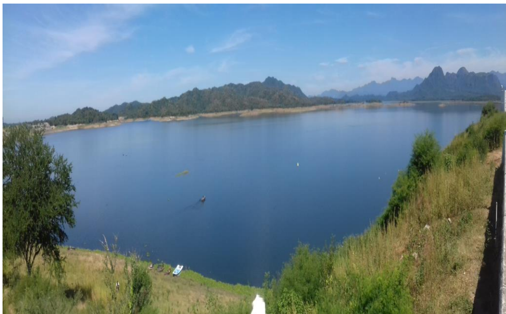
Foto 255. Vista general de la Presa Sanalona
