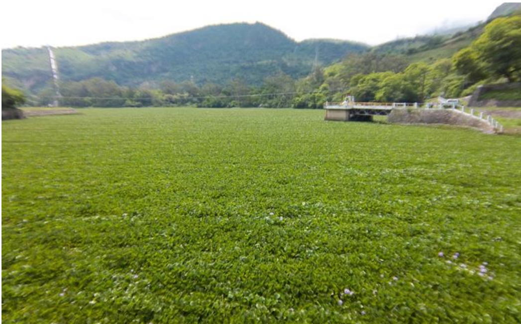
Foto 72. Vista General de la Presa Ixtapantongo infestada al 100% con Eichhornia crassipes
