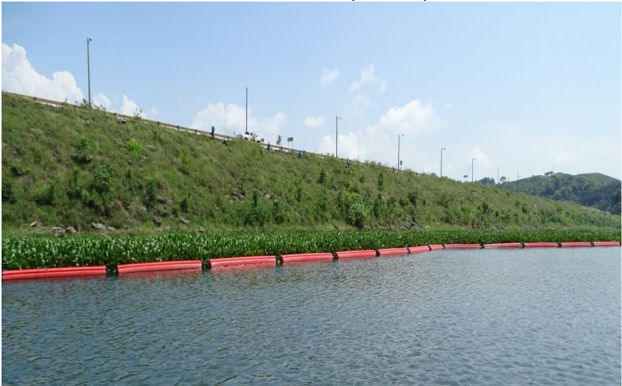
Foto 11. Acercamiento a la barrera mecánica para la contención de Eichhornia crassipes en la Presa Peñitas
