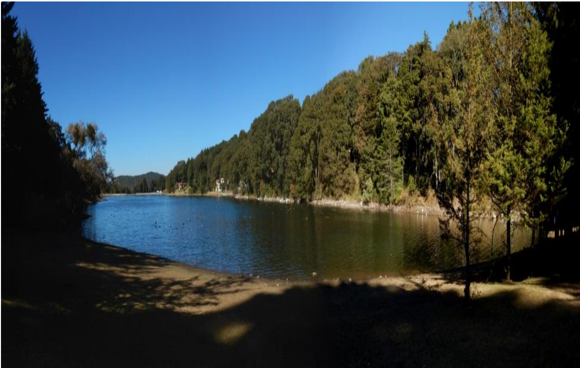
Foto 79. Vista general Presa La Victoria.
