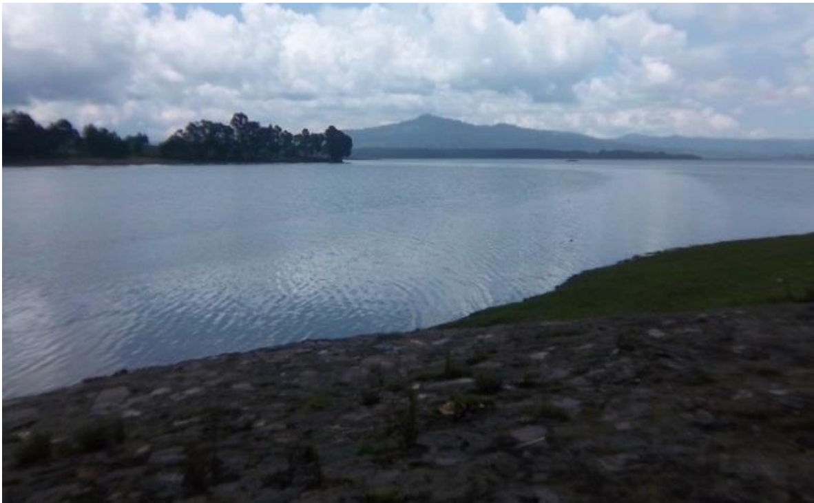
Foto 100. Vista General de la Presa Villa Victoria
