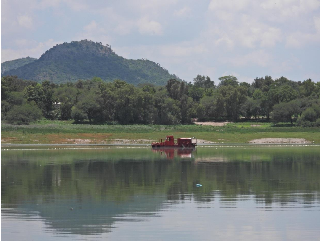
Foto 120. Acercamiento a la Presa Endhó
