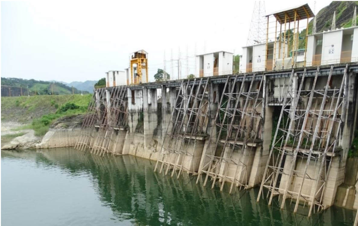
Foto 27. Cortina de la Presa Malpaso
