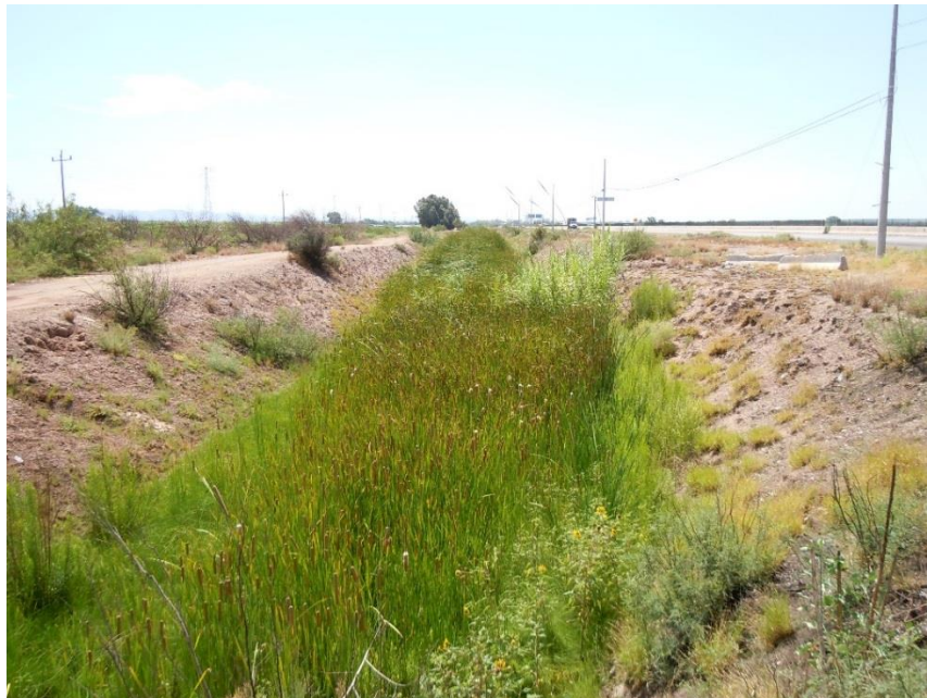
Foto 53. Infestación de Typha domingensis en el dren de la presa.
