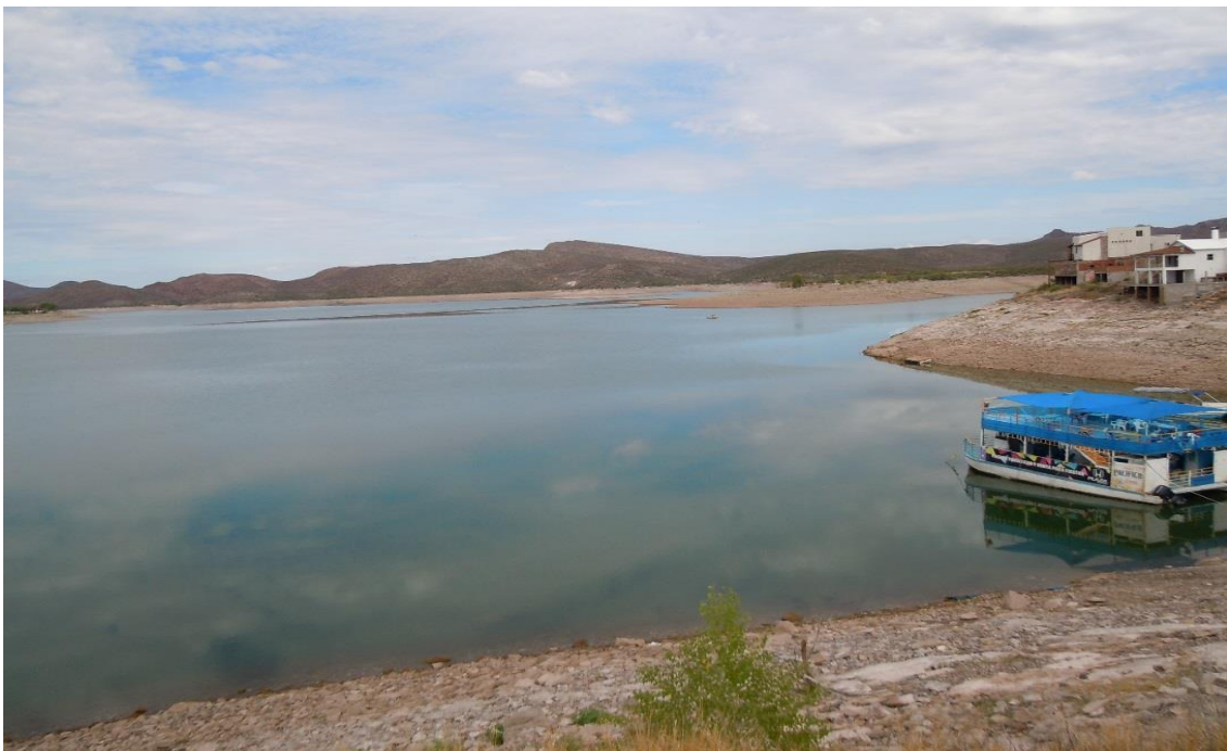
Foto 51. Presa Francisco I Madero
