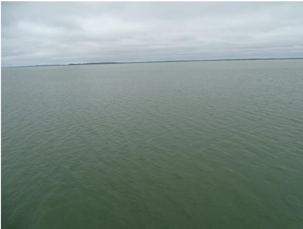
Foto 203. Vista general de la Presa Cuchillo-Solidaridad
