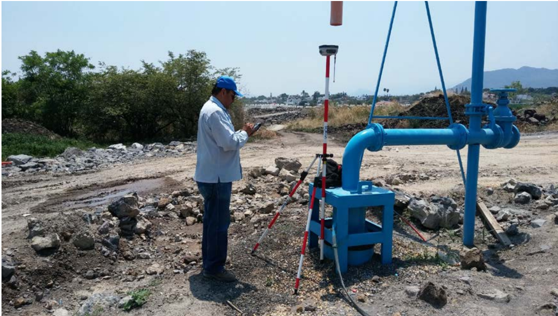
Foto 1 Medición del brocal del pozo XP-31.
