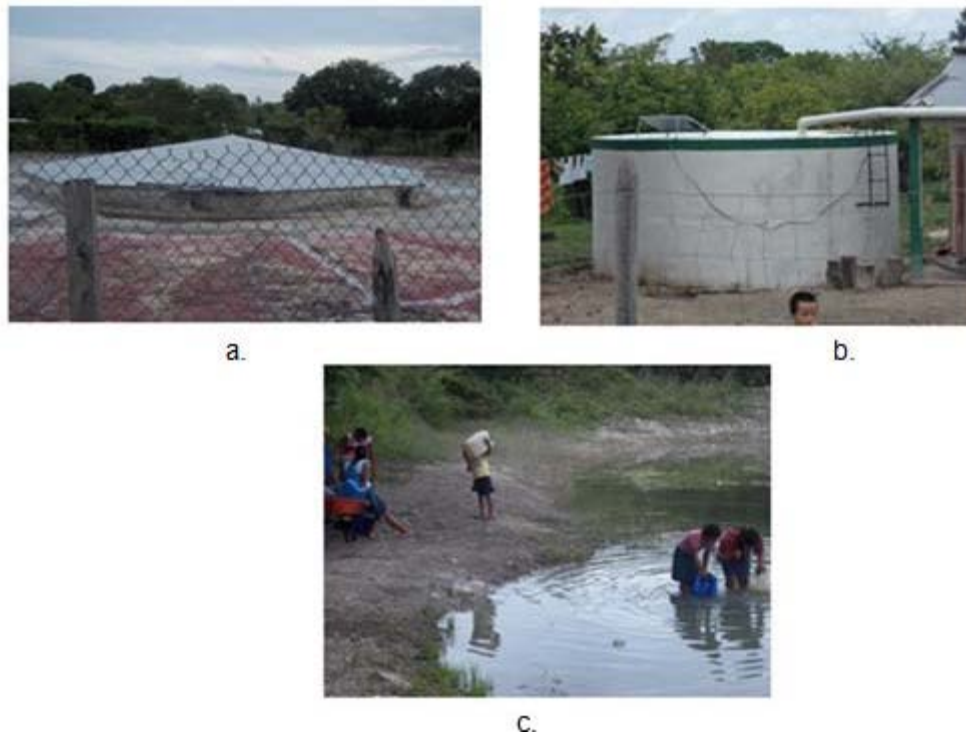
Figura 3.20 Tipos de abastecimiento de agua en la zona de Castillo Brito: (a) aljibe comunitario, (b) captador de agua y (c) habitante recogiendo agua del jagüey.
