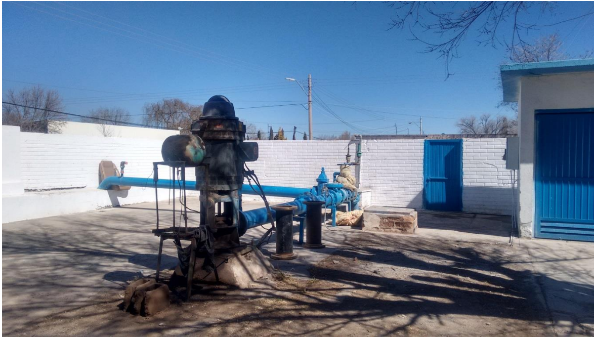
Figura 1.28. Fuente de agua, tren de descarga y línea de conducción, localidad Hidalgo del Parral
