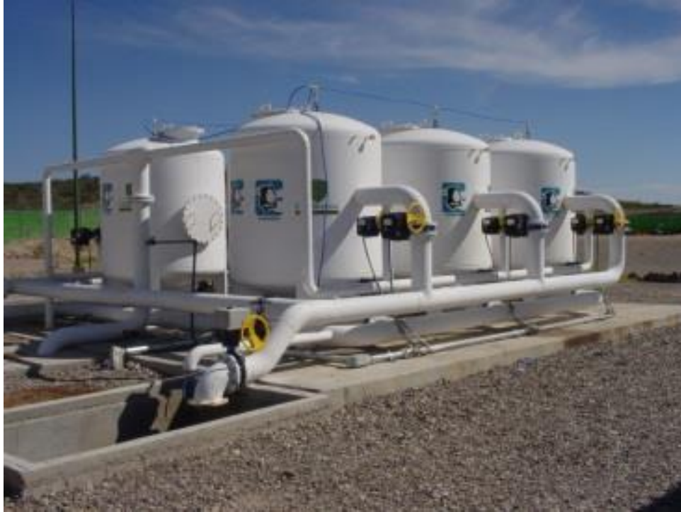
Figura 1.33. Planta potabilizadora para remoción de hierro y manganeso en localidad Camargo
