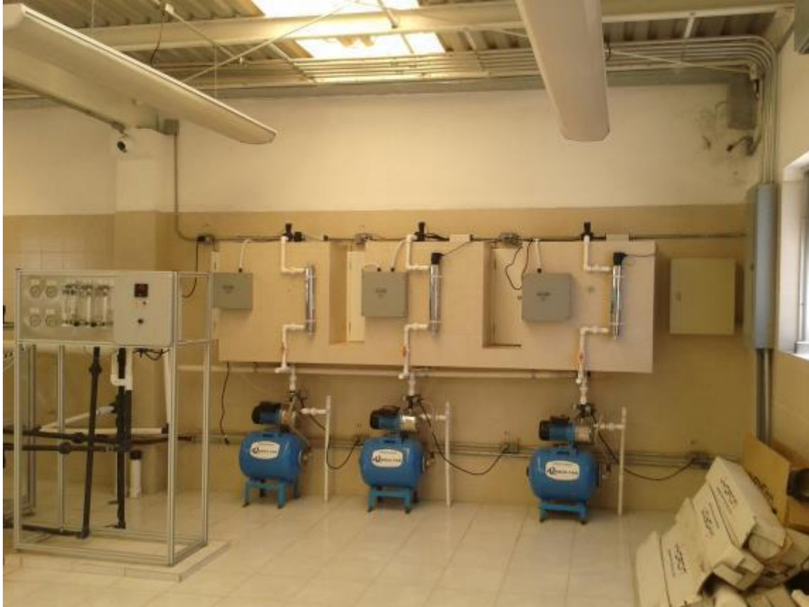
Figura 1.34. Potabilización con gas cloro en tres despachadores, localidad Jiménez
