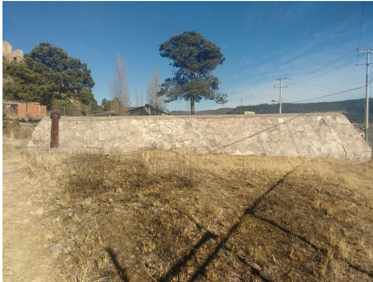
Figura 1.30. Tanque superficial con funcionamiento de almacenamiento y regulación característico de algunas localidades.
