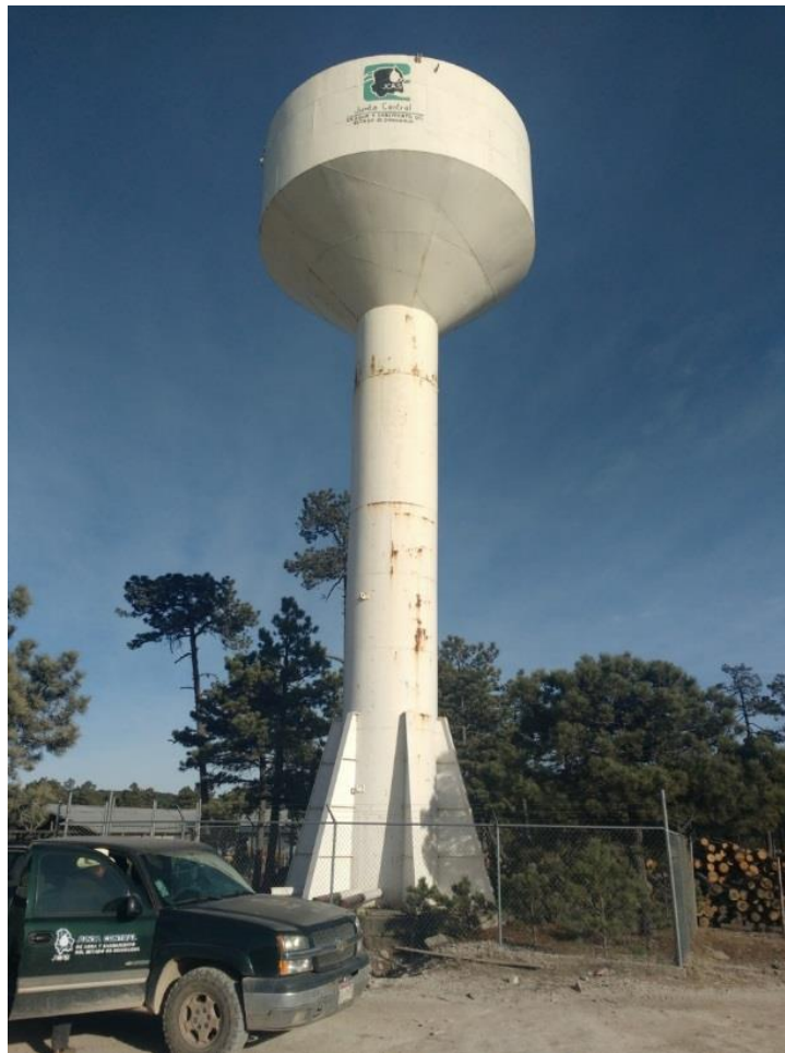
Figura 1.29. Tanque elevado de regulación, localidad San Juanito
