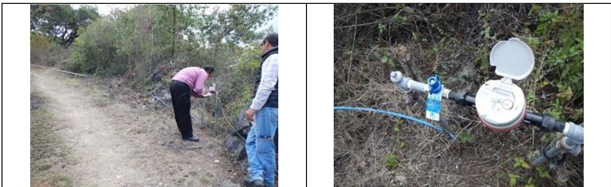
Figura 4. Medidor 176014576, clase C. Predio con toma y detalle de medidor con número de serie. Con VAF. Domicilio conocido S/N. Localidad Peña Alta.
