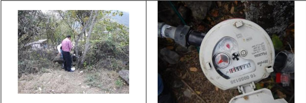
Figura 3. Medidor 160055135, clase C. Predio con toma y detalle de medidor con número de serie. Con VAF y válvula expulsora de aire. Localidad Peña Alta.
