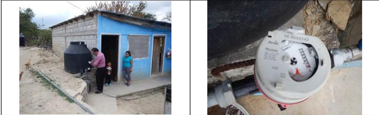
Figura 2. Medidor 160055142, clase C. Predio con toma y detalle de medidor con número de serie. Con VAF. CARR. CARR. FED. SJR-XILITLA NO. S/N, COLONIA SAN MARTIN. Medidor con carátula rota.
