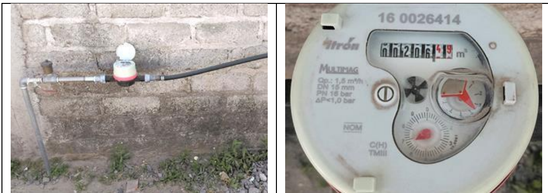
Figura 5. Medidor Itrón, Multimag 160026414, clase C, sin VAF. Cuadro de toma y detalle de medidor con número de serie. Colonia Los Pinos, municipio de Corregidora. Lectura del medidor: 206.49 m 3 . Se encontró que debe corregirse la marca (es Itrón, no Itrón-Actaris) y el modelo (es Multimag, no Medidor de ½" TMII Cycle), en el padrón de usuarios. No se encontró a ninguna persona en el domicilio.
