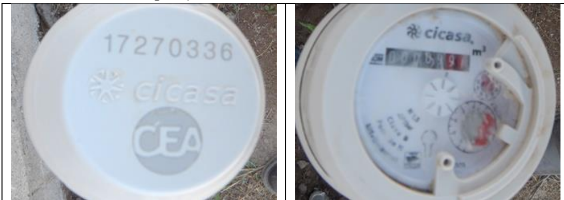
Figura 27. Medidor CICASA, MS Delaunet 17270336, clase B, sin VAF. Detalles de medidor con número de serie. Comunidad La Cueva, municipio de Corregidora. Lectura del medidor: 9.91 m 3 . Se encontró que debe corregirse el modelo (es MS-Delaunet, no Aquarius ½), en el padrón de usuarios. No se encontró a ninguna persona en el domicilio.
