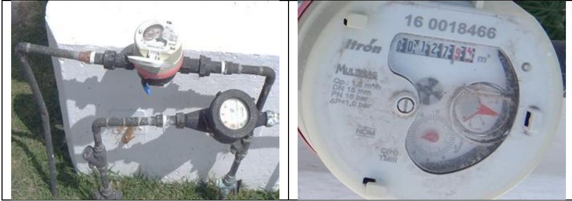
Figura 7. Medidor Itrón, Multimag 160018466, clase C, con VAF2. Cuadro de toma y detalle de medidor con número de serie. Fraccionamiento Pirámides, municipio de Corregidora. Lectura del medidor: 127.94 m 3 . Se encontró que debe corregirse la marca (es Itrón, no SCR) y el modelo (es Multimag, no Anáhuac V), en el padrón de usuarios. No se encontró a ninguna persona en el domicilio.
