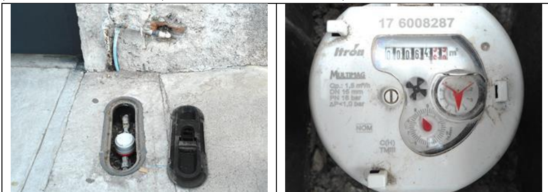
Figura 19. Medidor Itrón, Multimag 161052957, clase C, sin VAF. Cuadro de toma y detalle de medidor con número de serie. Colonia Santa Bárbara, municipio de Corregidora. Lectura del medidor: 98.60 m 3 . Debe registrarse el número de predio (es 17-A) en el padrón de usuarios. El medidor no cuenta ya con tapa para la carátula. Atendió esposa del usuario titular, el cual ya falleció.
