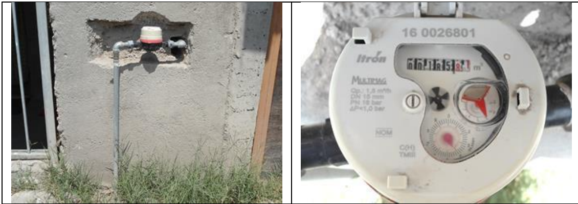
Figura 4. Medidor Itrón, Multimag 160026801, clase C, sin VAF. Cuadro de toma y detalle de medidor con número de serie. Colonia Valle de Aragón, municipio de Corregidora. Lectura del medidor: 185.81 m 3 . Se encontró que debe corregirse la marca (es Itrón, no Itrón-Actaris) y el modelo (es Multimag, no Medidor de ½" TMII Cycle), en el padrón de usuarios. Atendió inquilina del usuario titular.
