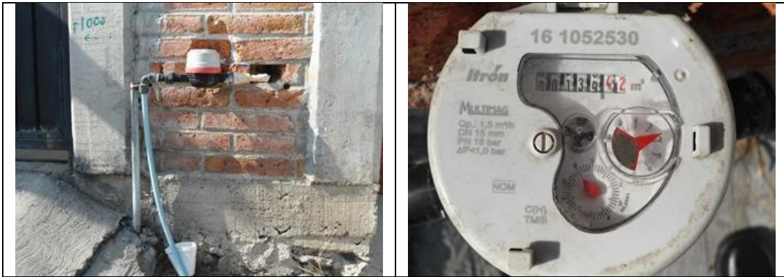
Figura 15. Medidor Itrón, Multimag 161052530, clase C, sin VAF. Cuadro de toma y detalle de medidor con número de serie. Colonia Santa Bárbara, municipio de Corregidora. Lectura del medidor: 139.41 m 3 . Debe corregirse el número de predio (es 56-A y no 49) en el padrón de usuarios. Atendió esposa del usuario titular.
