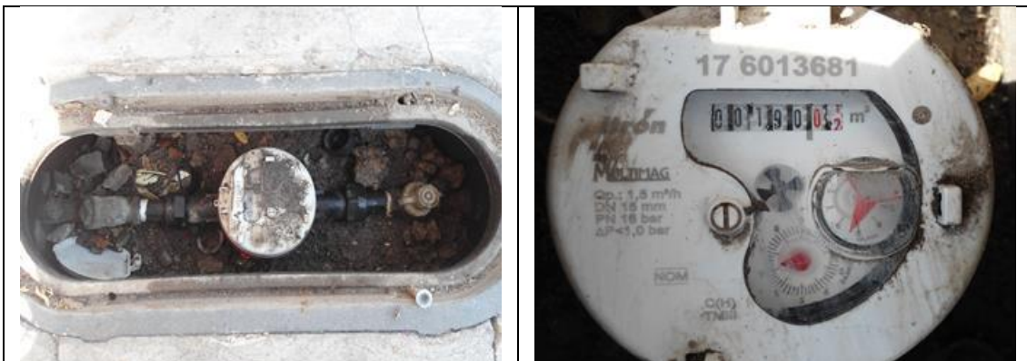
Figura 16. Medidor Itrón, Multimag 176013681, clase C, con VAF2. Registro de toma y detalle de medidor con número de serie. Colonia Santa Bárbara, municipio de Corregidora. Lectura del medidor: 190.01 m 3 . Debe corregirse el número de predio (es 40 y no 24) en el padrón de usuarios. Se encontró registro azolvado y el medidor no cuenta ya con tapa para la carátula. Atendió familiar del usuario titular.
