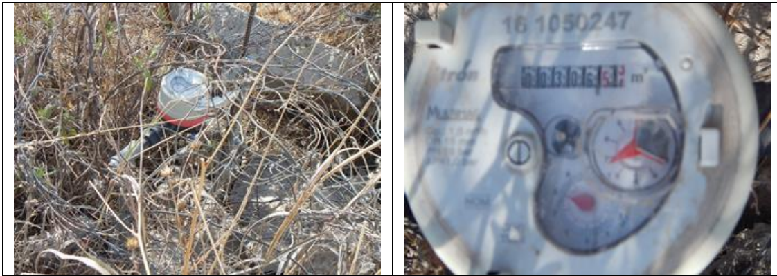
Figura 1. Medidor Itrón, Multimag 161050247, clase C, sin VAF. Cuadro de toma y detalle de medidor con número de serie. Comunidad Pita, municipio de Corregidora. Lectura del medidor: 306.51 m 3 . No se encontró a ninguna persona en el domicilio.
