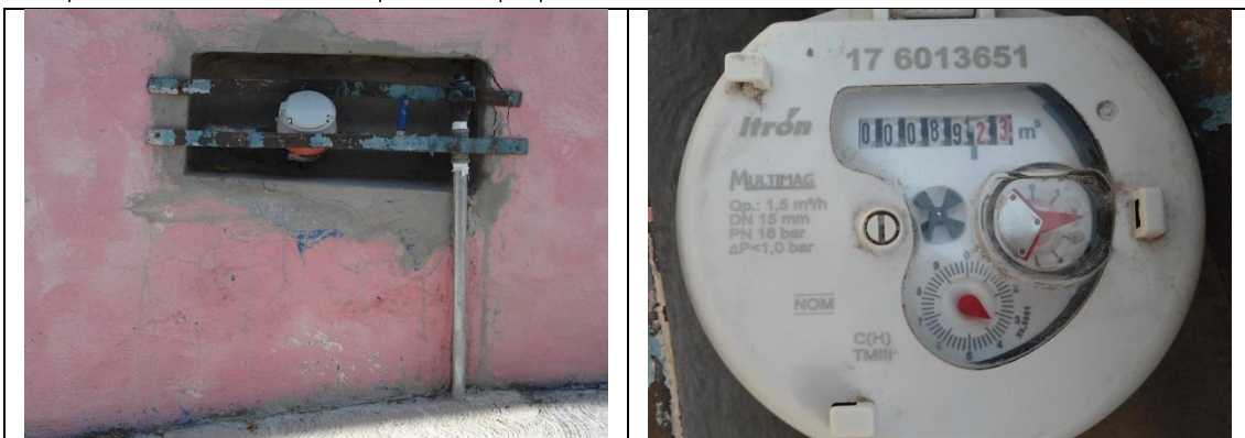
Figura 17. Medidor Itrón, Multimag 176013651, clase C, sin VAF. Cuadro de toma y detalle de medidor con número de serie. Colonia Santa Bárbara, municipio de Corregidora. Lectura del medidor: 89.23 m 3 .
