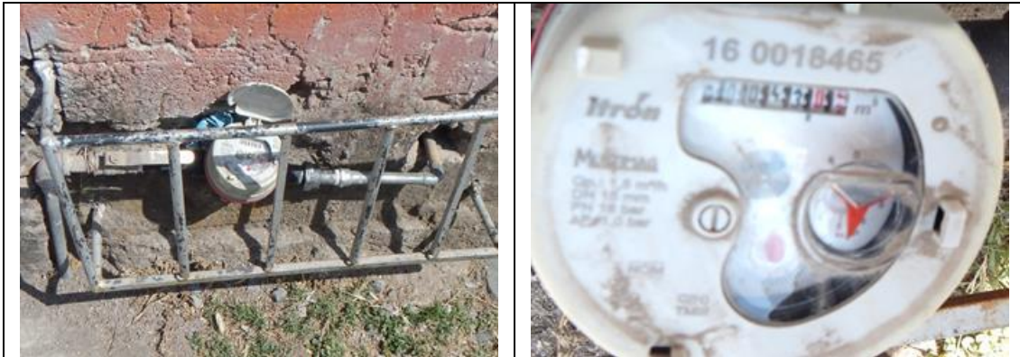
Figura 10. Medidor Itrón, Multimag 160018465, clase C, sin VAF. Cuadro de toma y detalle de medidor con número de serie. Comunidad Charco Blanco, municipio de Corregidora. Lectura del medidor: 43.01 m 3 . Se encontró que debe corregirse la marca (es Itrón, no SCR) y el modelo (es Multimag, no Anáhuac V), en el padrón de usuarios. Atendió usuario actual, el titular del contrato ya falleció.
