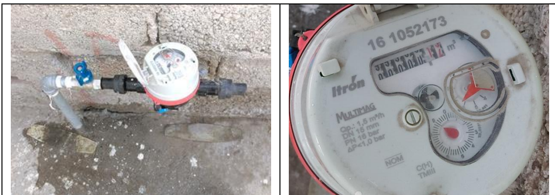
Figura 6. Medidor Itrón, Multimag 161052173, clase C, con VAF1. Cuadro de toma y detalle de medidor con número de serie. Colonia Los Pinos, municipio de Corregidora. Lectura del medidor: 0.13 m 3 . Se
