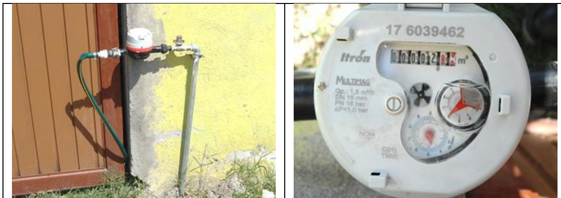
Figura 3. Medidor Itrón, Multimag 176039462, clase C, con VAF2. Cuadro de toma y detalle de medidor con número de serie. Colonia Lomas de la Cruz, municipio de Corregidora. Lectura del medidor: 2.85 m 3 . Atendió inquilina del usuario titular.
