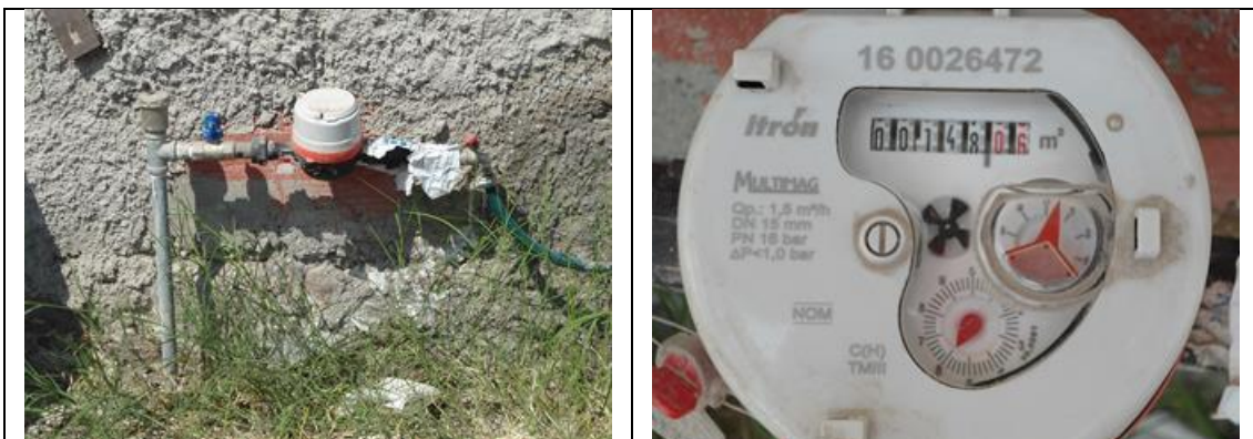
Figura 11. Medidor Itrón, Multimag 176007360, clase C, sin VAF. Cuadro de toma y detalle de medidor con número de serie. Colonia El Pueblito, municipio de Corregidora. Lectura del medidor: 146.66 m 3 . Atendió usuario.
