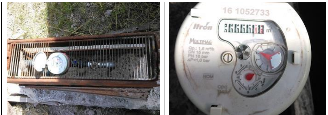
Figura 2. Medidor Itrón, Multimag 161052733, clase C, con VAF2. Cuadro de toma y detalle de medidor con número de serie. Comunidad Colinas de los Ángeles, municipio de Corregidora. Lectura del medidor: 0.05 m 3 . No se encontró a ninguna persona en el domicilio.
