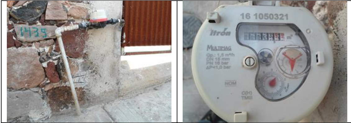
Figura 29. Medidor Itrón, Multimag 161050321, clase C, sin VAF. Cuadro de toma y detalle de medidor con número de serie. Colonia Santa Bárbara, municipio de Corregidora. Lectura del medidor: 53.99 m³. No se encontró a ninguna persona en el domicilio.
