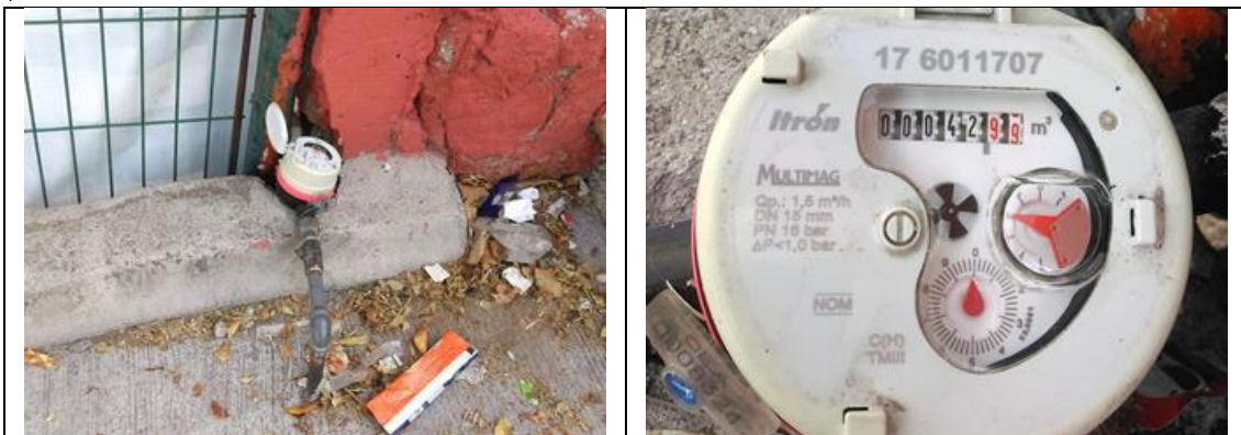
Figura 8. Medidor CICASA, MS Delaunet 16358373, clase B, sin VAF. Detalles de medidor con número de serie. Comunidad La Purísima de la Cueva, municipio de Corregidora. Lectura del medidor: 33.66 m 3 . Se encontró que debe corregirse la marca (es Cicasa, no Itrón) y el modelo (es MS-Delaunet, no Multimag), en el padrón de usuarios. Atendió usuario.
