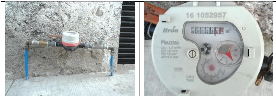
Figura 19. Medidor Itrón, Multimag 161052957, clase C, sin VAF. Cuadro de toma y detalle de medidor con número de serie. Colonia Santa Bárbara, municipio de Corregidora. Lectura del medidor: 98.60 m 3 . Debe registrarse el número de predio (es 17-A) en el padrón de usuarios. El medidor no cuenta ya con tapa para la carátula. Atendió esposa del usuario titular, el cual ya falleció.
