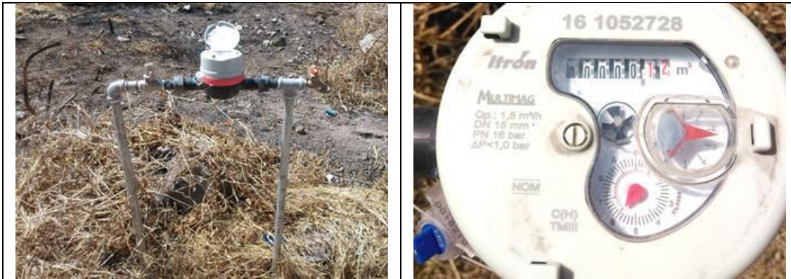
Figura 26. Medidor Itrón, Multimag 161052728, clase C, con VAF2. Cuadro de toma y detalle de medidor con número de serie. Comunidad Colinas de los Ángeles, municipio de Corregidora. Lectura del medidor: 0.12 m 3 . Se encontró que debe corregirse el modelo (es Multimag, no Itrón Multimag), en el padrón de usuarios. No se encontró a ninguna persona en el domicilio.
