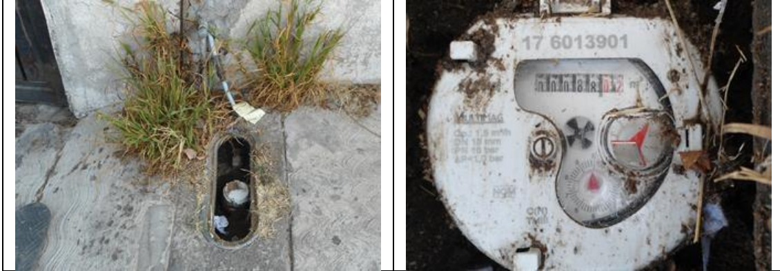
Figura 18. Medidor Itrón, Multimag 176013901, clase C, con VAF2. Registro de toma y detalle de medidor con número de serie. Colonia Santa Bárbara, municipio de Corregidora. Lectura del medidor: 88.02 m 3 . Debe registrarse el número de predio (es 73-A) en el padrón de usuarios. Se encontró el registro azolvado. No se encontró a ninguna persona en el domicilio.
