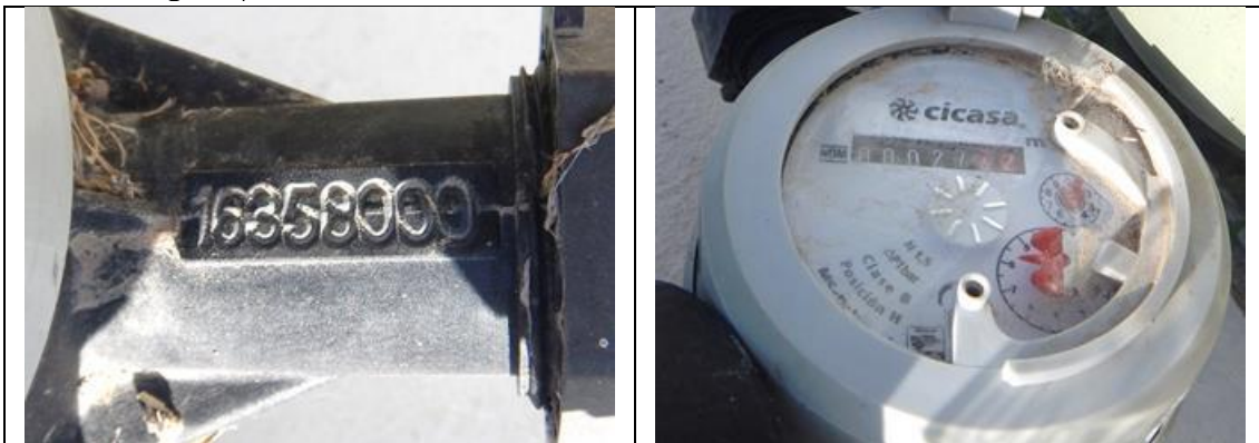
Figura 30. Medidor CICASA, MS Delaunet 16358000, clase B, sin VAF. Detalles de medidor con número de serie. Fraccionamiento Las Trojes, municipio de Corregidora. Lectura del medidor: 27.42 m³. Se encontró que debe corregirse la marca (es Cicasa, no Itrón) y el modelo (es MS-Delaunet, no Multimag), en el padrón de usuarios. No se encontró a ninguna persona en el domicilio.
