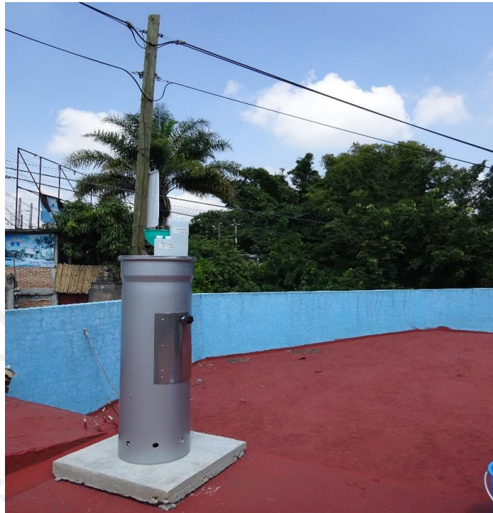
Figura 146 Colector instalado en Temixco, Morelos
