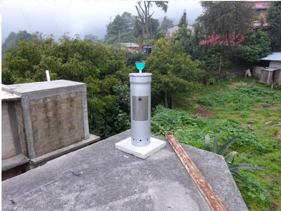
Figura 143 Colector instalado en Huitzilac, Morelos
