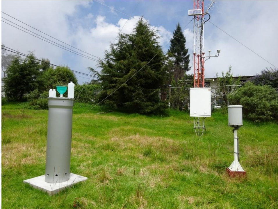
Figura 141 Colector instalado en tres marías, Huitzilac, Morelos
