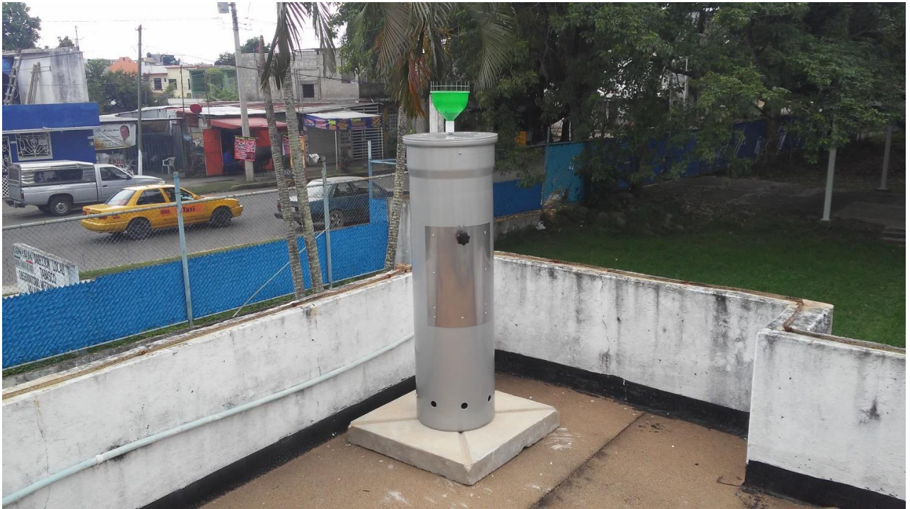
Figura 98 Colector de lluvia en el Observatorio de Villahermosa.
