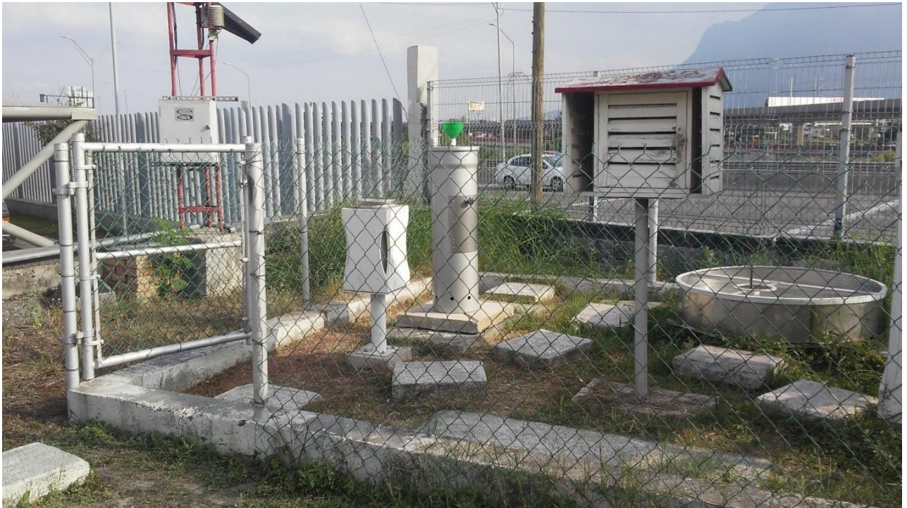
Figura 76 Colector de lluvia en el Observatorio de Monterrey.
