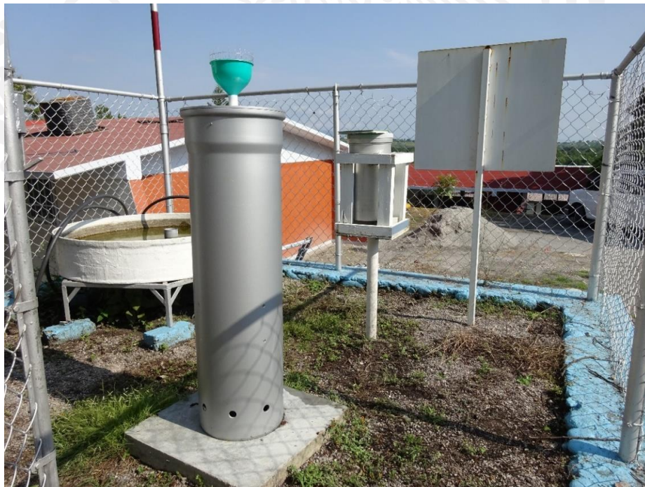
Figura 145 Colector instalado en Alpuyec, Morelos
