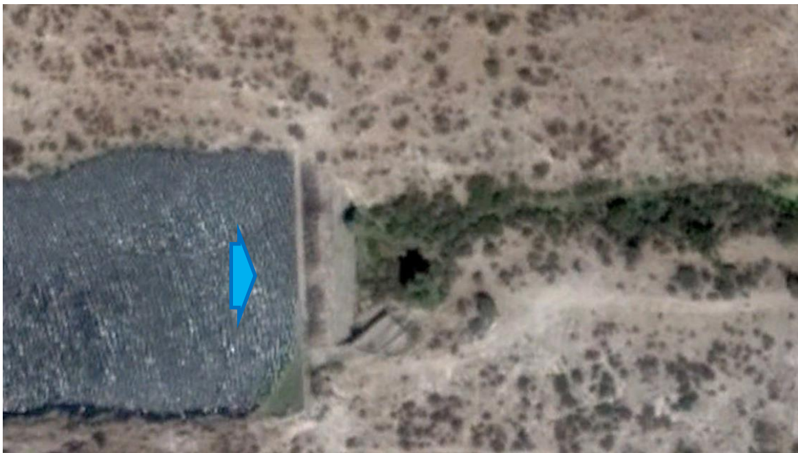
Figura VI.1 Vista aérea de la cortina de la presa San Juan de Coyotillos y su estructura disipadora.
