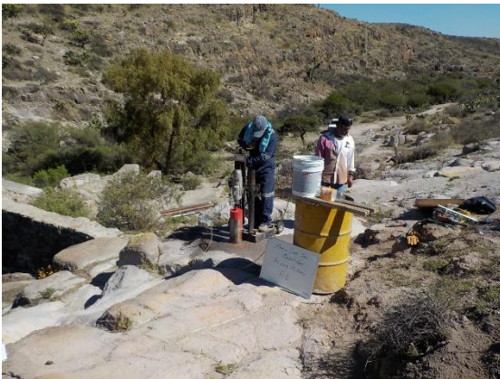
Fotografía III.22 Extracción de núcleo de roca en el terreno de cimentación.
