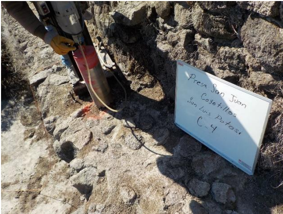
Fotografía III.20 Extracción de núcleo de mampostería en la cortina de la presa.
