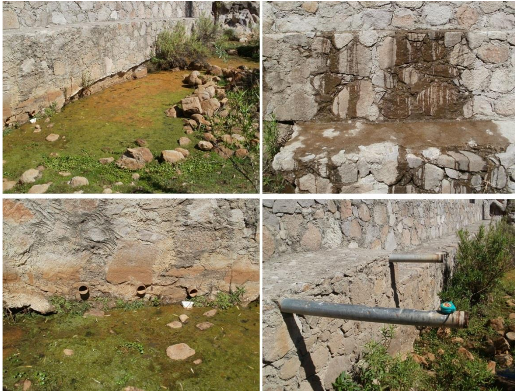
Fotografía VII.4. Filtraciones y tubos de toma para abrevadero.
