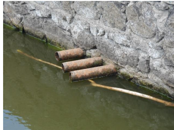
Fotografía II.35 Aspecto de los tubos de la obra de toma aguas arriba de la cortina.
