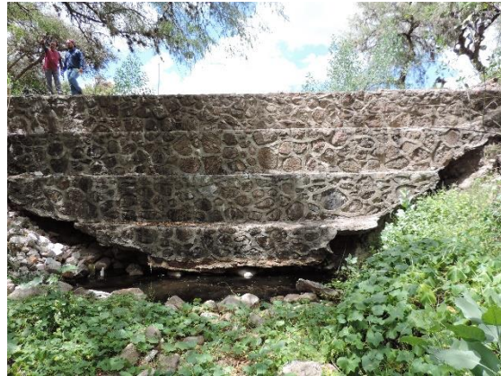
Fotografía II.51 Socavación en la base de la mampostería de la presa CONAZA 2.
