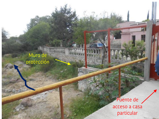
Fotografía II.48 Casa particular que se ve afectada por el agua en cada vertida de la presa.
