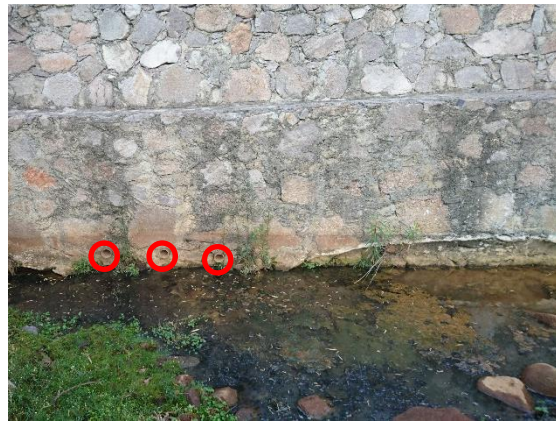
Fotografía VI.12 Tuberías en la parte baja, al centro de la estructura escalonada.
