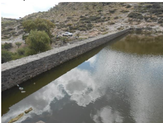
Fotografía II.10 Panorámica del paramento aguas arriba desde margen izquierda.
