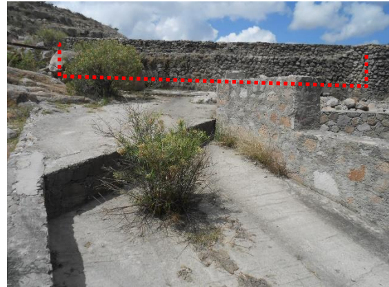
Fotografía VI.6 Ventana sobre la cortina para la operación del vertedor.
