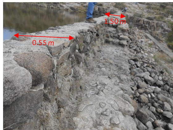
Fotografía II.11 Aspecto de la parte inconclusa en la sobre elevación de 1991.
