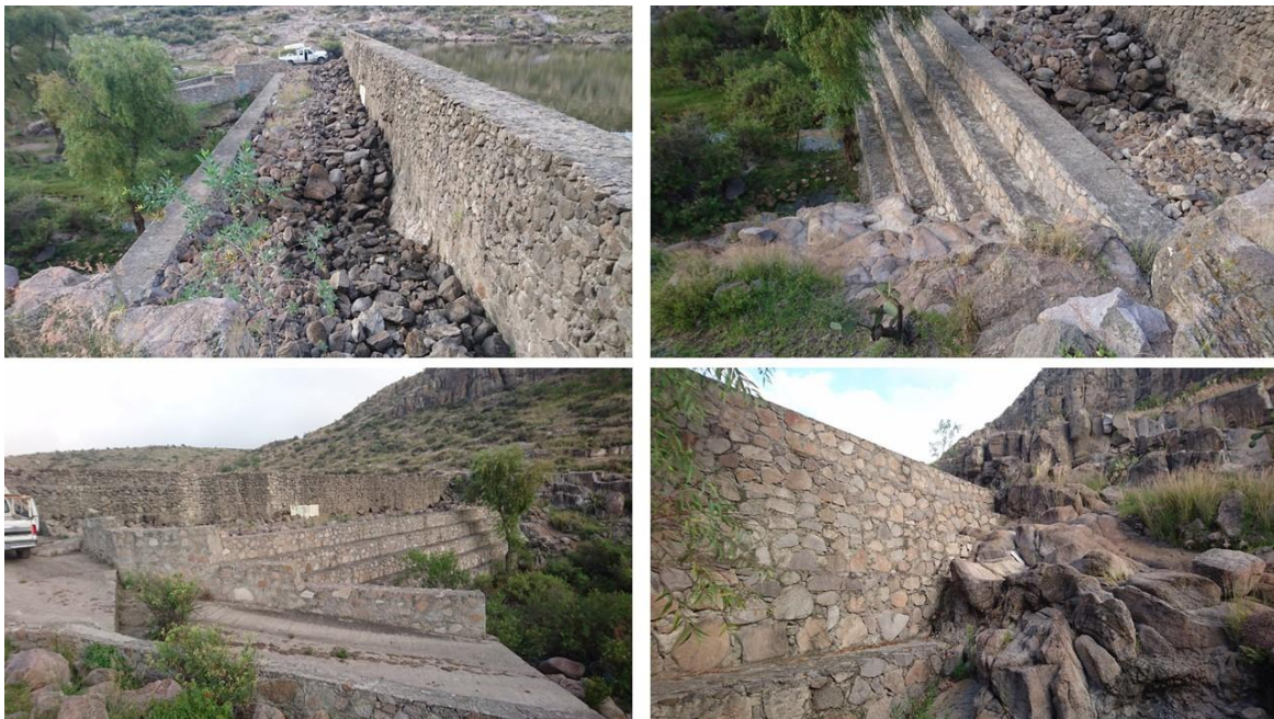
Fotografía VII.6. El muro aguas arriba descende a 45° hacia aguas abajo, en tanto que el muro aguas abajo descende de manera escalonada hasta el desplante a la 1872 msnm.
