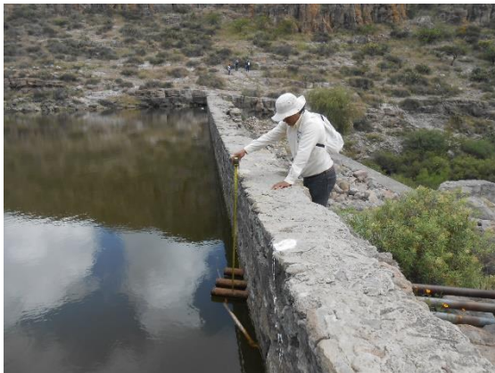
Fotografía VI.7 Tubos de acero que se utilizan para la extracción del agua del embalse.
