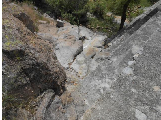
Fotografía II.27 Empotramiento izquierdo de la estructura escalonada.
