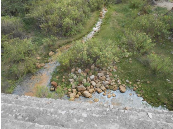
Fotografía II.22 Laguna por filtraciones al pie de la estructura escalonada.
