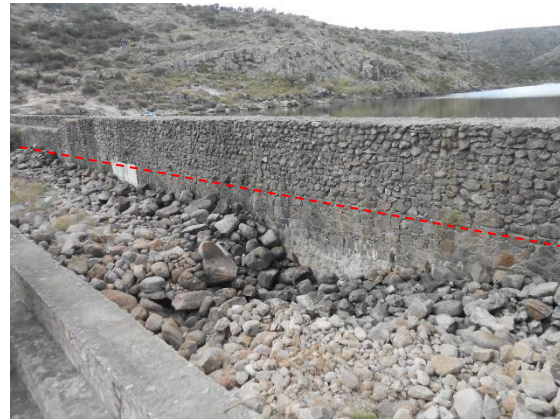
Fotografía II.9 Aspecto de la parte sobre elevada en 1991.
