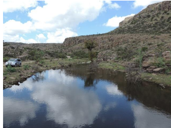
Fotografía II.43 Embalse de la presa denominada CONAZA 1.
