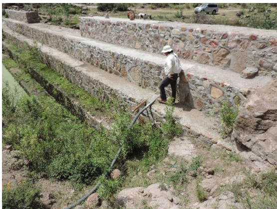
Fotografía VI.9 Extracción de agua de la obra de toma, en la presa CONAZA 1.
