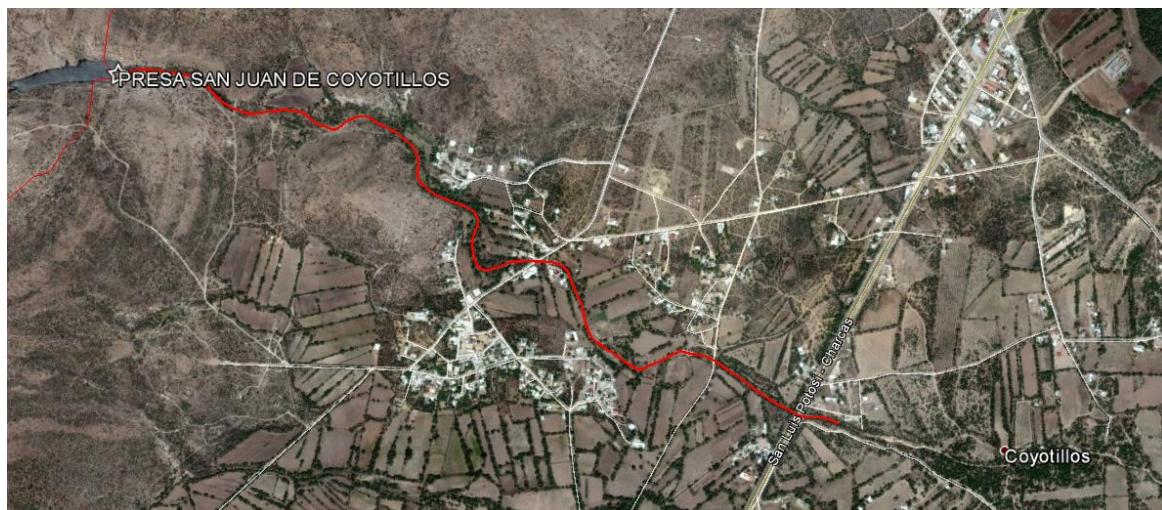
Figura III.6 Trazo del levantamiento sobre el cauce aguas abajo de la presa San Juan de Coyotillos.
