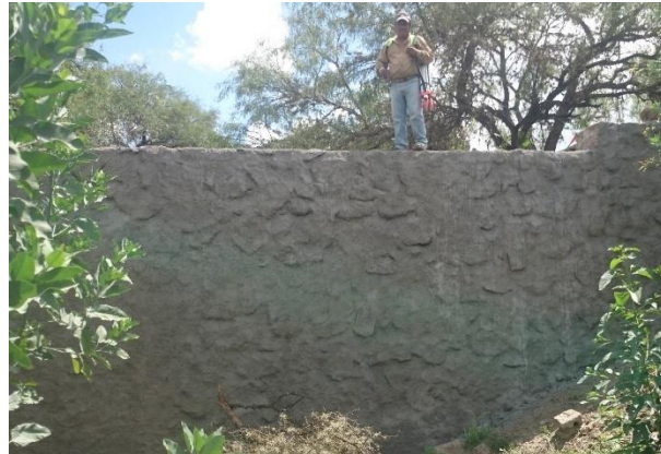
Fotografía III.17 Cortina (CONAZA 2) sobre el cauce, cadenamiento 2+269.
