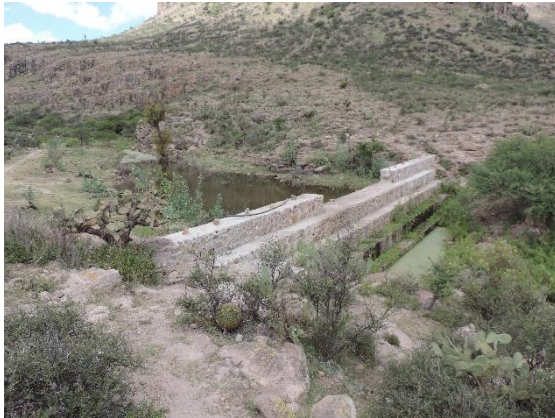
Fotografía II.42 Cortina CONAZA 1, 300 m aguas abajo de la presa San Juan de Coyotillos.
