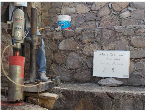
Fotografía III.24 Extracción de núcleo de roca en el terreno de cimentación.
