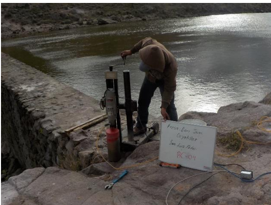
Fotografía III.30 Extracción de núcleo en la zona de contacto de la cortina con la roca.
