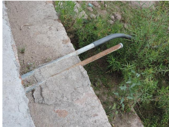
Fotografía II.39 Manguera de neopreno insertada en uno de los tubos de la obra de toma.
