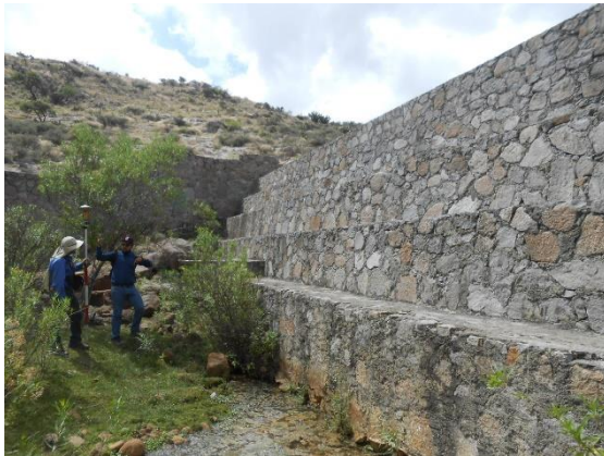
Fotografía VI.2 Estructura escalonada frente a la cortina original.
