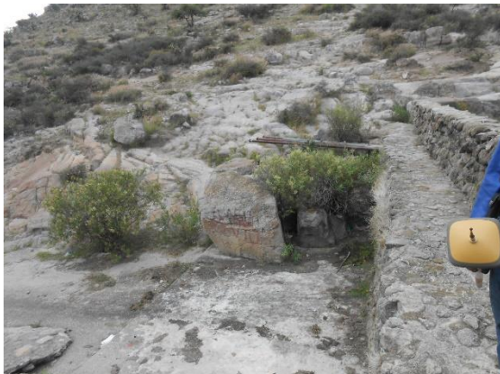
Fotografía II.24 Empotramiento de la cortina original del lado derecho.
