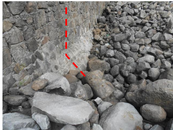
Fotografía II.13 Inflexión en el paramento aguas abajo de la cortina original.
