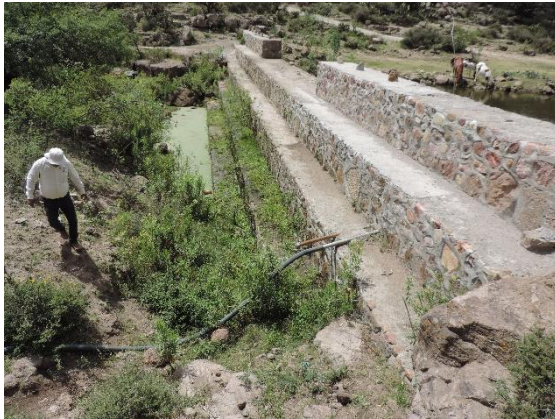
Fotografía II.38 Obra de toma de la presa ubicada aguas abajo de la presa Coyotillos, construida por CONAZA (CONAZA 1).
