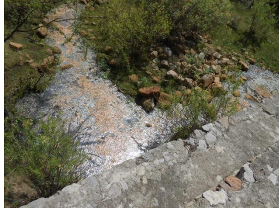
Fotografía II.33 Laguna con hasta 2 m de profundidad al pie de la estructura escalonada.
