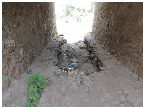
Fotografía II.53 Deterioro de la plantilla de mampostería de la alcantarilla.
