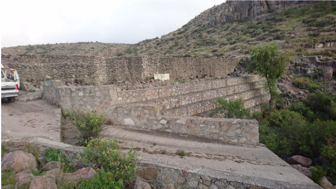
Fotografía VI.4 Panorámica del canal de descarga del vertedor inconcluso.
