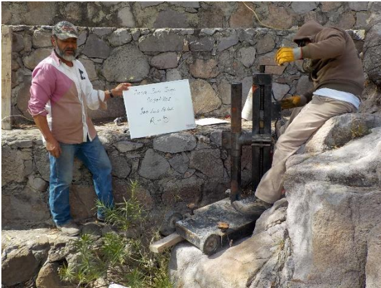
Fotografía III.26 Extracción de núcleo de roca en el terreno de cimentación.
