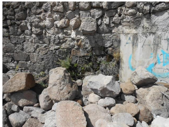
Fotografía II.21 Lloraderos en la parte central de la cortina original.
