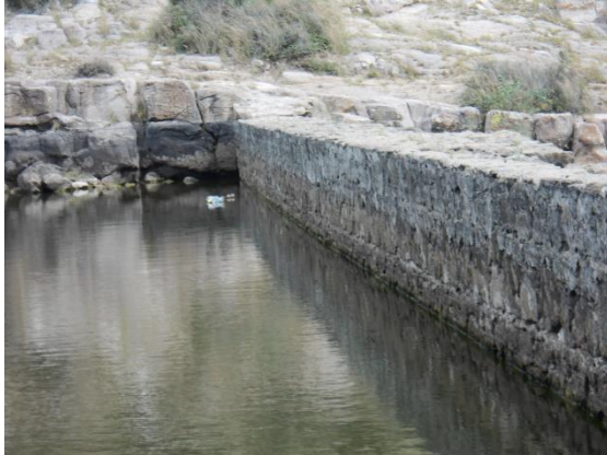
Fotografía II.26 Aspecto del empotramiento izquierdo aguas arriba.
