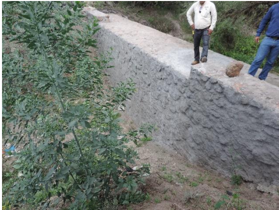
Fotografía II.50 Paramento aguas arriba de la presa CONAZA 2.
