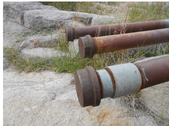
Fotografía II.37 Tapones roscados en la descarga de los tubos de la obra de toma.
