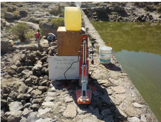
Fotografía III.18 Extracción de núcleo de mampostería en la cortina de la presa.
