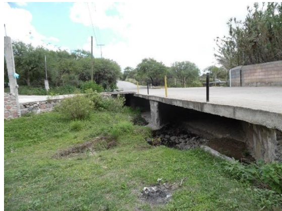
Fotografía III.15 Puente-vado de concreto, cadenamiento 1+445.
