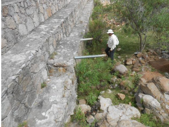
Fotografía II.18 Drenes de desagüe en el extremo derecho de la estructura escalonada.
