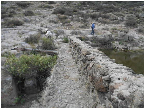
Fotografía II.36 Descarga de los tubos de la obra de toma aguas abajo de la cortina.
