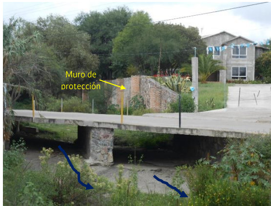
Fotografía II.46 Puente-vado sobre el cauce en el cadenamiento 1+440.
