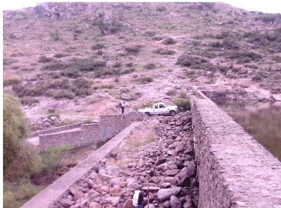
Fotografía III.6 Levantamiento topográfico del canal de descarga del vertedor inconcluso.
