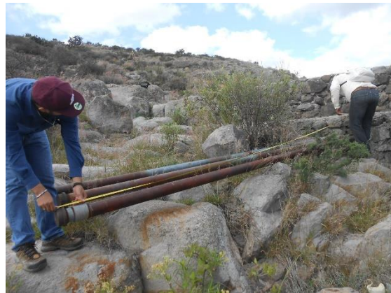
Fotografía VI.8 Tubos de acero de la obra de toma en la parte de la descarga.
