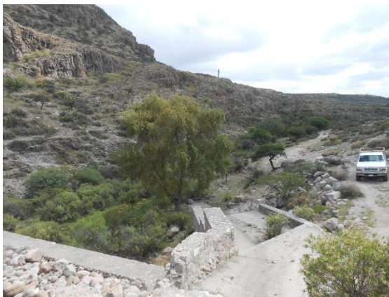
Fotografía II.28 Canal de descarga en el extremo derecho de la estructura escalonada.
