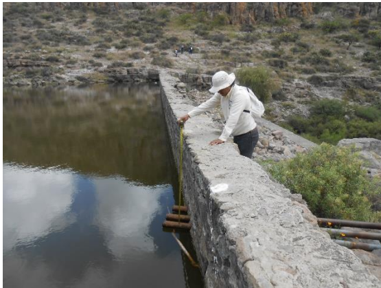
Fotografía II.34 Ubicación de los tubos que forman la obra de toma.
