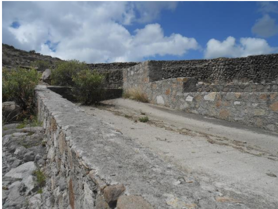
Fotografía II.30 Aspecto del canal de descarga sobre la ladera derecha.
