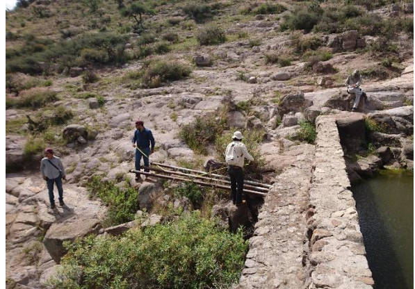
Fotografía III.5 Levantamiento de los tubos que forman la obra de toma.
