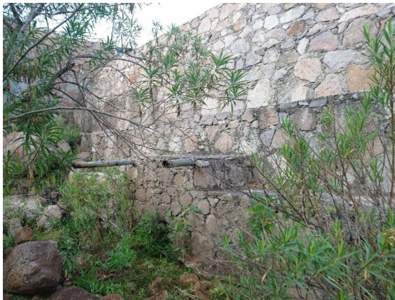
Fotografía VI.11 Tuberías en la parte baja, extremo derecho de la estructura escalonada.
