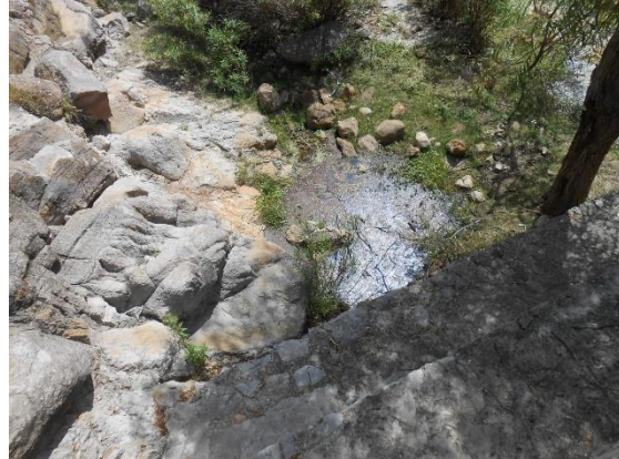
Fotografía II.23 Laguna por filtraciones, en el extremo izquierdo de la estructura escalonada.
