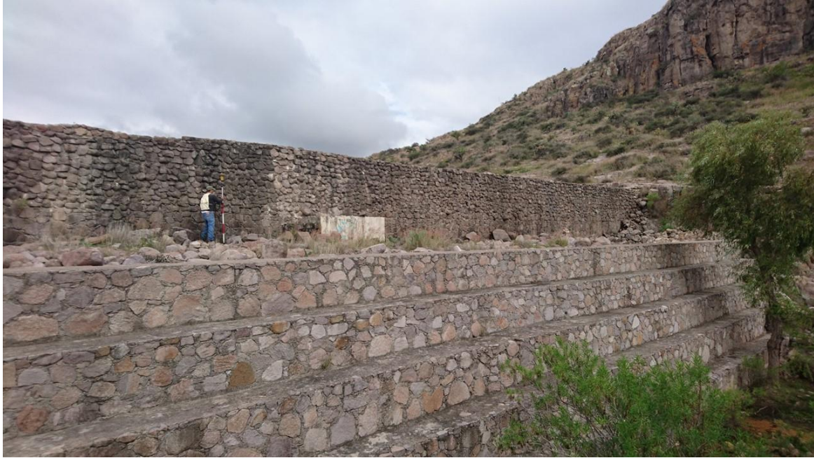
Fotografía VII.3. La cortina es una gran masa formada por dos cuerpos y relleno.
