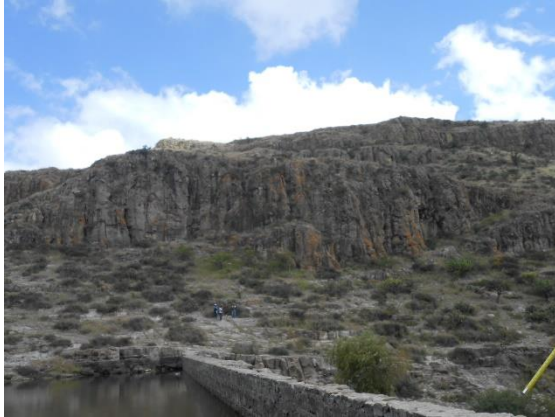
Fotografía II.6 Panorámica de la ladera en margen izquierda.
