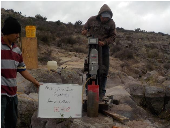
Fotografía III.28 Extracción de núcleo en la zona de contacto de la cortina con la roca.
