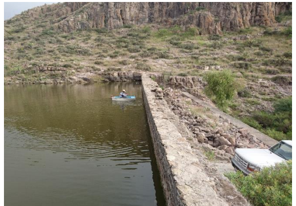
Fotografía III.7 Medición del nivel del azolve en el embalse de la presa San Juan de Coyotillos.
