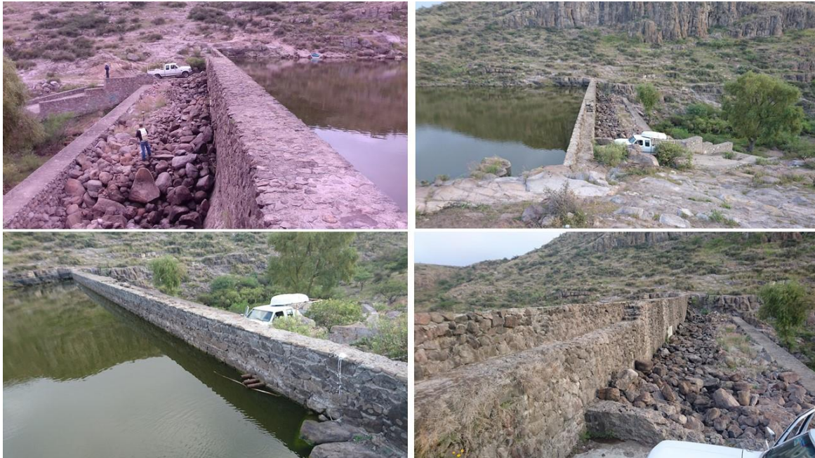
Fotografía VII.5. La cortina es una gran masa con boleo y bloques de roca entre los dos cuerpos.
