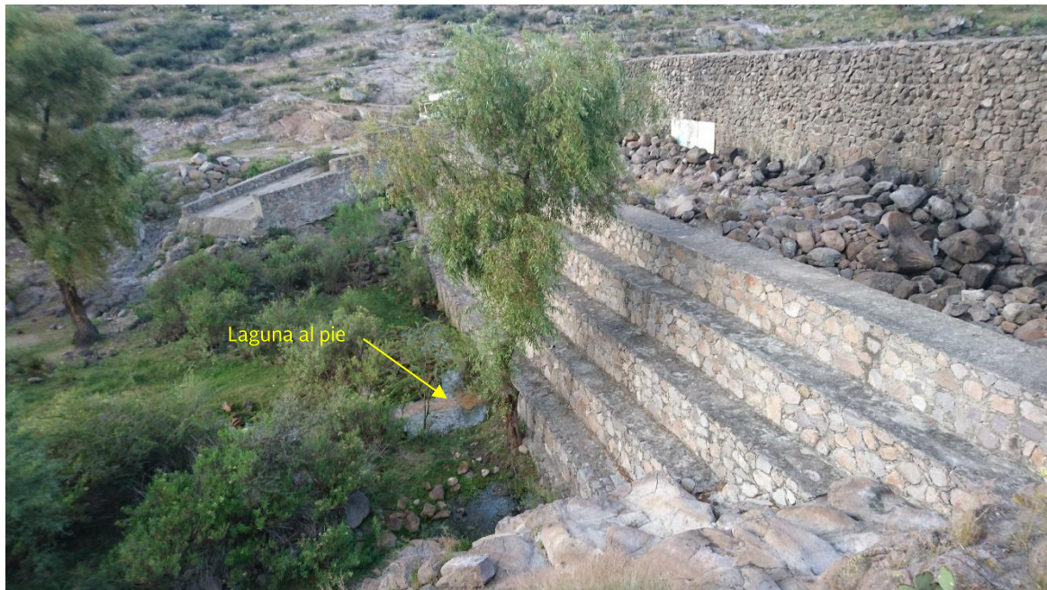
Fotografía VI.1 Panorámica de la cortina vertedora y la estructura escalonada.
