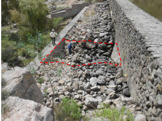
Fotografía II.32 Zona del tanque con falta de enrocamiento.
