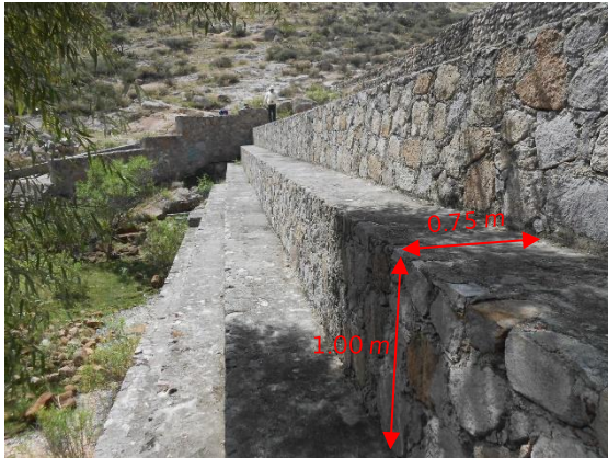
Fotografía II.14 Aspecto de la estructura escalonada aguas abajo de la cortina.
