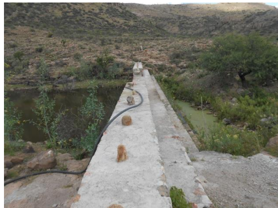
Fotografía VI.10 Manguera de neopreno para la extracción del agua de la presa CONAZA 1.
