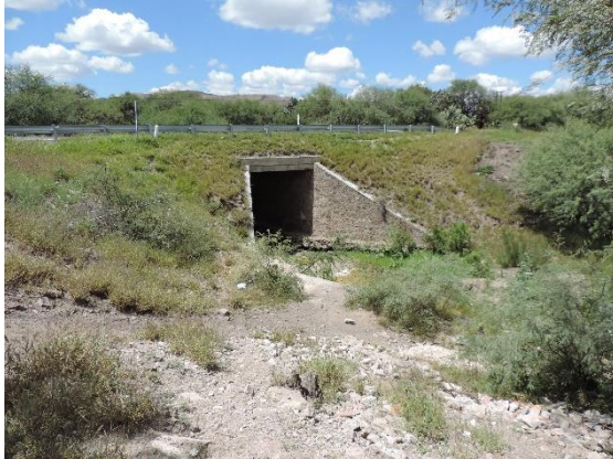
Fotografía VI.19 Cruce del arroyo por una alcantarilla de la carretera federal 63.
