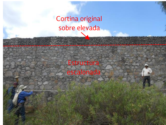
Fotografía II.17 Aspecto del paramento aguas abajo de la estructura escalonada.
