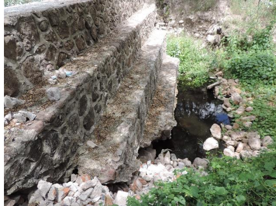
Fotografía VI.20 Cortina en peligro de falla ubicada 100 m aguas arriba de la alcantarilla.
