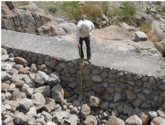
Fotografía II.16 Aspecto del paramento aguas arriba de la estructura escalonada.
