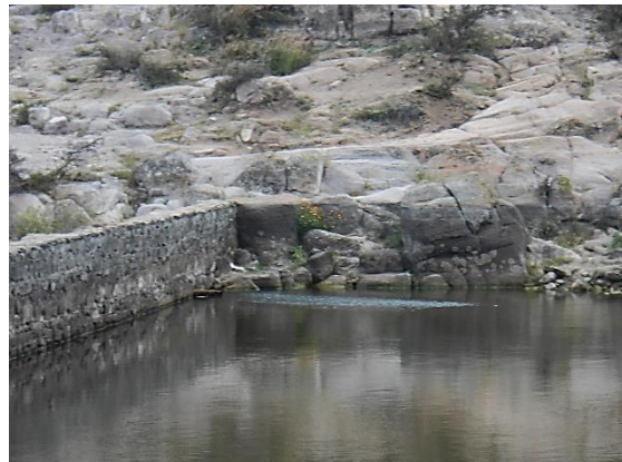
Fotografía II.25 Aspecto del empotramiento derecho de la cortina original aguas arriba.
