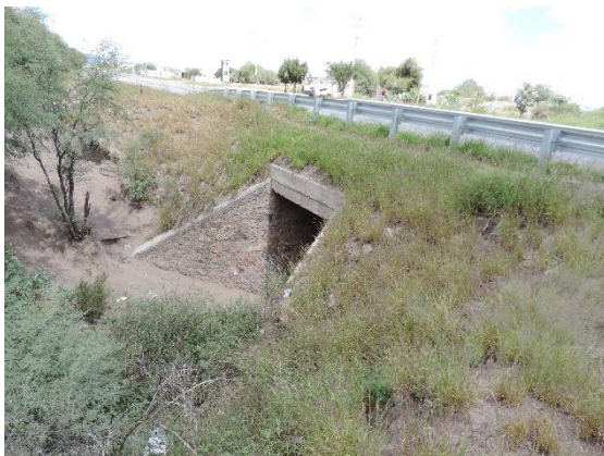
Fotografía II.52 Alcantarilla bajo la carretera federal 63, San Luis Potosí-Charcas.
