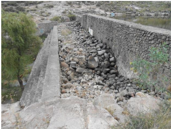
Fotografía II.8 Panorámica de la presa desde margen izquierda.
