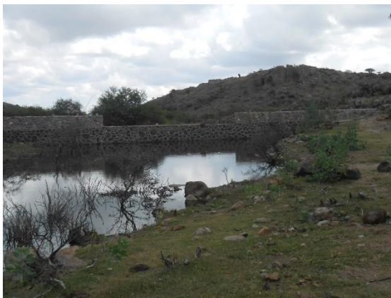
Fotografía VI.15 Presa construida por la CONAZA, ubicada 300 m aguas abajo.
