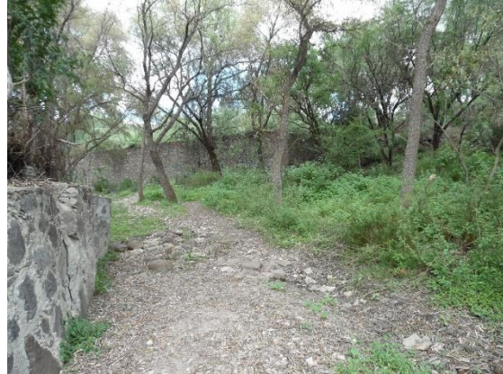
Fotografía III.13 Muro de protección, cadenamiento 1+130.
