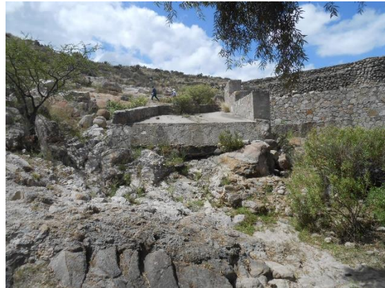
Fotografía II.31 Aspecto de la zona de descarga al cauce.
