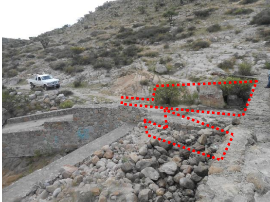
Fotografía VI.5 Estructuras faltantes para la conexión del vertedor a la cortina
