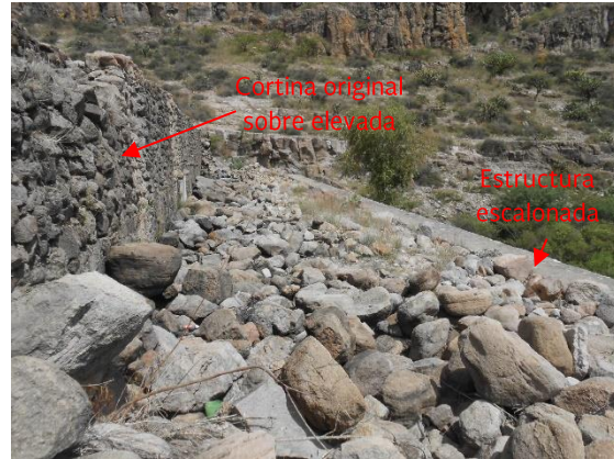
Fotografía II.15 Relleno de boleos entre la cortina original y la estructura escalonada.
