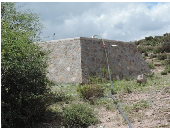
Fotografía II.40 Suministro de agua al tanque de almacenamiento de San Juan de Coyotillos.
