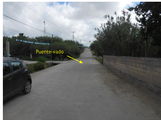
Fotografía II.49 Carretera hacia a Ahualulco sobre la que se ubica el puente-vado.
