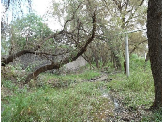
Fotografía III.12 Cruce elevado de la línea de conducción de agua, cadenamiento 1+060.
