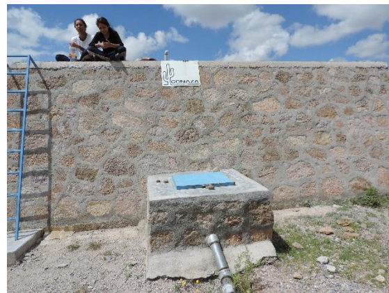
Fotografía VI.16 Tanque de almacenamiento construido por la CONAZA.
