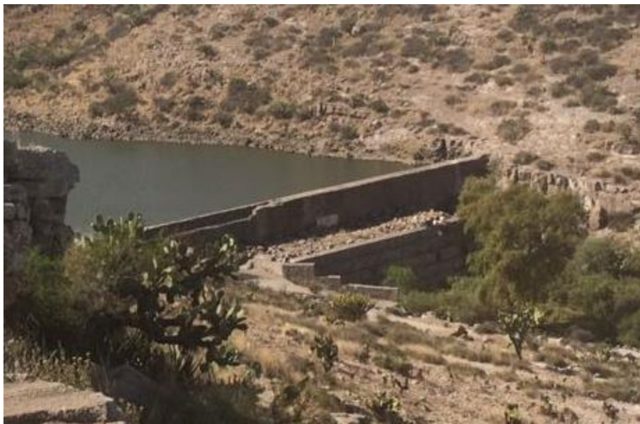
Fotografía II.1. Panorámica de la presa Coyotillos.
