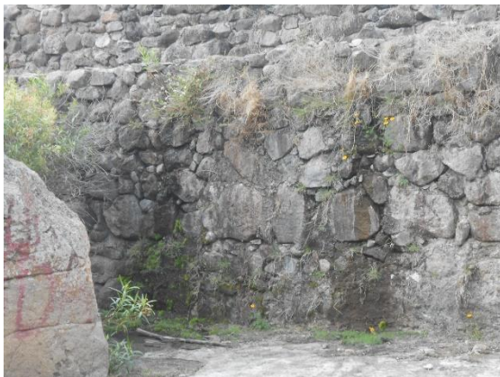
Fotografía II.20 Humedades en el lado derecho de la cortina original.
