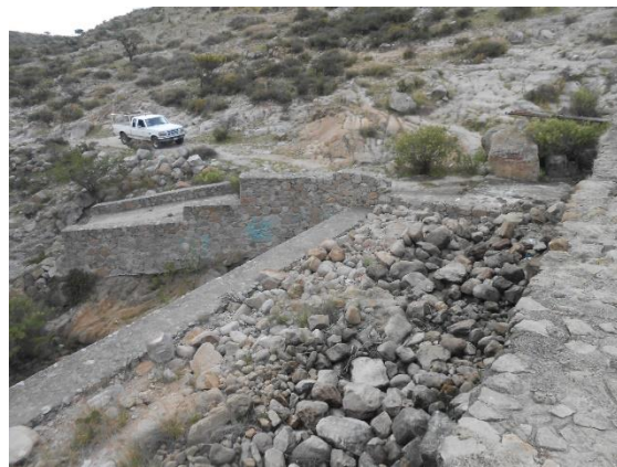
Fotografía II.29 Vista del canal de descarga desde la corona de la cortina sobre elevada.
