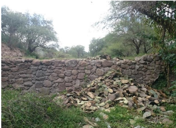
Fotografía III.16 Camino de mampostería atravesando el cauce, cadenamiento 2+075.
