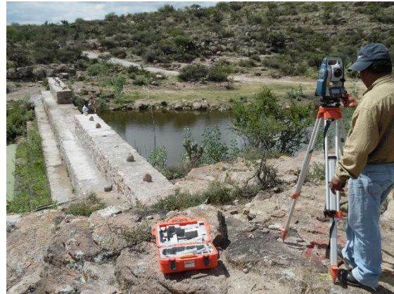
Fotografía III.9 Cortina aguas abajo de la presa principal, cadenamiento km 0+330.
