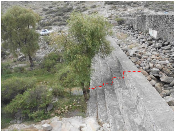
Fotografía II.12 Estructura escalonada aguas abajo de la cortina.
