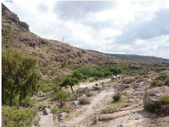
Fotografía VI.17 Aspecto del cauce inmediatamente aguas abajo de la presa.
