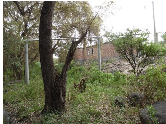
Fotografía II.45 Cruce elevado de la línea de conducción, en el cadenamiento 1+060.
