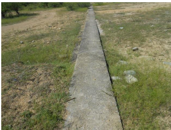
Fotografía II.34 Espigón de concreto en la sección de control del vertedor.
