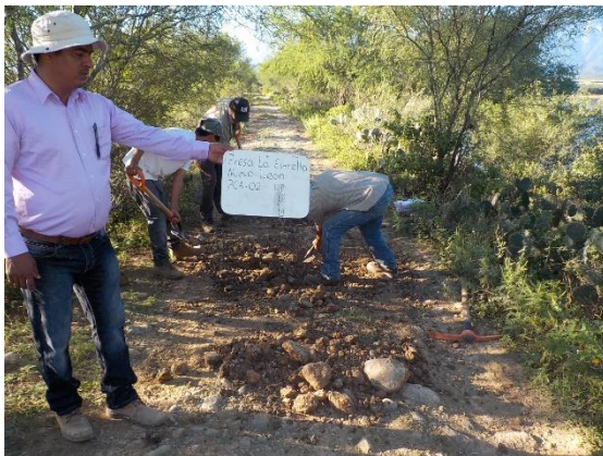
Fotografía III.16 Excavación del PCA-2 en la
