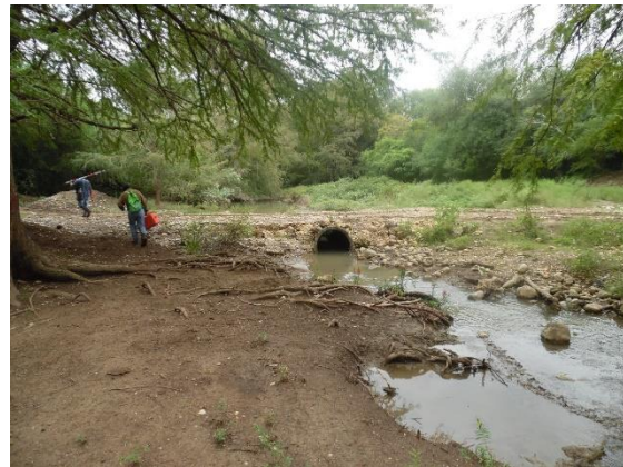
Fotografía III.13 Cadenamiento 3+360, alcantarilla sobre el cauce.
