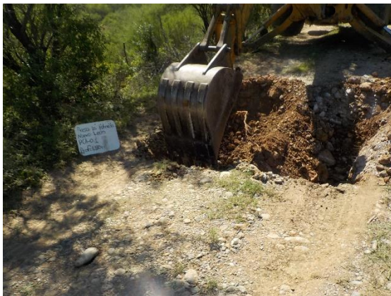
Fotografía III.14 Excavación del PCA-1 en la corona de la cortina.
