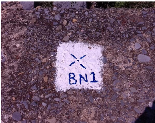
Fotografía III.2 Banco de Nivel BN1 en el extremo derecho de la presa La Estrella.
