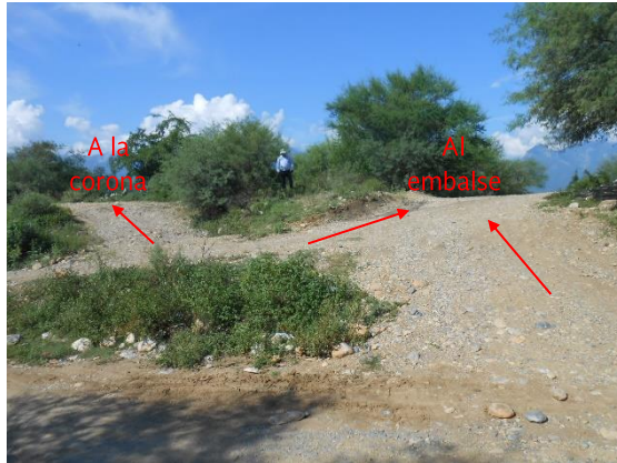
Fotografía II.24 Corte para subir a la corona y para pasar al embalse.
