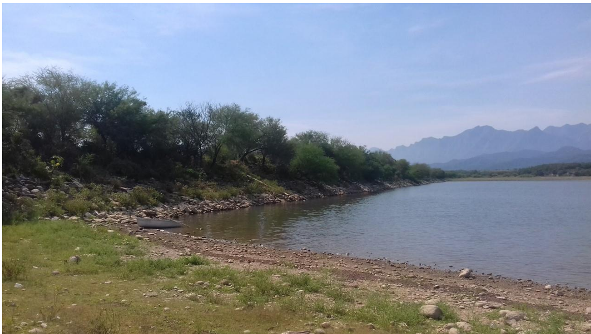
Fotografía VI.2 La cortina de la presa La Estrella.
