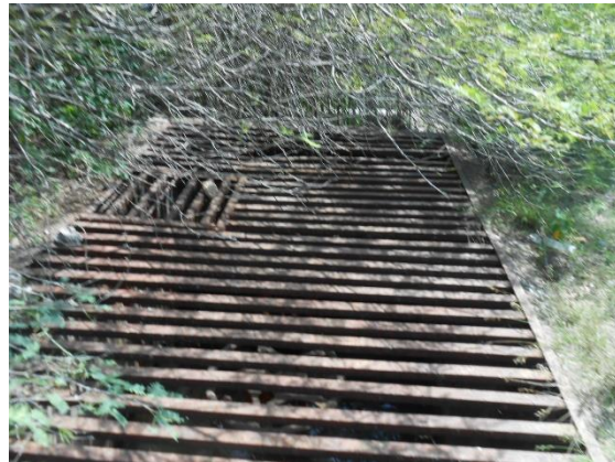
Fotografía II.43 Caja de válvulas de la obra de toma.
