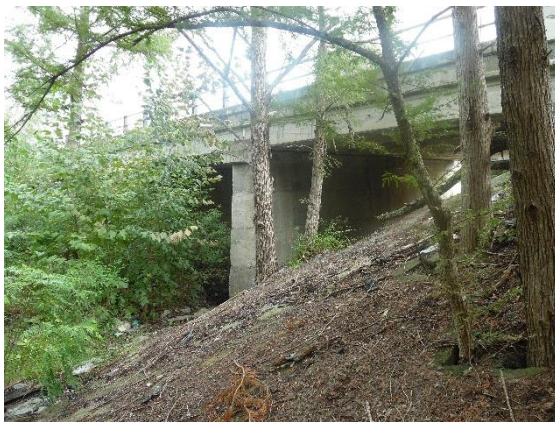
Fotografía VII.22 Cruce del arroyo El Chocolate bajo el puente del mismo nombre.
