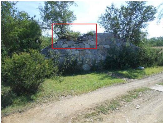
Fotografía VII.2 Muro izquierdo, que soporta la cortina.
