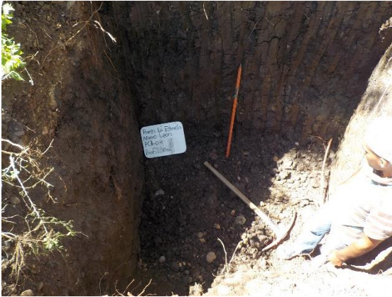
Fotografía III.20 Excavación del PCA-4 en el talud aguas abajo.
