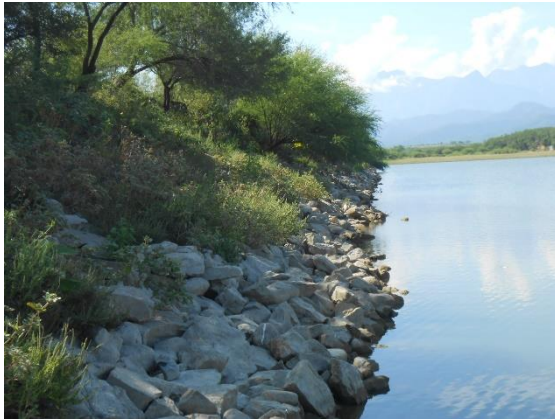
Fotografía II.12 Aspecto del enrocamiento de protección del talud aguas arriba.
