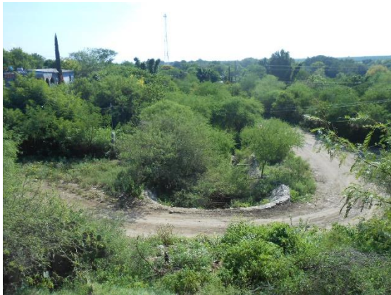
Fotografía II.42 Estructura de salida de la obra de toma, desde la corona de la presa.
