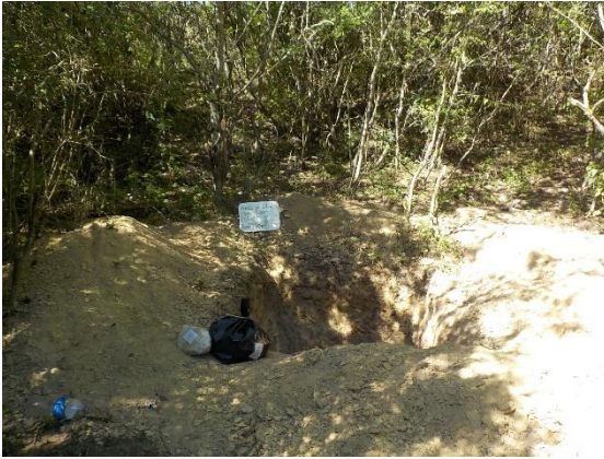
Fotografía III.18 Excavación del PCA-3 en el terreno de cimentación.
