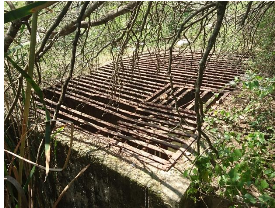
Fotografía III.5 Levantamiento topográfico de la obra de toma.
