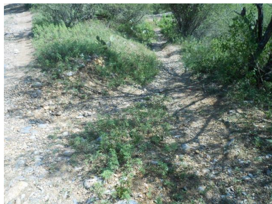
Fotografía II.23 Corte sobre el talud aguas abajo, para el paso de personas.
