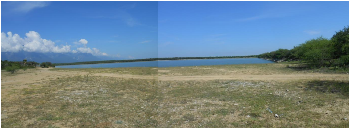
Fotografía VII.1 Panorámica del vertedor tipo lavadero.
