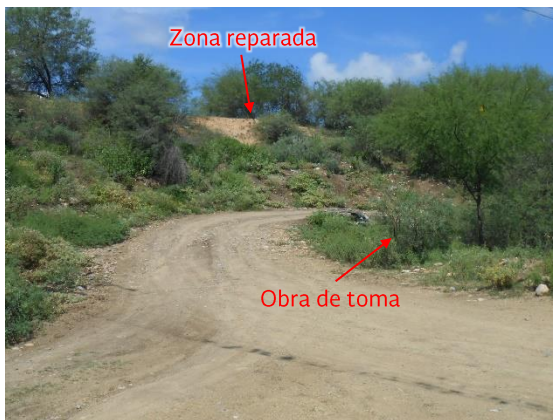
Fotografía II.28 Aspecto actual del talud aguas abajo en la zona reparada.
