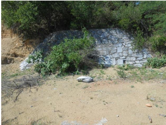
Fotografía II.40 Panorámica del muro izquierdo del vertedor.
