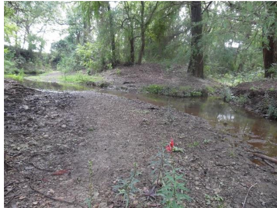
Fotografía II.51 Cauce aguas abajo en el cadenamiento 3+730, ejido El Brasil.
