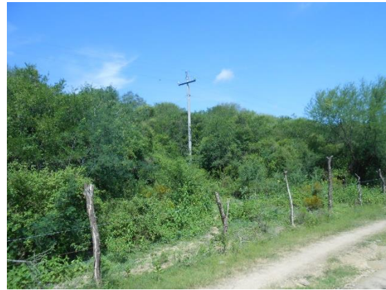
Fotografía II.17 Postes del tendido eléctrico sobre el talud aguas arriba.
