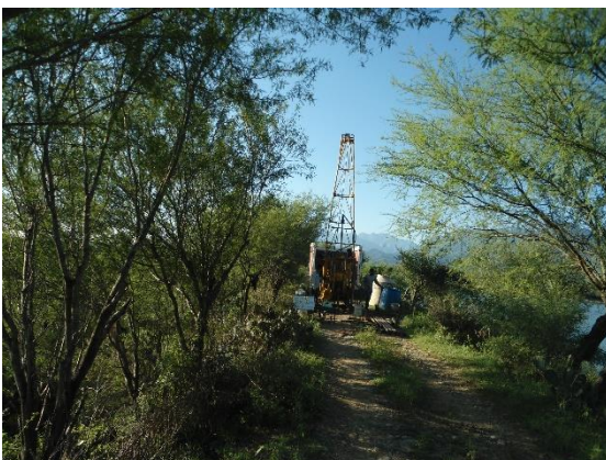
Fotografía III.28 Perforación del SPT-02 en la sección central de la cortina.
