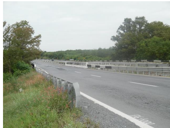
Fotografía VII.21 Aspecto del puente El Chocolate sobre el arroyo del mismo nombre.
