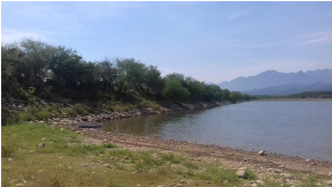
Fotografía VI.1 La cortina de la presa La Estrella.
