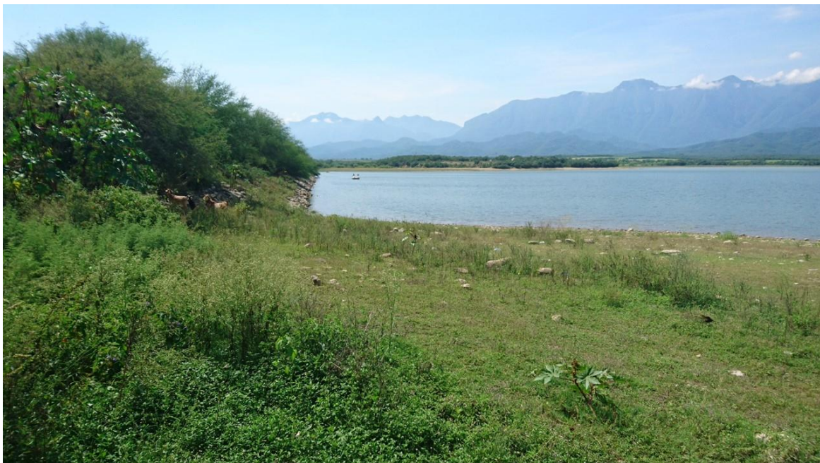
Fotografía VI-1. Aspecto de la cortina.
