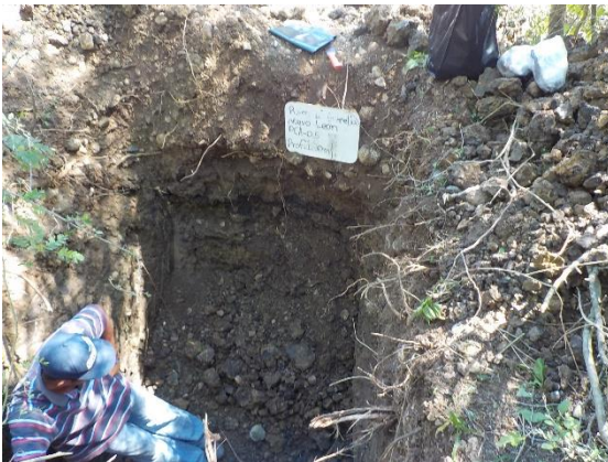
Fotografía III.22 Excavación del PCA-5 en el terreno de cimentación.
