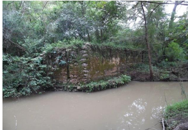
Fotografía III.11 Cadenamiento 3+089, antiguo dique de mampostería para riego.
