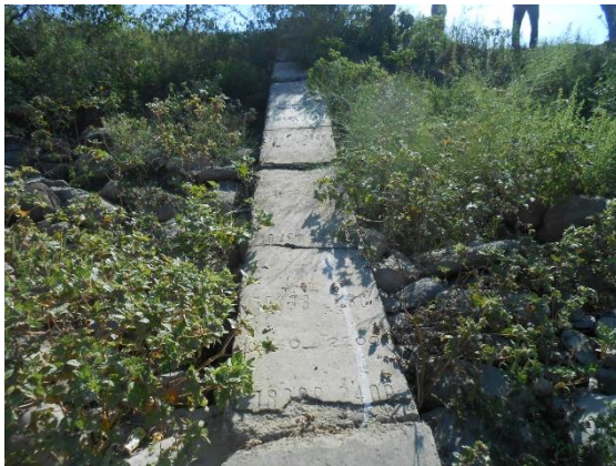
Fotografía II.14 Escala sobre el taludaguas arriba para medir el nivel del embalse .
