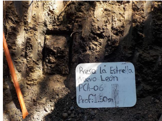
Fotografía III.25 Toma de muestra inalterada de suelo en el PCA-6.
