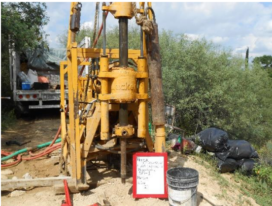
Fotografía III.26 Perforación del SPT-01 en la zona de la falla.
