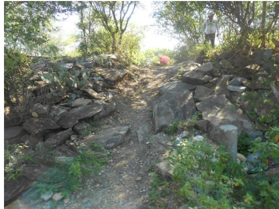
Fotografía II.13 Camino sobre el taludaguas arriba, en donde se ha quitado el enrocamiento.
