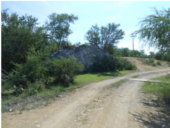
Fotografía II.38 Panorámica del muro izquierdo del vertedor.
