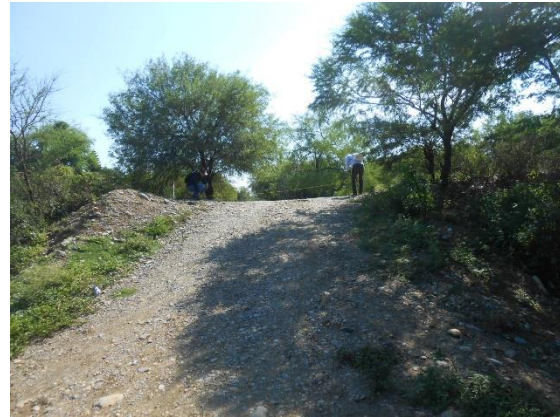
Fotografía II.25 Aspecto del talud aguas arriba por donde bajan los autos al embalse.
