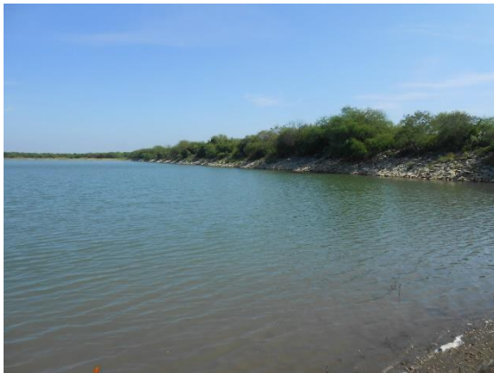
Fotografía II.6 Panorámica de la presa desde margen derecha.
