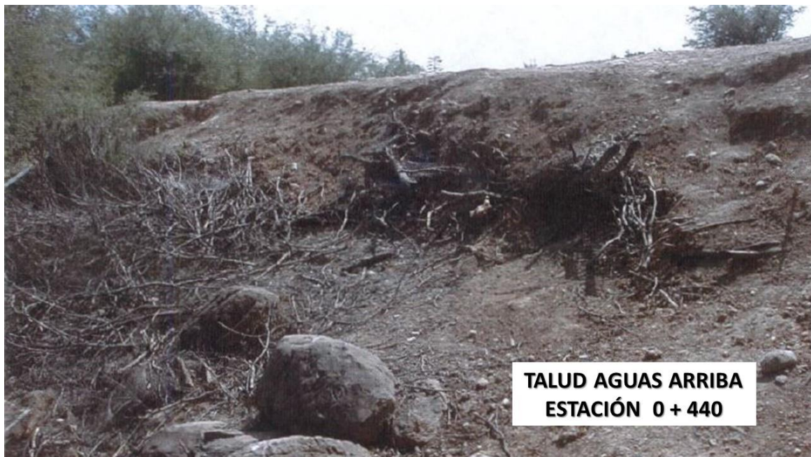
Fotografía VI-5. Vista del talud aguas arriba en la estación 0+440 en 20111.
