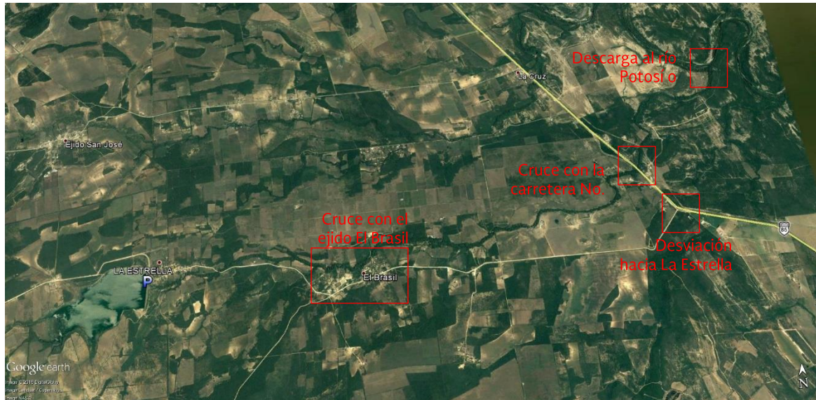
Figura VII.3 Panorámica del acceso a la presa y del cauce aguas abajo.
