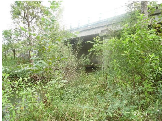
Fotografía II.49 Puente El Chocolate en el cadenamiento 1+450.
