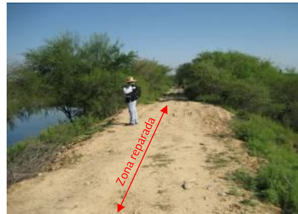
Fotografía II.27 Aspecto de la corona en la zona reparada, foto del 2010.
