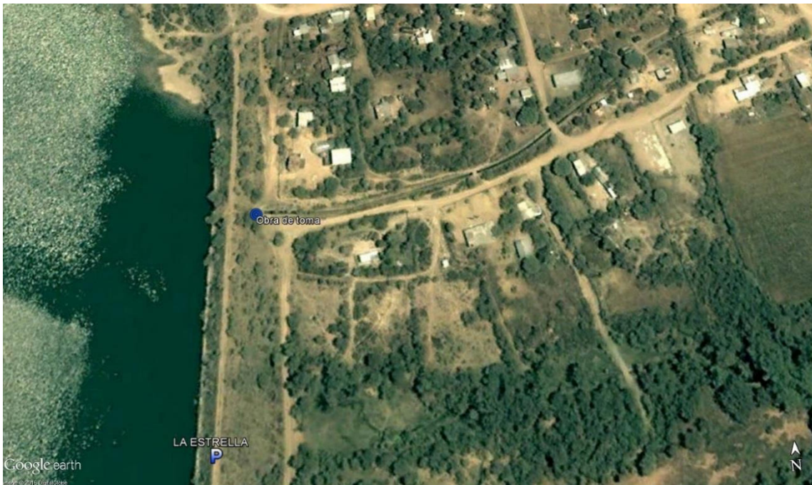
Figura VII.2 Ubicación de la obra de toma de la presa La Estrella.
