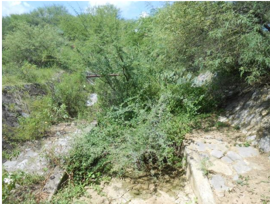
Fotografía II.46 Canal de distribución aguas abajo de la caja de válvulas.
