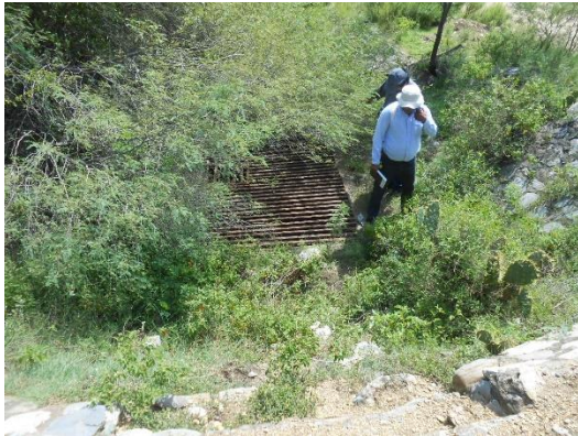
Fotografía VII.10 Caja de válvulas de la obra de toma.
