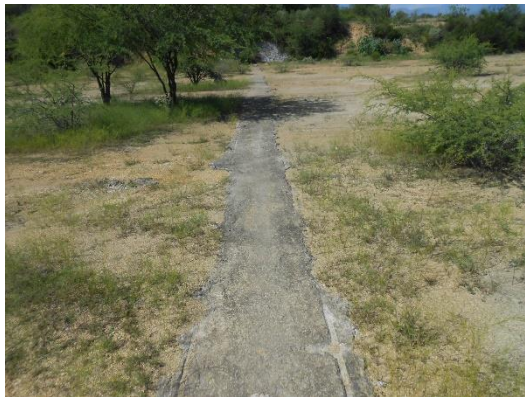
Fotografía VII.6 Espigón de concreto en la sección de control.
