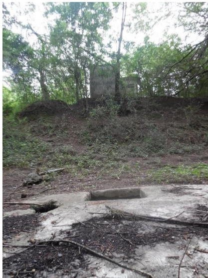
Fotografía III.12 Cadenamiento 3+189, obra de captación.
