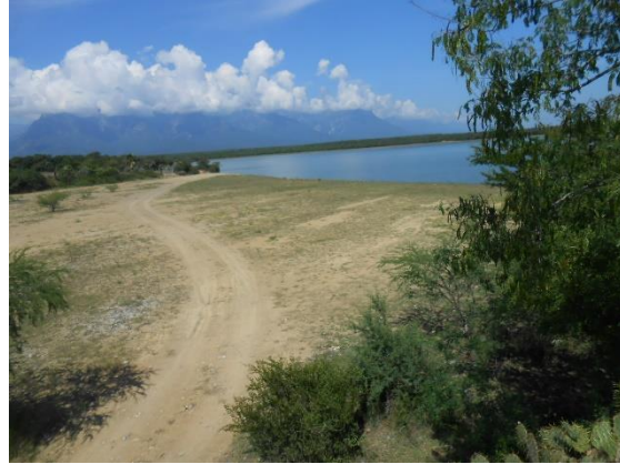
Fotografía II.33 Canal de llamada del vertedor.
