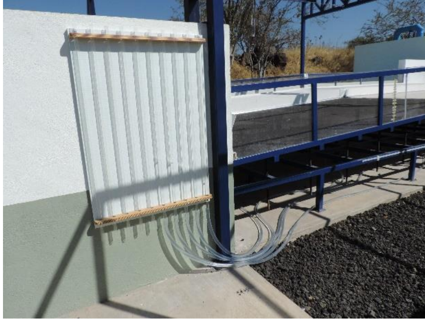
Figura III.55 Habilitado de piezómetro para medición de tirantes.
