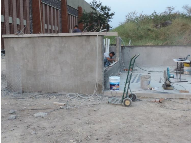
Figura III.35 Emboquillado en muros de canal.
