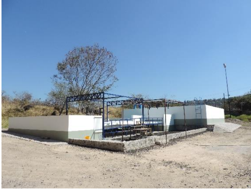
Figura III.57 Módulo de una calle terminado.
