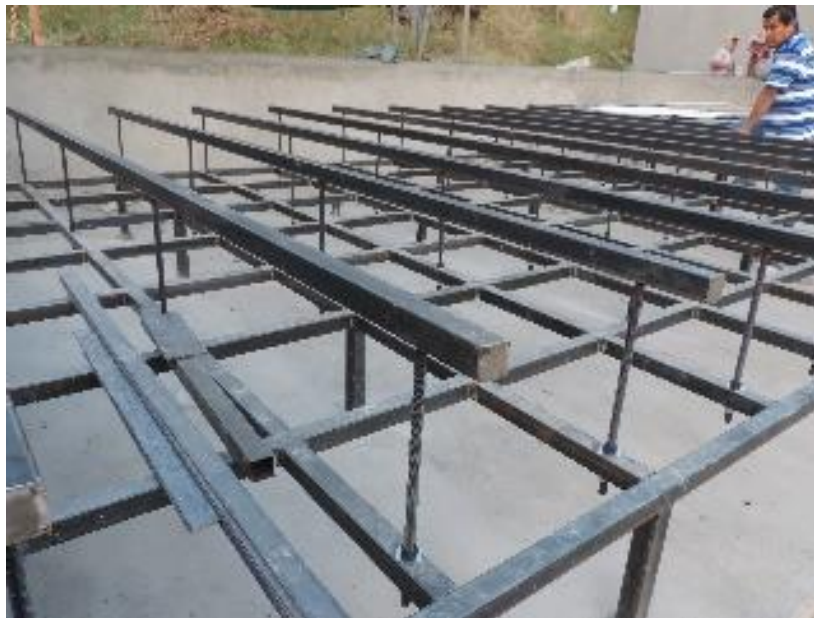
Figura III.40 Colocación de estructura de soporte móvil.
