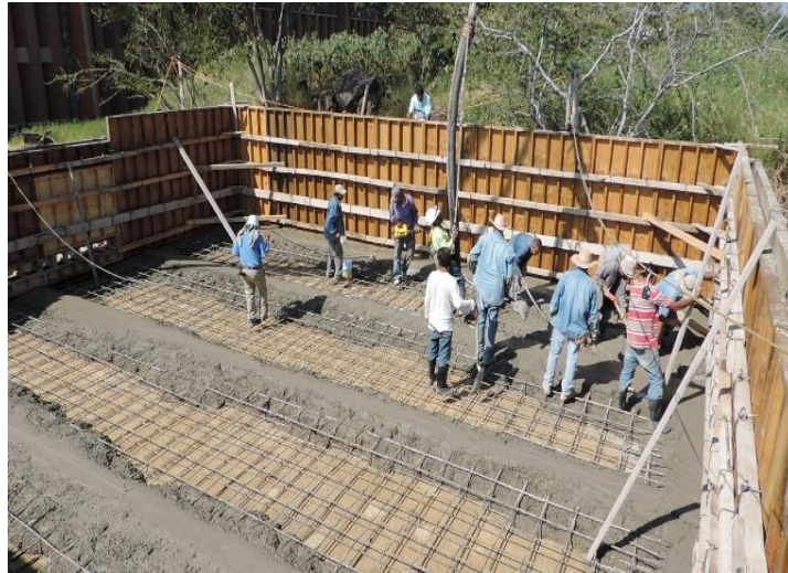
Figura III.23 Esparcimiento de concreto para el firme del tanque de almacenamiento.
