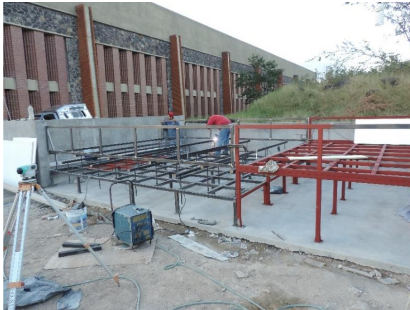
Figura III.42 Soldadura de estructura de soporte lateral.
