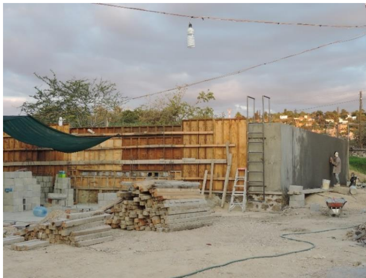
Figura III.28 acabado de muros en tanque de almacenamiento.
