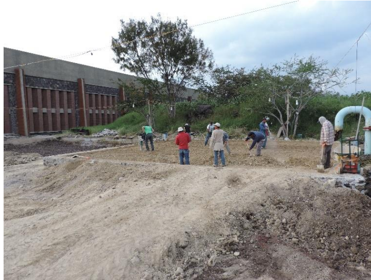
Figura III.17 Compactación del terreno de desplante del tanque de almacenamiento.
