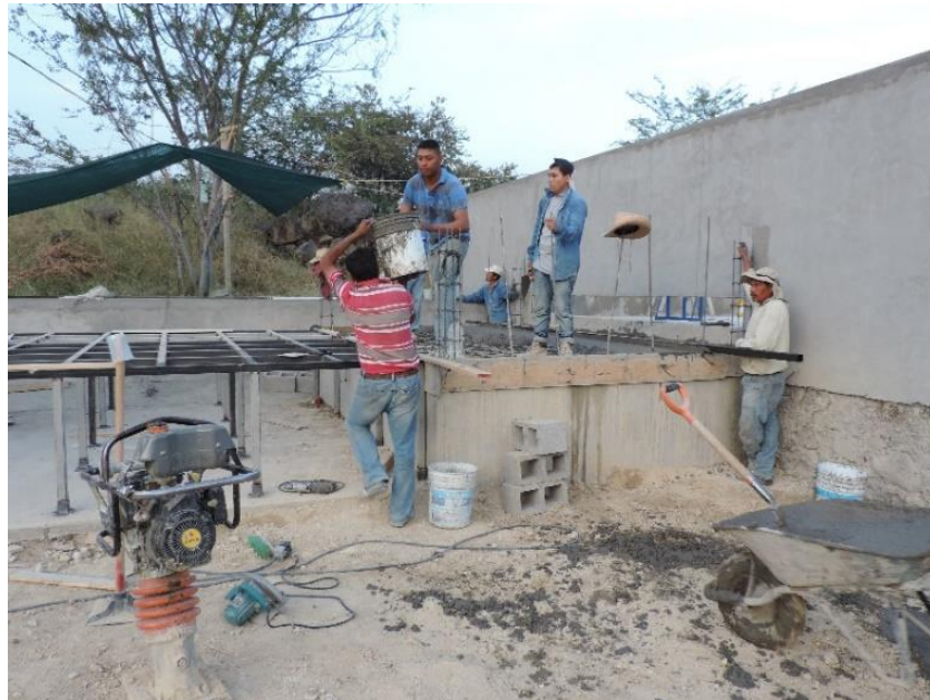
Figura III.38 Colado de firme en tanque amortiguador.
