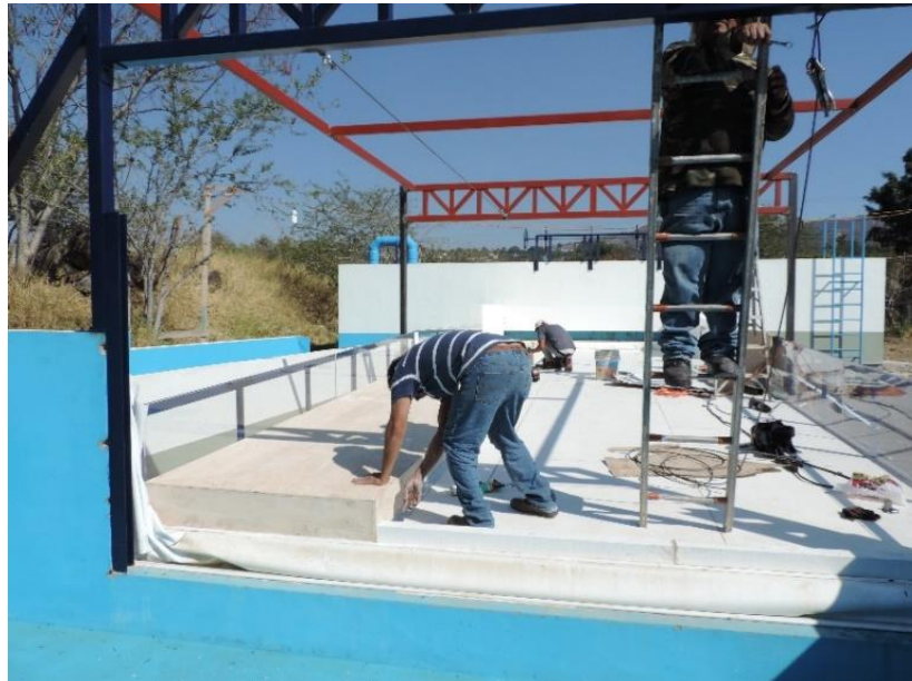
Figura III.54 Colocación de la banqueta.
