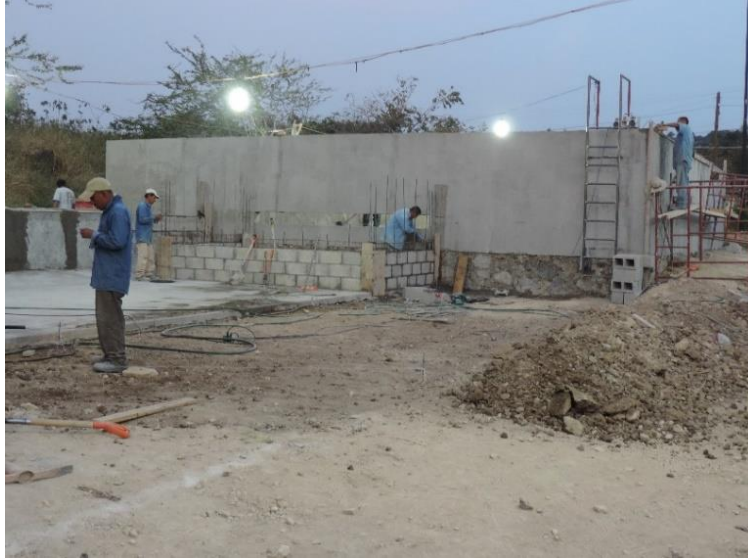
Figura III.29 Construcción de tanque amortiguador.
