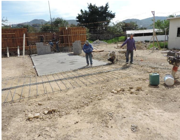
Figura III.22 Armado del firme para el canal.
