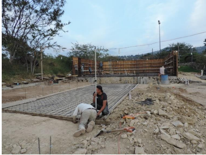
Figura III.21 Armado del firme de concreto para el tanque amortiguador, transición y calle.
