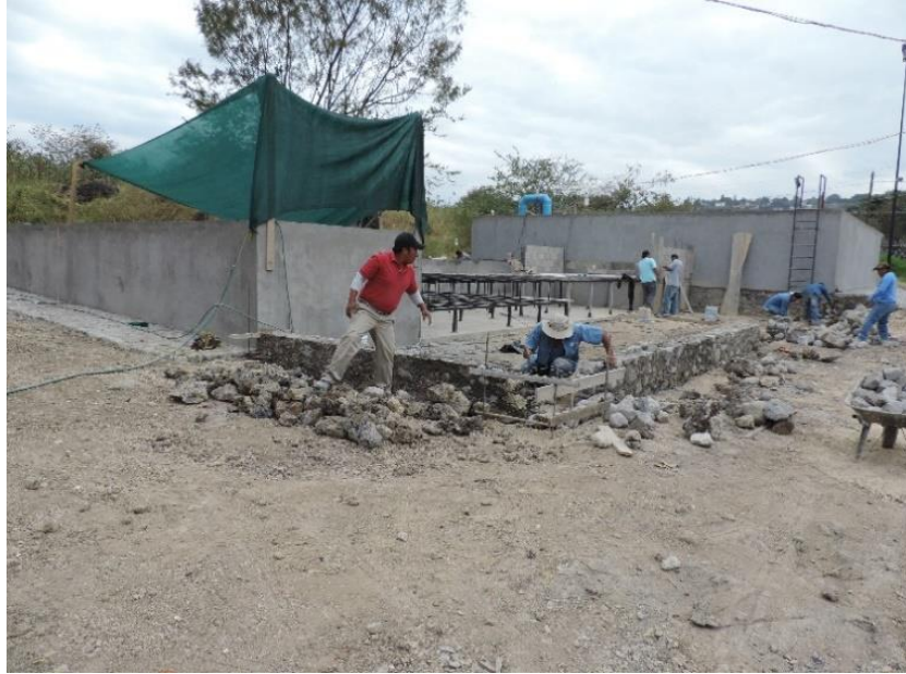
Figura III.41 Construcción de muro de mampostería.
