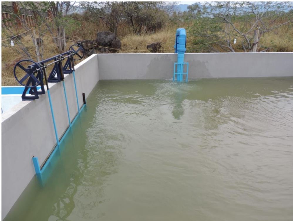
Figura IV.1 ensayo preliminar del tanque de almacenamiento.
