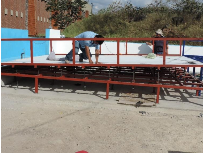
Figura III.49 Colocación de triplay en calle y transición.
