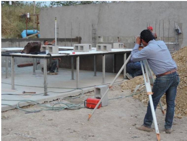
Figura III.34 Colocación de estructura de soporte de la transición.
