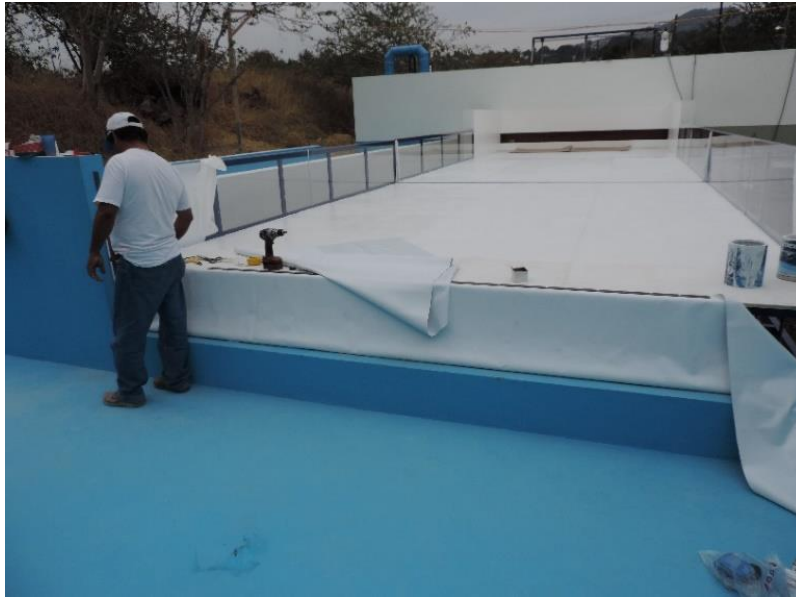
Figura III.51 Colocar lo de lona para entrada al canal de salida.
