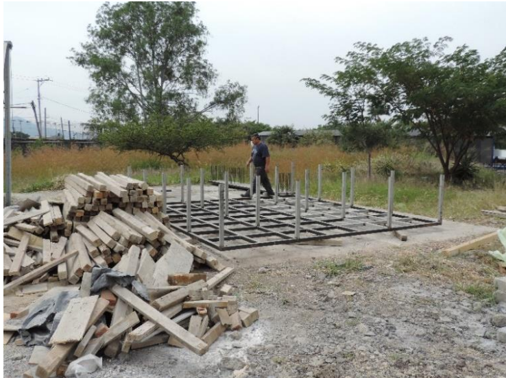
Figura III.32 Armado de estructura de soporte a base de PTR.
