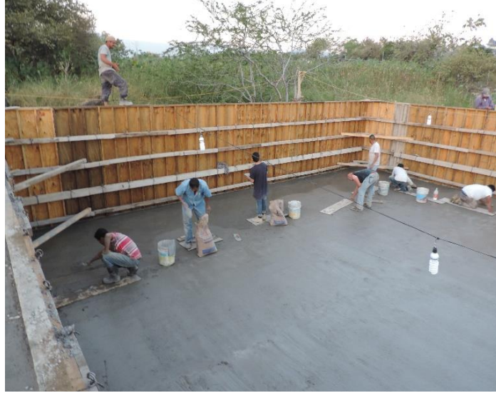
Figura III.25 Pulido del firme del tanque de almacenamiento.
