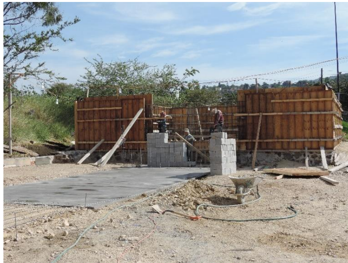
Figura III.20 Cimbrado del tanque de almacenamiento.
