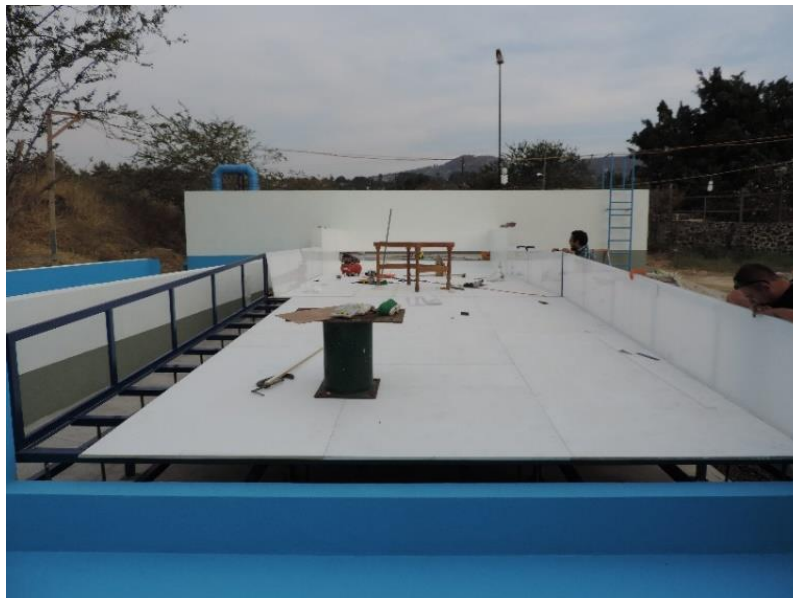
Figura III.50 Colocación de muro de acrílico transparente en el módulo.
