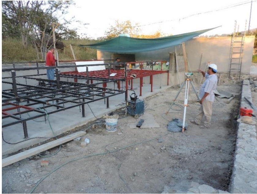
Figura III.43 Colocación y nivelación de la estructura de soporte lateral.
