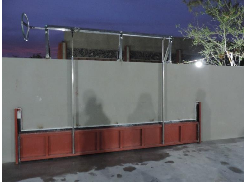
Figura III.53 Habilitado de la compuerta terminado.
