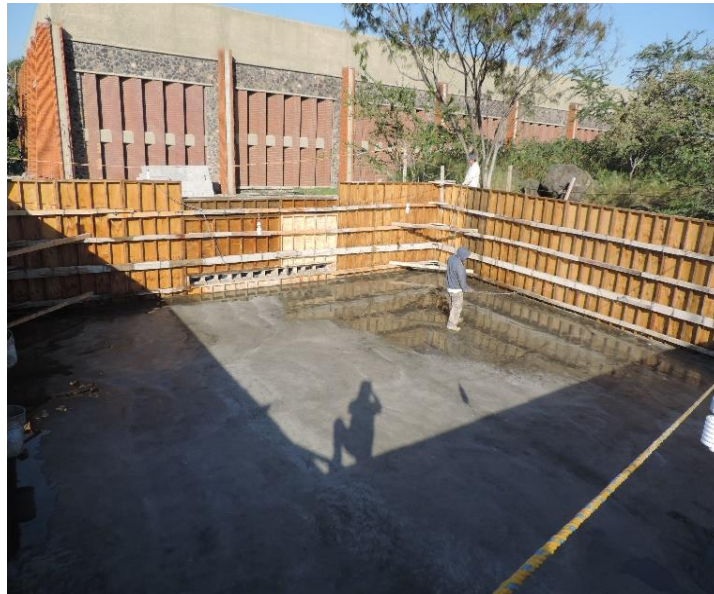
Figura III.26 Hidratación del concreto del tanque de almacenamiento.
