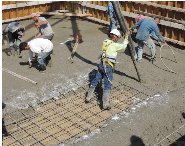
Figura III.24 Trabajador de Cemex realizando el colado del tanque de almacenamiento.
