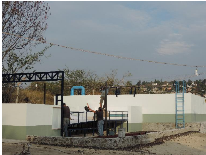
Figura III.56 Colocación de estructura de soporte y guías para línea de vida.
