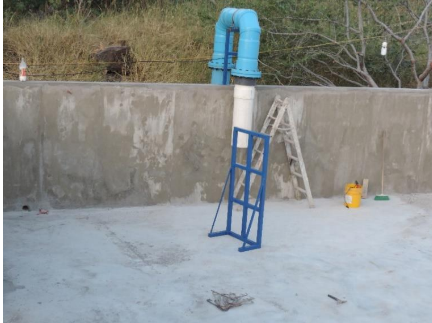
Figura III.39 Habilitado de estructura de soporte de la tubería de alimentación y adaptación en PVC.
