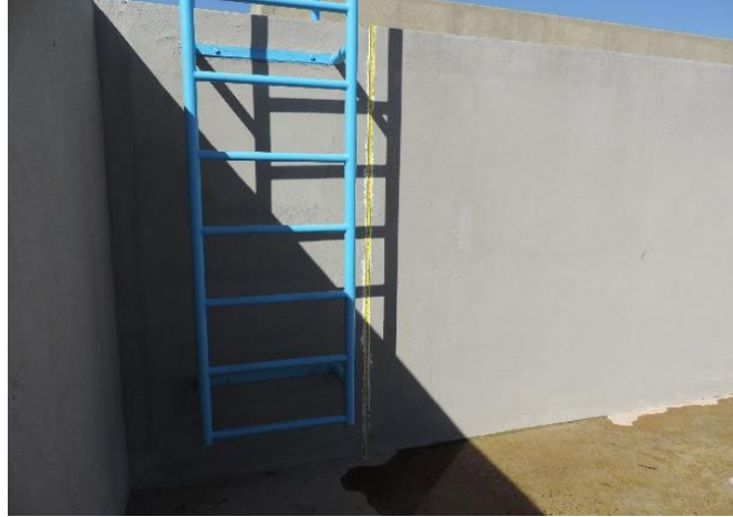
Figura V.4 limnmetro instalado en el tanque de almacenamiento.
