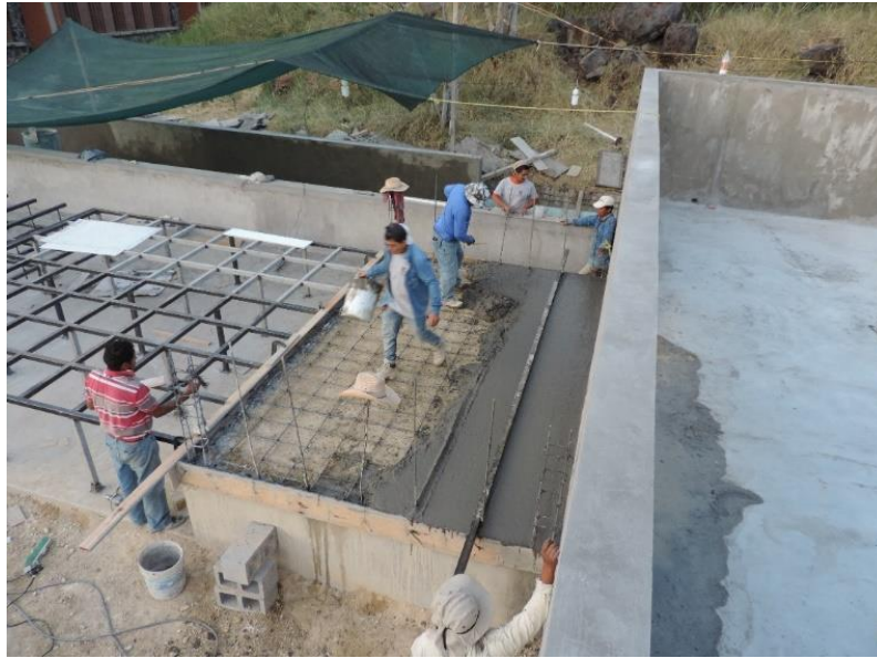
Figura III.37 Armado de firme de concreto de tanque amortiguador.
