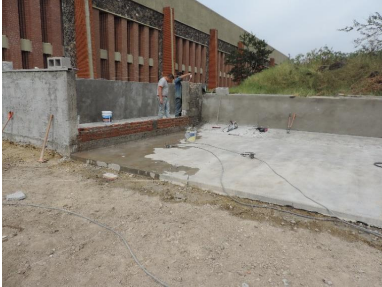
Figura III.31 Nivelación de muros del canal de aforo.
