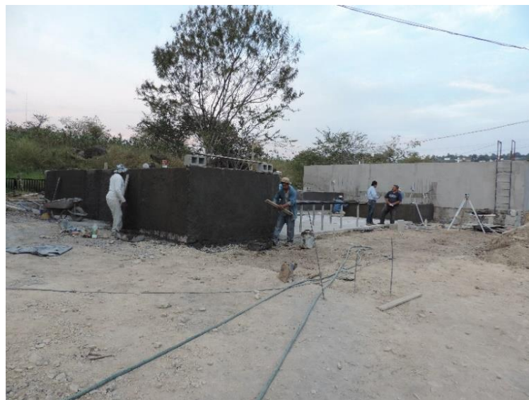
Figura III.30 Repellado de los muros del canal de aforo.
