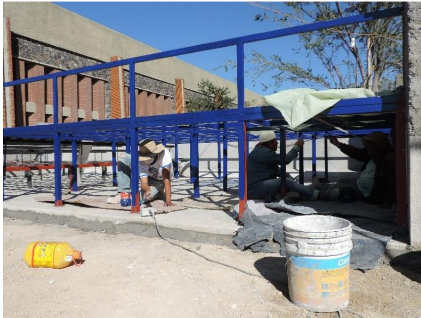
Figura III.44 Pintura en estructura de soporte.
