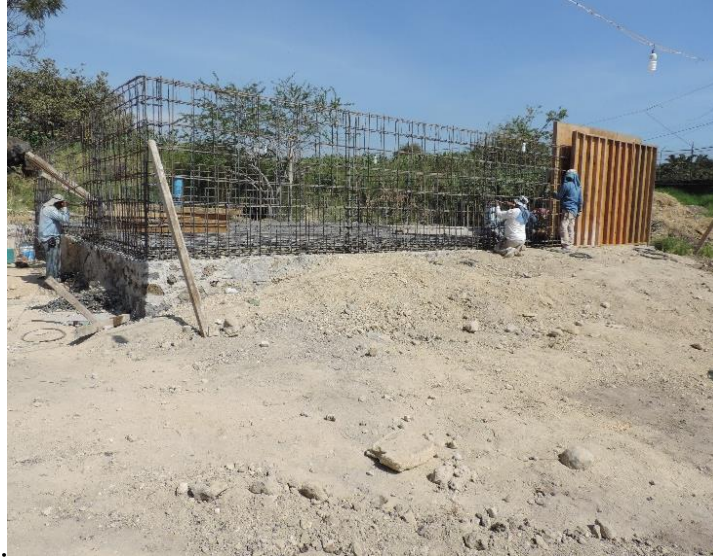
Figura III.19 Cimbrado del tanque del almacenamiento.
