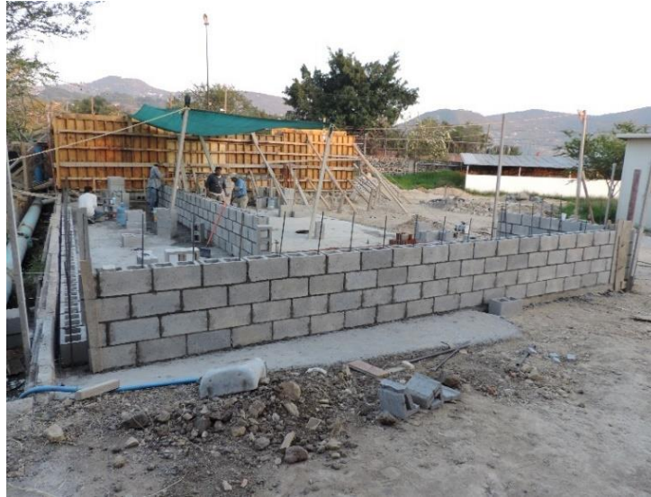
Figura III.27 Construcción de muros del canal aforador.
