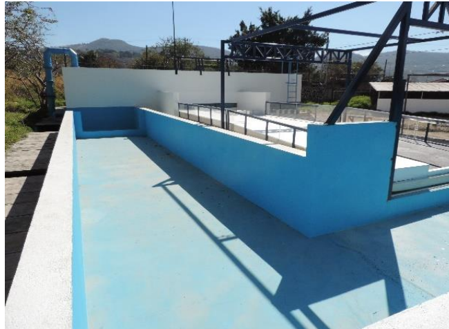
Figura V.6 Vertedor de pared delgada.
