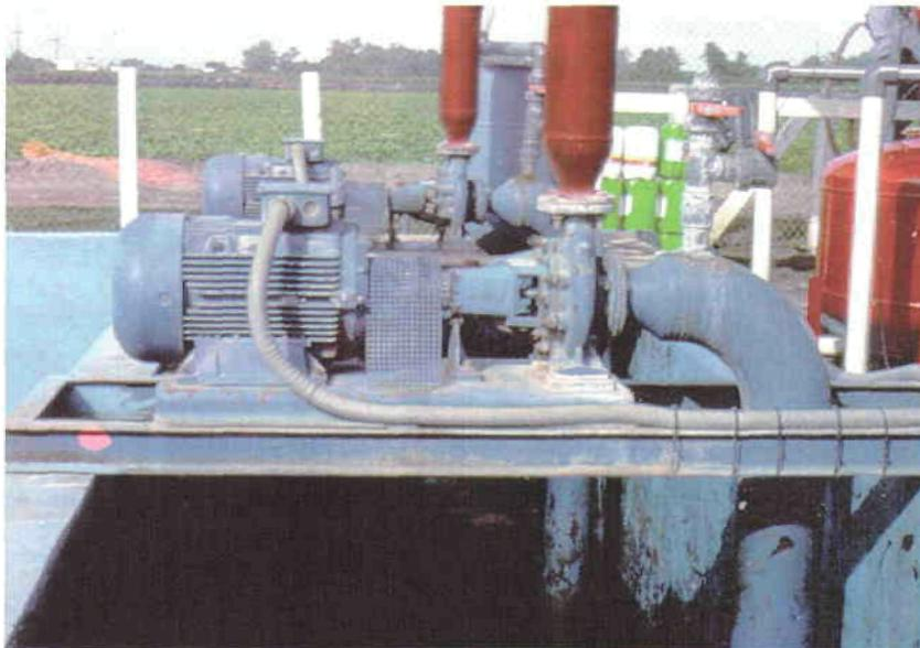
*Lámina 40 Bomba propulsada por un motor eléctrico*
