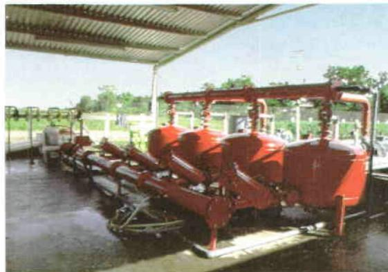
*Lámina 47 Filtros de grava y de mallas para agua de un canal o de un río*
