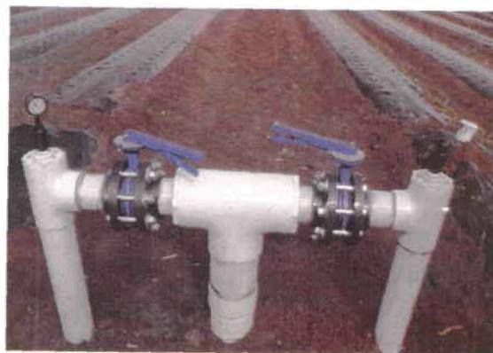
*Lámina 45 Unidad de control de una sección de riego*
