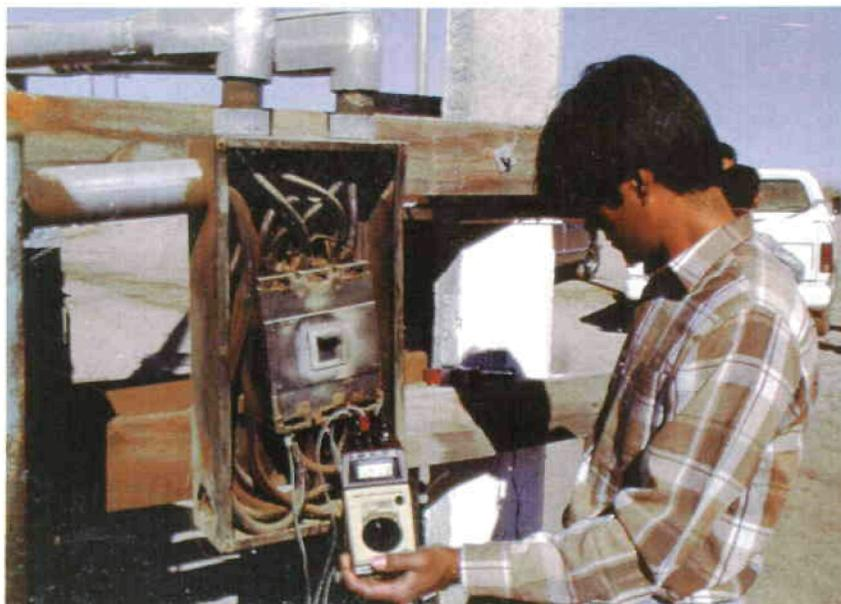
*Lámina 26 Medición del consumo de energía de un equipo de bombeo*
