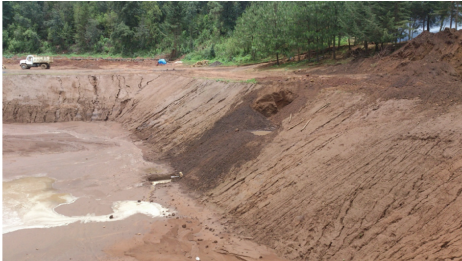
Ilustración 7. Excavación para formar la hoya y taludes.
