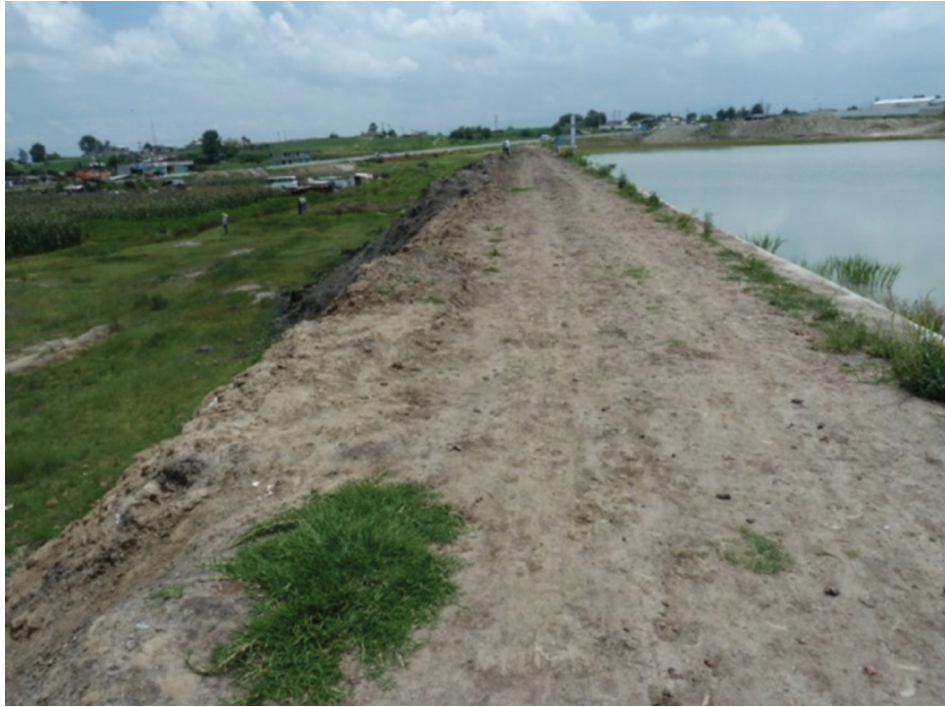
Ilustración 2. Cortina de la presa San Juan de las Manzanas.
