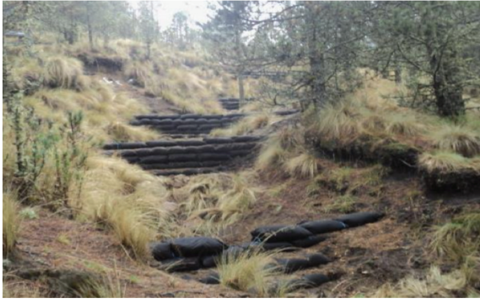
Ilustración 4. Represas de geocostal establecidas en la subcuenca Tejalpa-Terrerillos.
