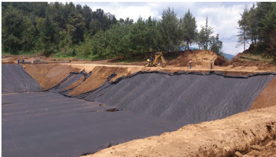
Ilustración 8. Tendido de geotextil para reforzar taludes y fondo de hoya.
