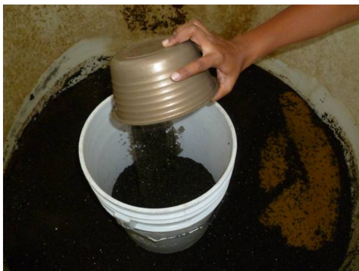
Foto 5.8 Retiro de la primera capa de material filtrante
