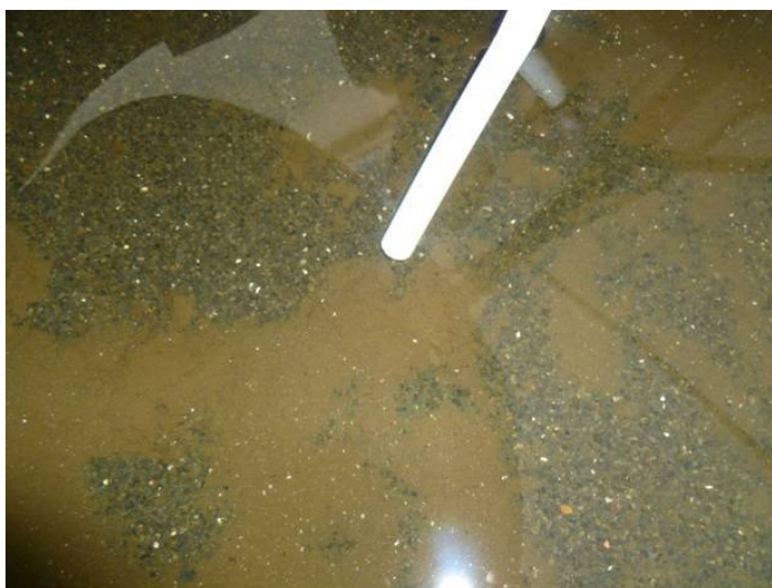
Foto 5.7 Retiro de sólidos por sifón
