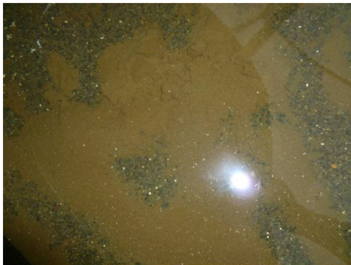
Foto 5.6 Acumulación de sólidos sobre el lecho de filtración
