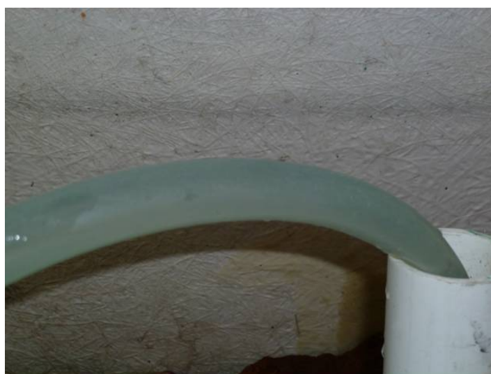
Foto 5.5 Descarga de agua a desagüe
