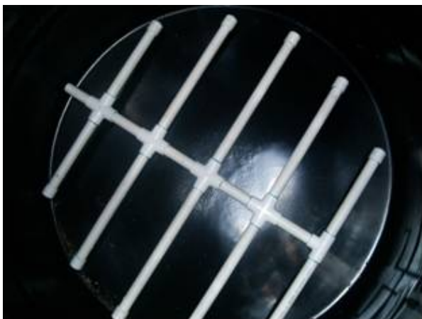
Foto 5.2 Ramal de distribución de agua en el interior del filtro
