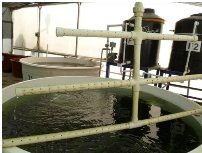
Foto 5.4 Ramal de succión de tanques
