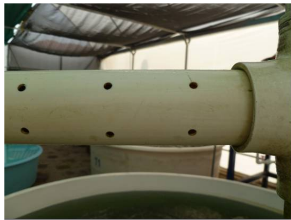
Foto 5.3 Distribución de orificios en el ramal
