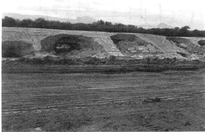
Figura 12.2 Vista de los conductos después de la falla de la presa La Escondida, Tamaulipas.
