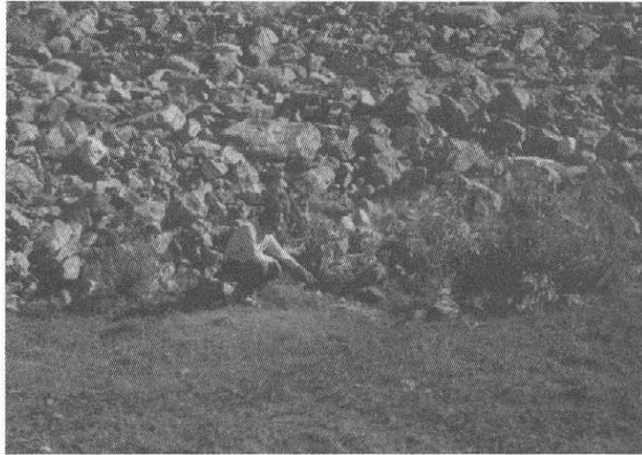
Figura 12.5 Filtraciones en la rampa y pie de la cortina en la presa El Molinito, Sonora.
