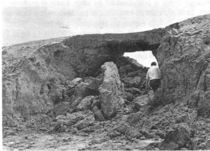
Figura 12.3 Detalle de uno de los conductos observados de la presa La Escondida, Tamaulipas.
