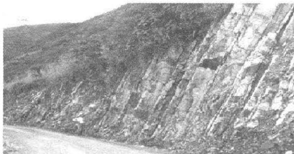
Figura 6.22 Planos de estratificación con buzamiento hacia la excavación.
