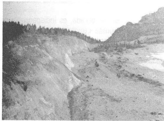
Figura 1.8 La frontera de la falla del macizo rocoso en la ladera derecha, la cual coincide con una zona tectónica preexistente; foto del año 1963.
