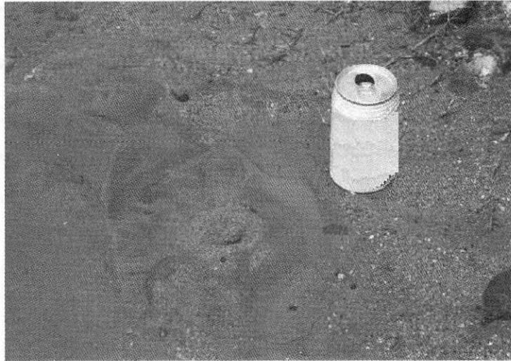
Figura 12.7 Filtración vertical ascendente al pie de la cortina, presa El Molinito, Sonora.
