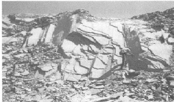
Figura 6.11 Lutitas alteradas con estratificación buzando hacia la excavación.
