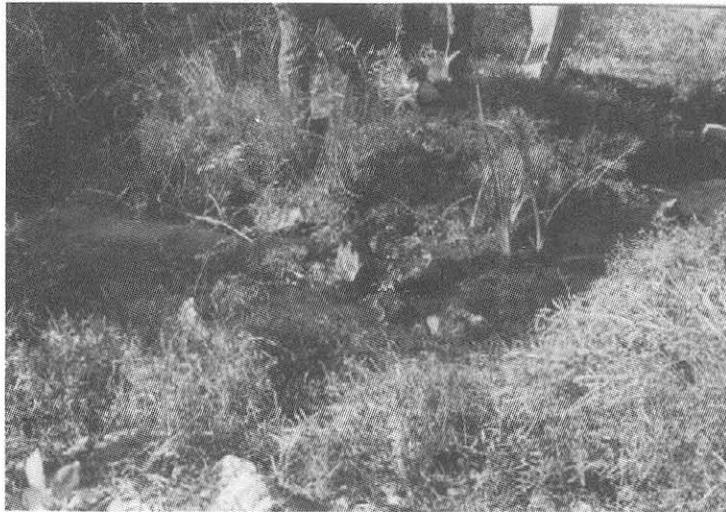
Figura 12.6 Filtraciones a 3 m aguas abajo del pie de la cortina, El Molinito, Sonora.
