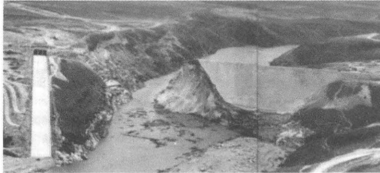
Figura 1.16 La presa Teton después de la falla.
