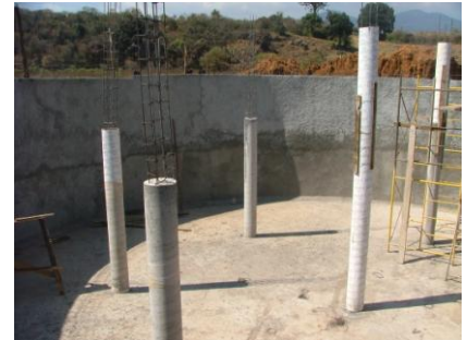
Colado de castillos internos
