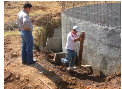
Relleno y apisonamiento de tierra
