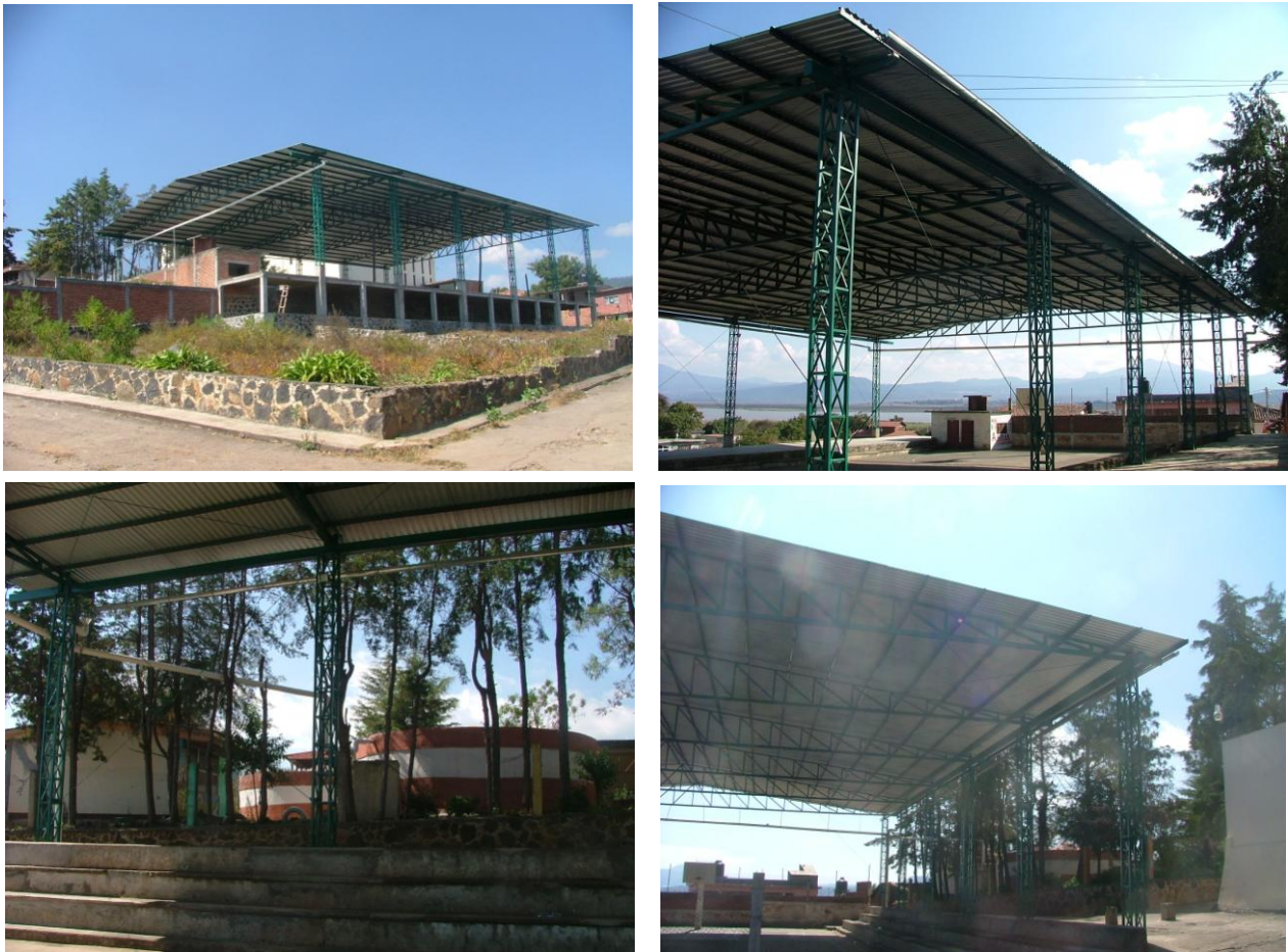
Ilustración 15. Sistema de captación y conducción de agua de lluvia (Napizaro)
