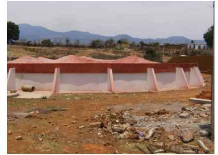
Cisterna techada y pintada
