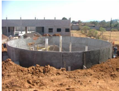
Repellado de muro parte alta
