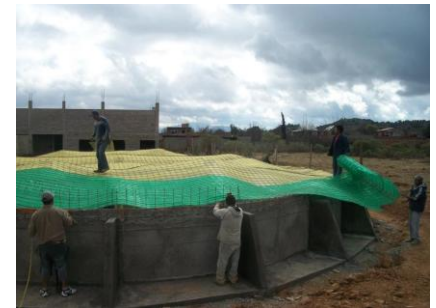
Montaje de cimbra para techado
