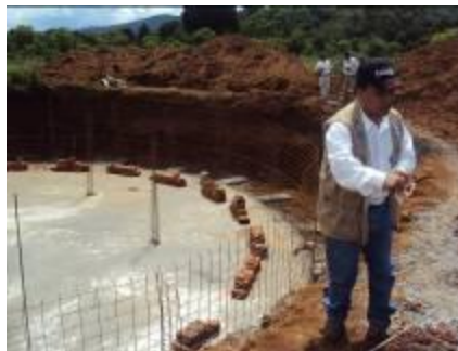
Colado del fondo de la cisterna
