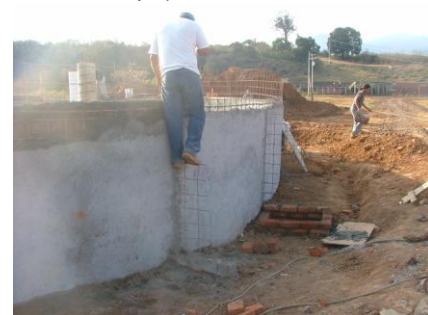
Colado de contrarefuertos
