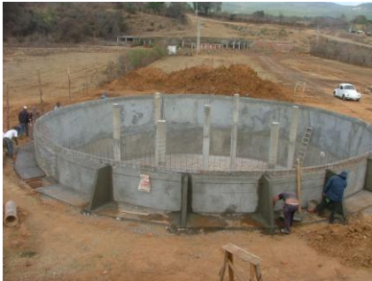
Cuerpo de cisterna listo para el techado
