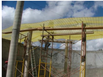
Montaje de cimbra para techado
