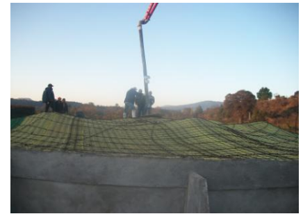
Colado del techado
