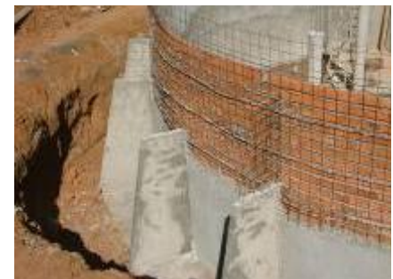
Colado de contrarefueros
