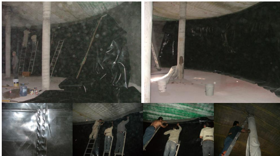
Ilustración 27. Geomembrana en cisterna de la comunidad de San Francisco Úricho
