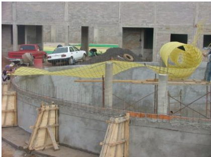
Montaje de cimbra para techado
