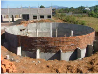
Levantamiento y colado
