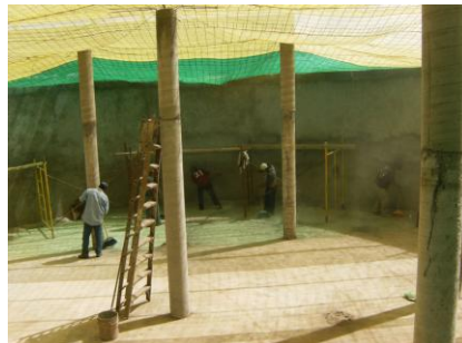
Montaje de cimbra para techado
