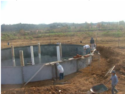
Relleno y apisonamiento de tierra
