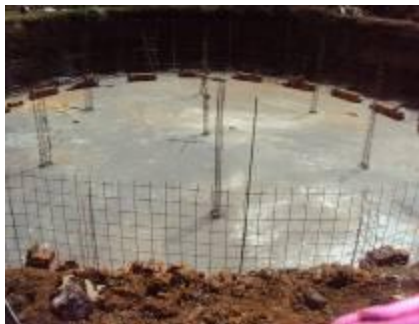
Colado del fondo de la cisterna
