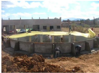
Montaje de cimbra para techado
