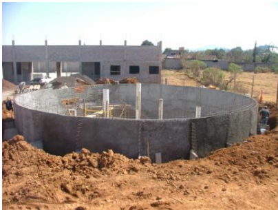
Repellado exterior e interior parte alta
