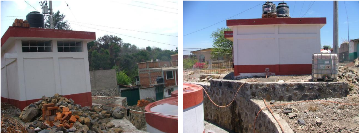
Ilustración 24. Caseta de resguardo del sistema de tratamiento de agua de lluvia (Arocutin)
