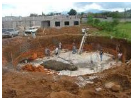
Levantamiento del muro capuchino
