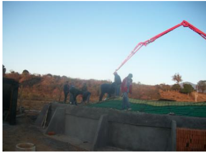
Colado del techado
