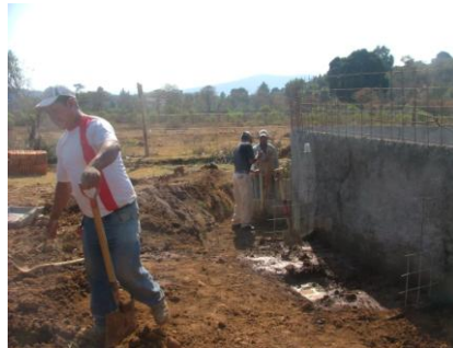
Relleno y apisonamiento de tierra
