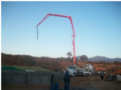
Colado del techado
