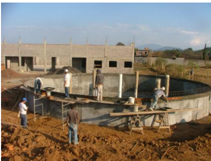
Muro capachunino, relleno y apisonamiento
