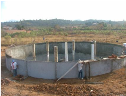
Preparación para colado de contrarefuertos
