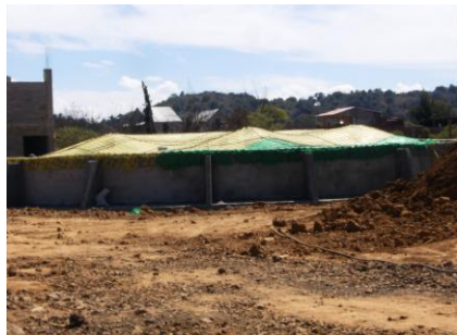
Montaje de cimbra para techado
