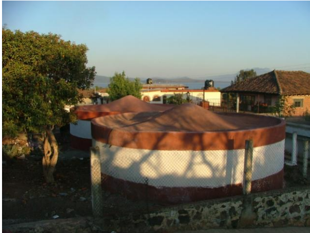
Ilustración 13. Cisterna en los terrenos de la jefatura de tenencia - 200,000 litros de capacidad (Napizaro)
