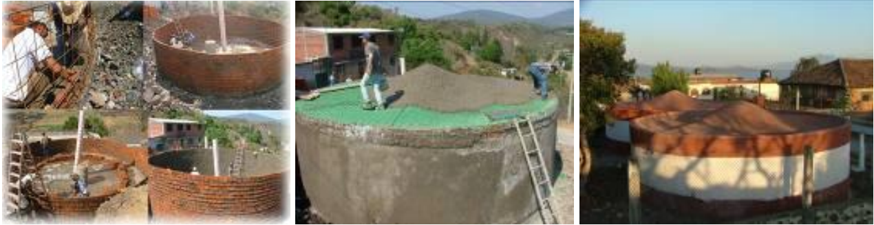
Ilustración 12. Cisterna cilíndrica tipo capuchina de 100,000 litros capacidad
