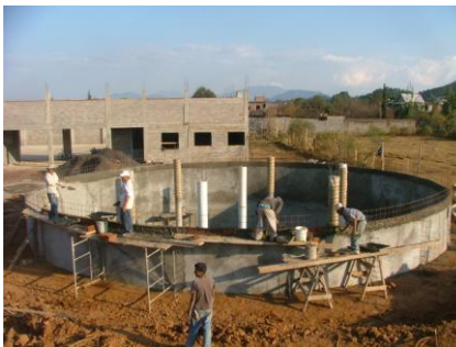
Muro capachunino, relleno y apisonamiento
