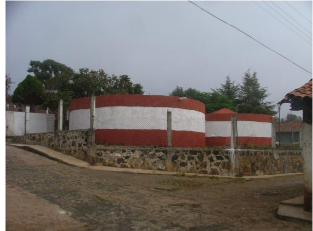
Ilustración 13. Cisterna en los terrenos de la jefatura de tenencia - 200,000 litros de capacidad (Napizaro)
