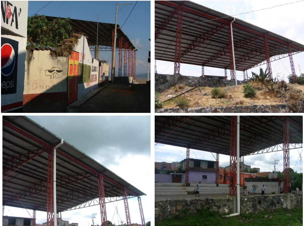
Ilustración 21. Sistema de captación y conducción de agua de lluvia (Arocutin)
