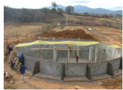
Montaje de cimbra para techado
