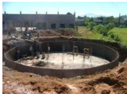
Repellado de exterior e interior
