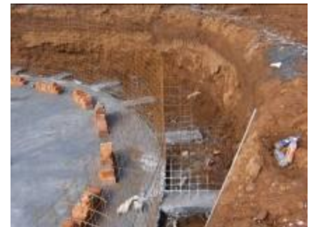
Armado y colado de la base de cisterna
