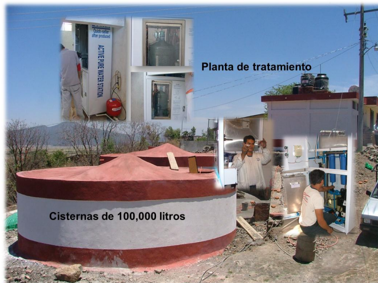
Ilustración 23. Infraestructura y sistema de tratamiento de agua de lluvia (Arocutin)
