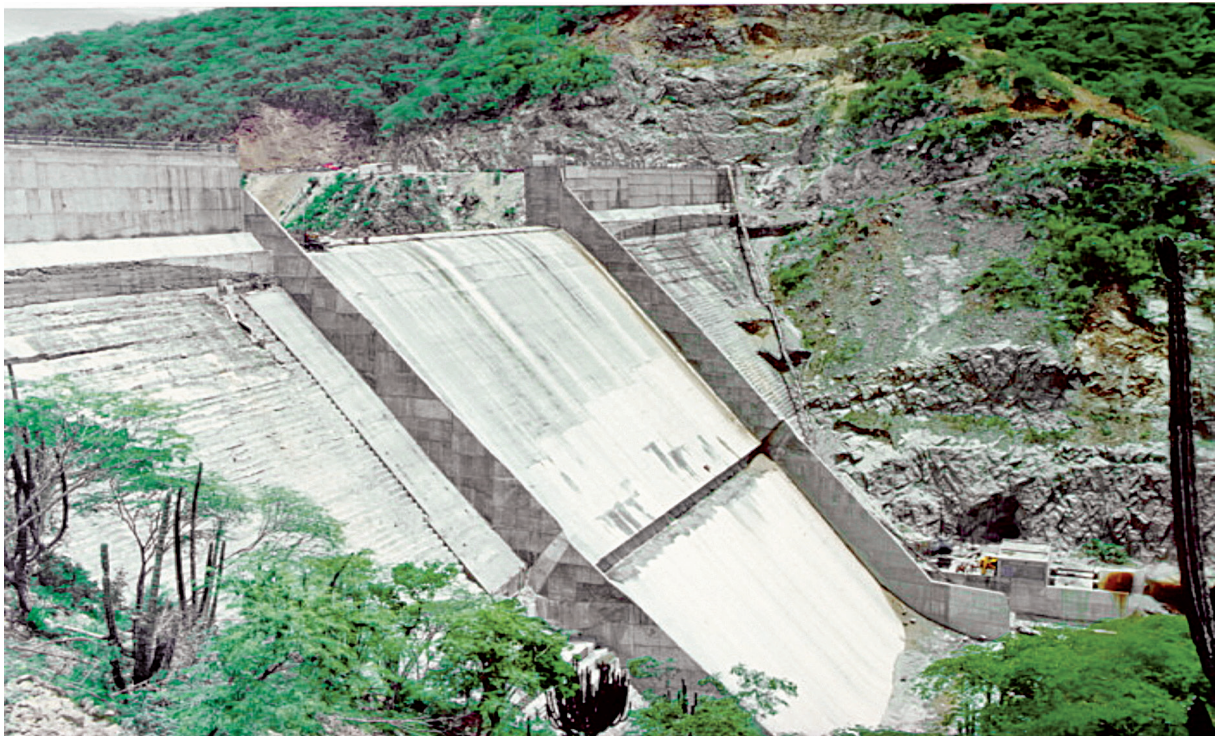
Figura 72. Aerator de la presa Trigomil, México, CONAGUA, 1999.
