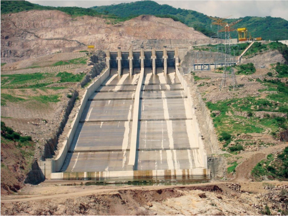
Figura 77. Aereadores de la P.H. el Cajón, CFE, 2005.
