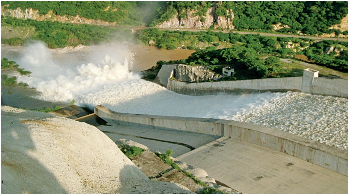
Figura 75. Aereadores de la presa Aguamilpa.
