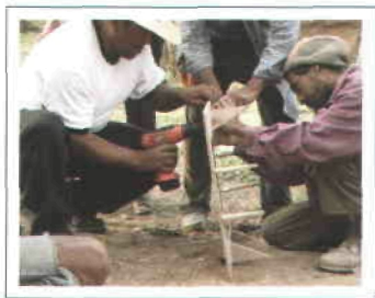
Figura 3. Los ángulos se fijan con pijas.
